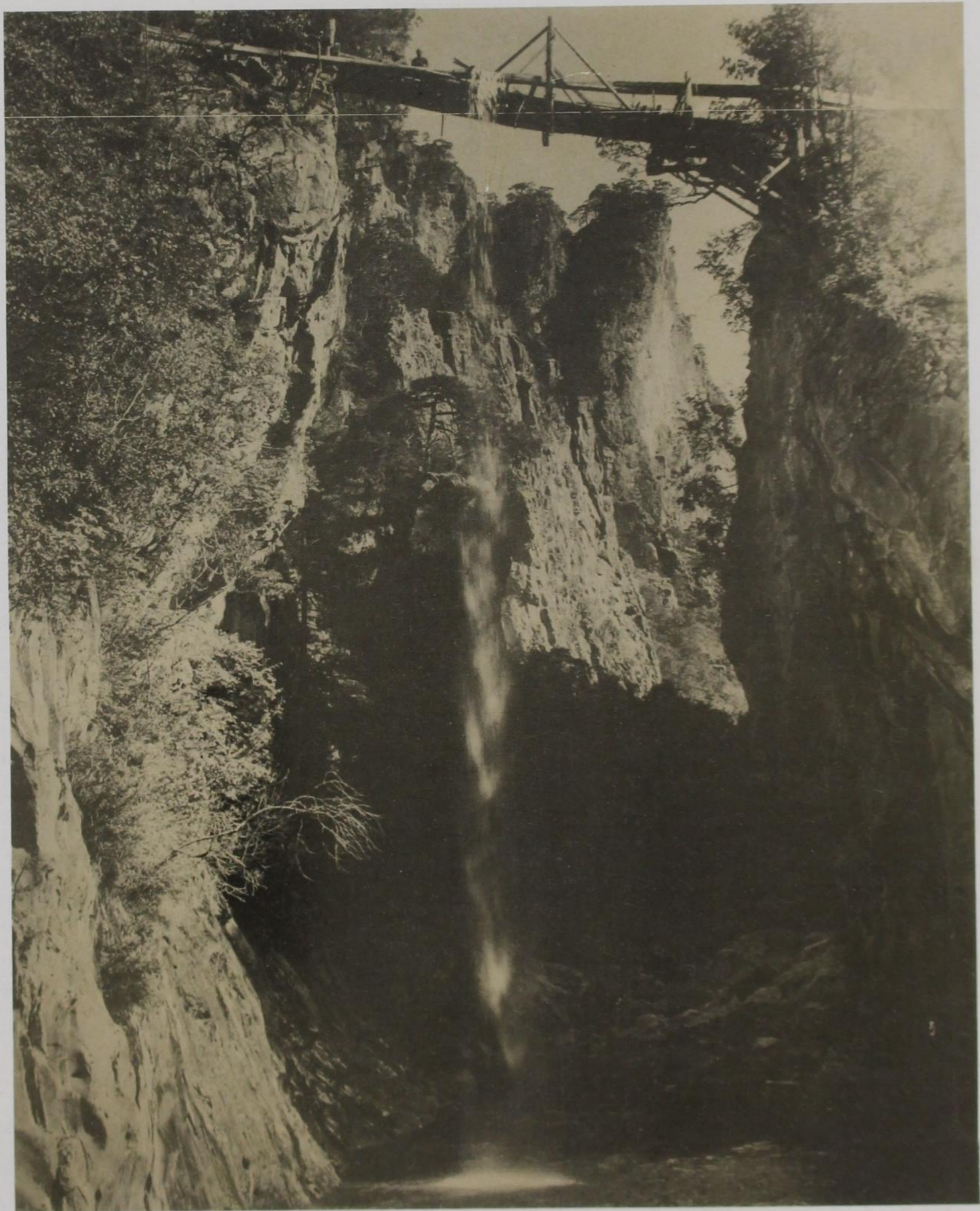
3. Ευλογέφυρο στον Αώο, περιοχή Στομίου, το 1938.
