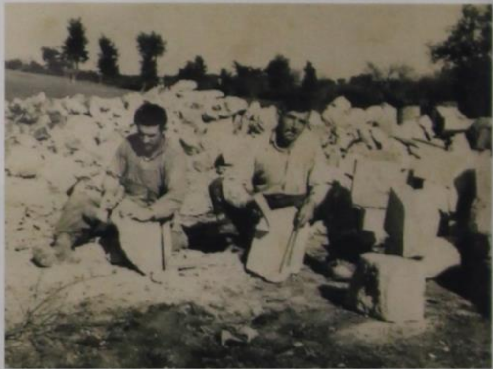
Εικ. 19 Κασσάνδρεια (Βάλτα), 1960. Ο μάστορας Λάμπρος Γαζώνας αριστερά και ο Δημήτρης Μέμτσας πελεκούν αγκωνάρια για την κατασκευή του κοινοτικού αντλιοστασίου.
