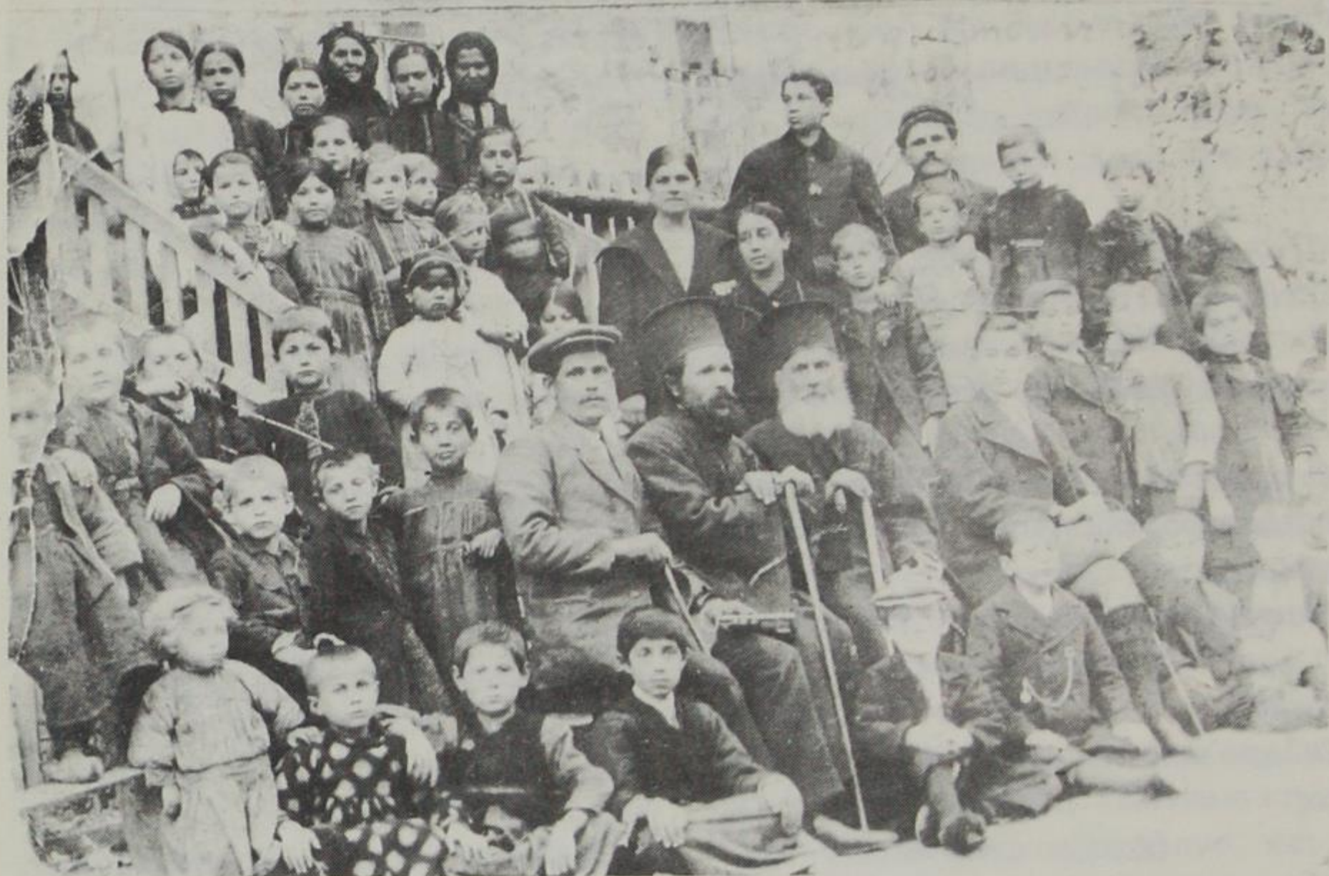
Παλαιosέλι: Δημοτικό Σχολείο 1917.
