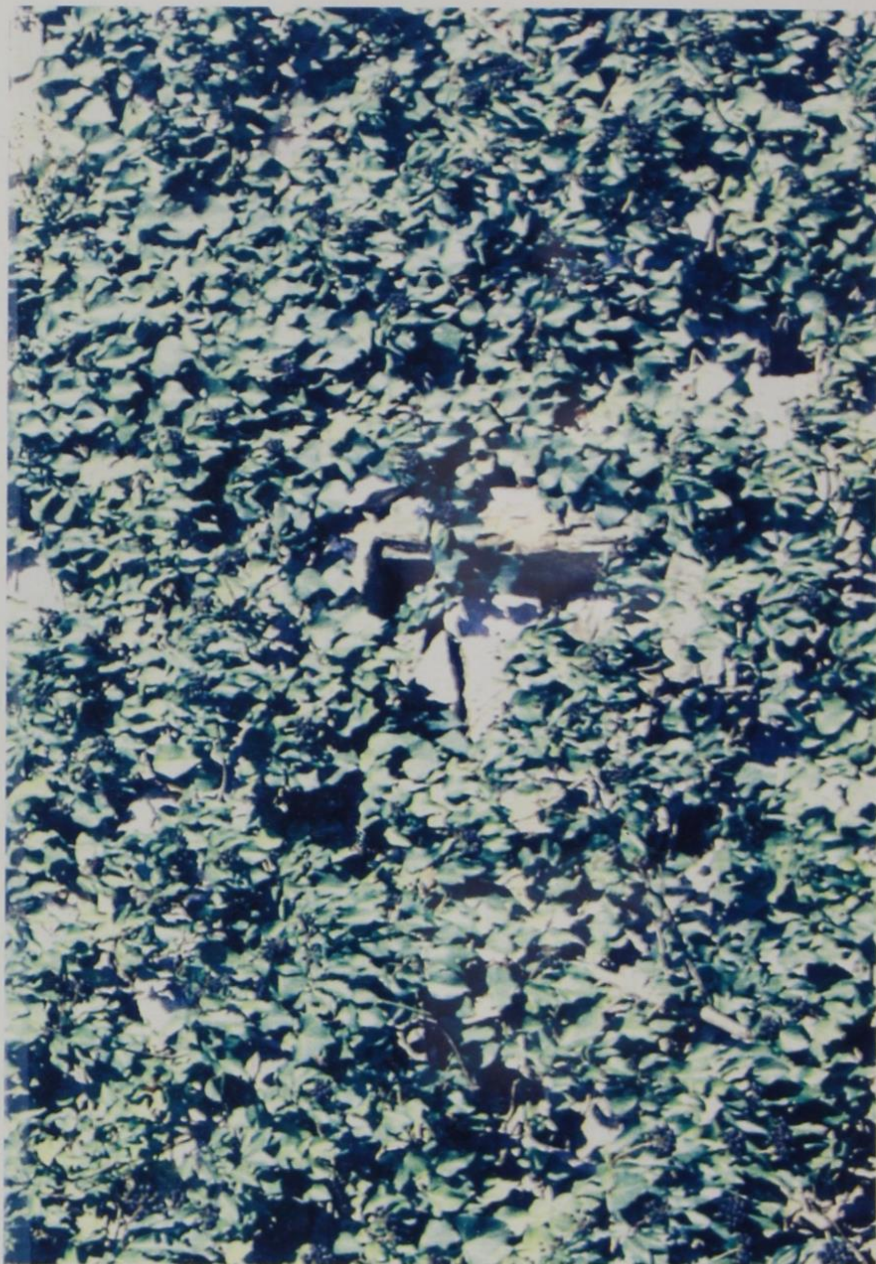
Εικ. 29Α. Γέφυρα Κόνιτσας στον Αώο. Η κόγχη χωμένη στον κισσό, στη δυτική όψη προς τα κατόντη, στο βόρειο μέρος (προς την Κόνιτσα), (1996).
