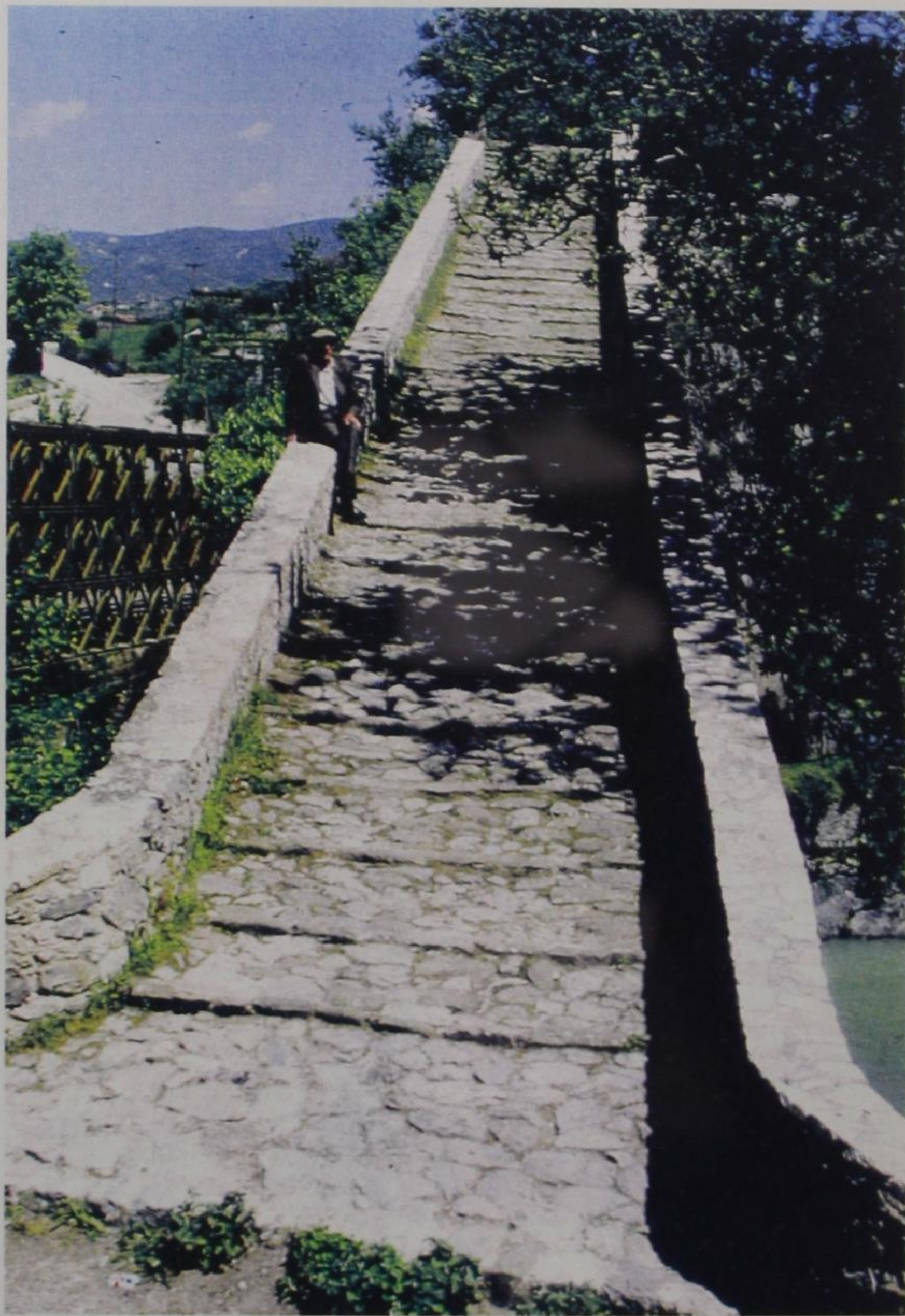
Εικ. 29Γ. Αώος. Γέφυρα Κόνιτσας. Νότιο ανερχόμενο κατάστρωμα, με τις «ούβιες» (οριζόντιες αναβαθμίσεις, που διευκολύνουν το πέρασμα. Τα στηθαία χτιστά νεώτερα. (Φωτογραφία 1995)..
