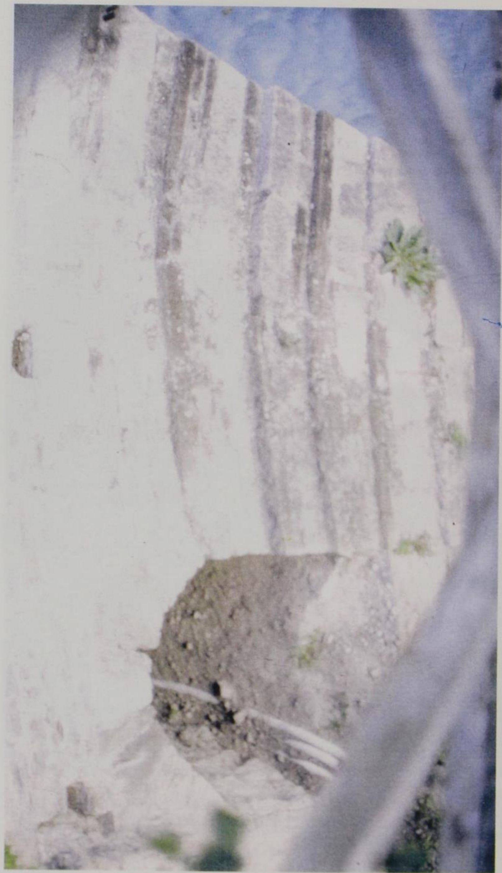
Εικ. 28Α. Αώος. Γέφυρα Κόνιτσας. Δεξιό ποδαρικό. Όψη από τα κατάντη. Φαίνεται η έξοδος της καμάρας για το νεράιλακο (1995).
