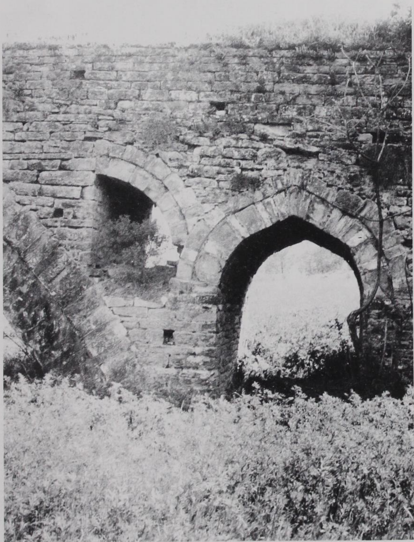
Εικ. 16. Άραχθος. Νότια από τη «Μπαλντούμα». Τα δύο πρώην ανακουφιστικά τόξα του παλαιού γεφυριού. Όψη από τα ανάντη. (10.5.1995).
