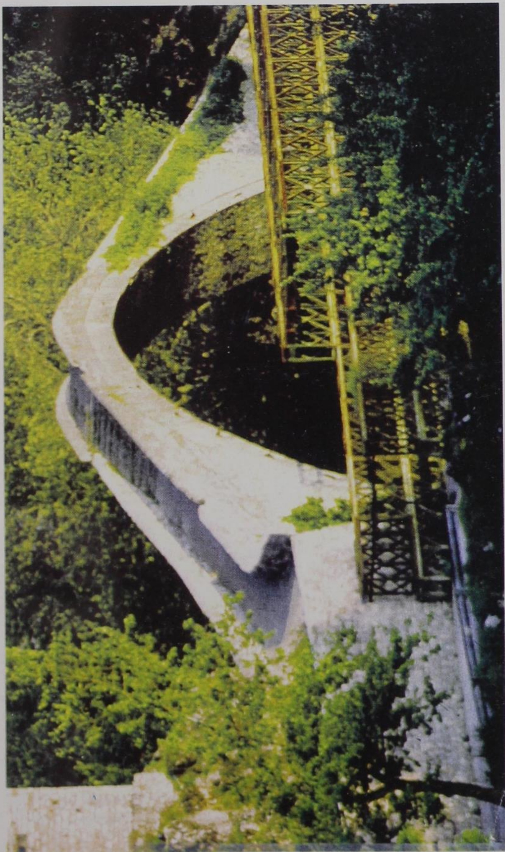
Εικ. 32. Αώος. Οι γέφυρες της Κόνιτσας: η παλαιά πέτρινη τοξωτή και η νεώτερη μεταλλική αμφιέρειστη Bailey «Μπέλεϋ» (1995).
