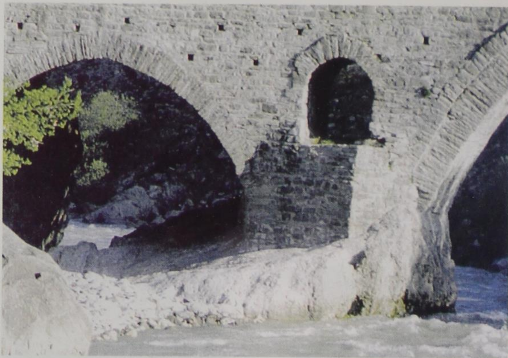
Εικ. 7. Σαραντάπορος. Γεφύρι της Ζέρμας είτε Καντζιώτικο γεφύρι. Μεσόβαθρο επί βράχου, με έμβολο και τόξο (αμφότερα για ανακούφιση του βάθρου στην περίπτωση πλημμύρας). Όψη από τα ανάντη, (1995).
