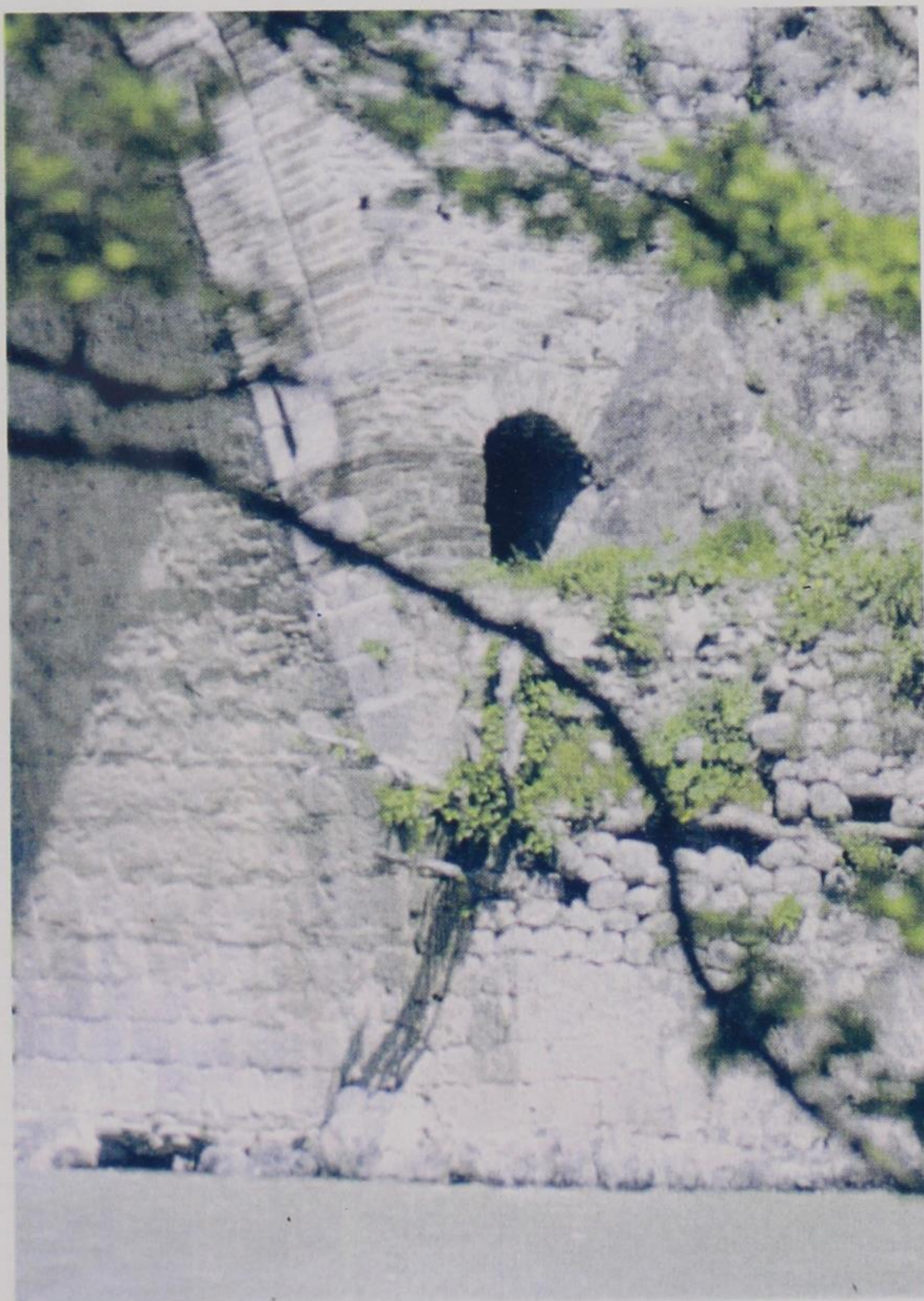
Εικ. 28. Αίως. Γέφυρα Κόνιτσας. Δεξιό (= βόρειο) ποδαρικό. Όψη από τα ανάκνη. Διακρίνεται η (διαμπερής) καμάρα για το αυλάκι νερού (1995).
