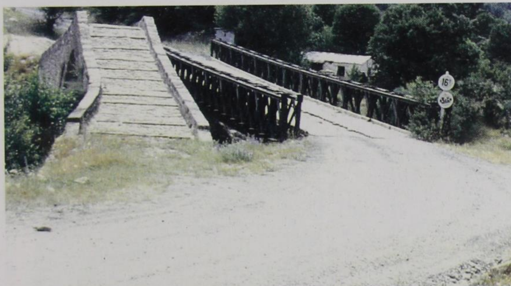
Εικ. 11Α. Σαραντάπορος. Γεφύρι της Ζέρμας ή Καντζιώτικο Γεφύρι. Το παλιό γεφύρι με ανανεωμένο κατάστρωμα, και η νεώτερη μεταλλική γέφυρα «Μπέλε-ϋ». Όψη από βορρά, προς την κατεύθυνση του χωριού Δροσοπηγή (πριν Κάντσι-κο). (1995).
