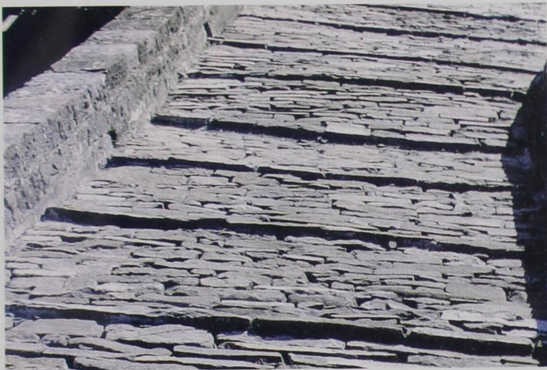
Εικ. 11. Σαραντάπορος. Γεφύρι της Ζέρμας, είτε Καντζιώτικο Γεφύρι. Ανακατασκευή λιθοστρώτου· είναι το κατερχόμενο τμήμα πάνω από τη μεγάλη καμάρα που οδηγεί προς την εθνική οδό (Φωτογραφία 1995).
