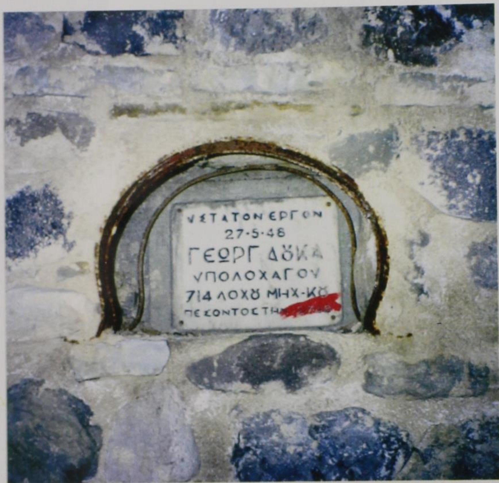
Ειχ. 34. Αώος/Κόνιτσα. Κόγχη στο νεώτερο πέτρινο αναλημματικό τοίχο της τροποποίησης της βόρειας άκρης της παλιάς γέφυρας. Η οικοδομική επιγραφή έχει ως εξής: «ΥΣΤΑΤΟΝ ΕΡΓΟΝ | 27.5.[19]48 | ΓΕΩΡΓ. ΔΟΥΚΑ | ΥΠΟΛΟΧΑΓΟΥ | 714 ΛΟΧΟΥ ΜΗΧ[ΑΝΙ]-ΚΟΥ | ΠΕΣΟΝΤΟΣ ΤΗΝ 12.7.[19]48». (: Φωτογραφία 1995).
