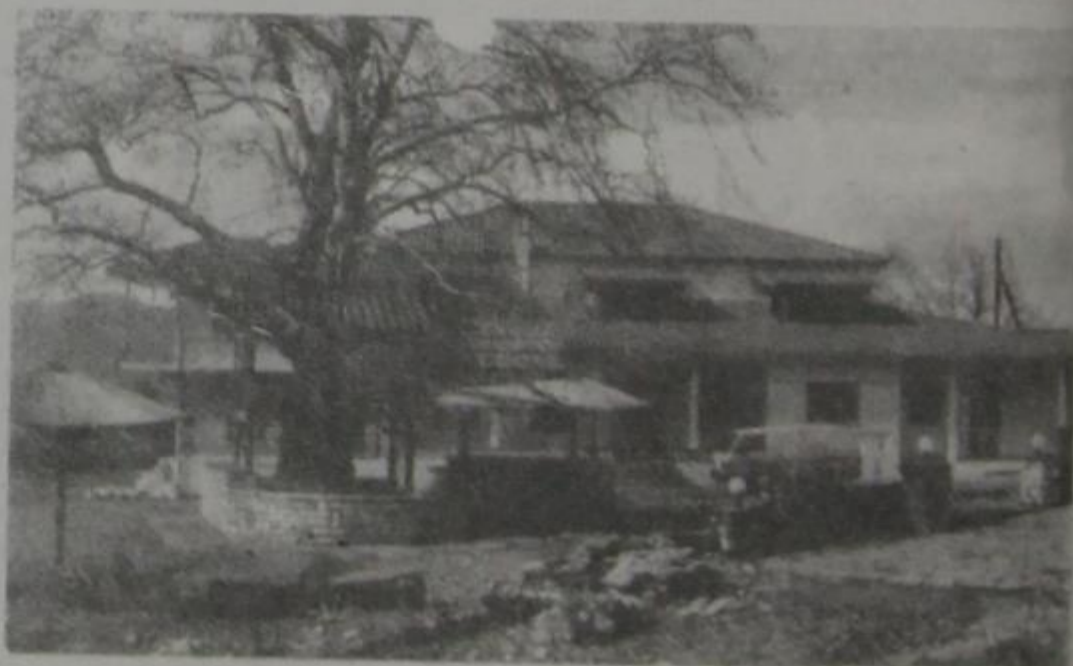
ΞΕΝΟΔΟΧΕΙΟ "Το Γεφύρι" Με 40 κλίνες, εστιατόριο, μπάρ, θέρμανση, πάρκινγκ κλπ. Στην ειδυλλιακή τοποθεσία της γέφυρας Αιού στην Κόνιτσα. Τηλ. 0655-23780
