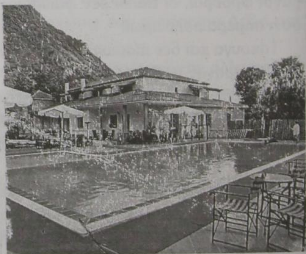
ΞΕΝΟΔΟΧΕΙΟ "Το Γεφύρι" Με 40 κλίνες, εστιατόριο, μπάρ, θέρμανση, πάρκινγκ κλπ. Στην ειδυλλιακή τοποθεσία της γέφυρας Αΐου στην Κόνιτσα. Τηλ. 0655-23780
