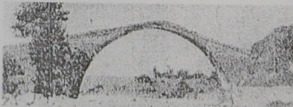
Η περίφημη παλαιά γέφυρα της Κονίτσας, ητις έκτίσθη επί Βυζαντινών και πολλάκις επεκευάσθη μέχρι σήμερον. (Έκ τού Λευκόματος τού Μπουασσονά)
