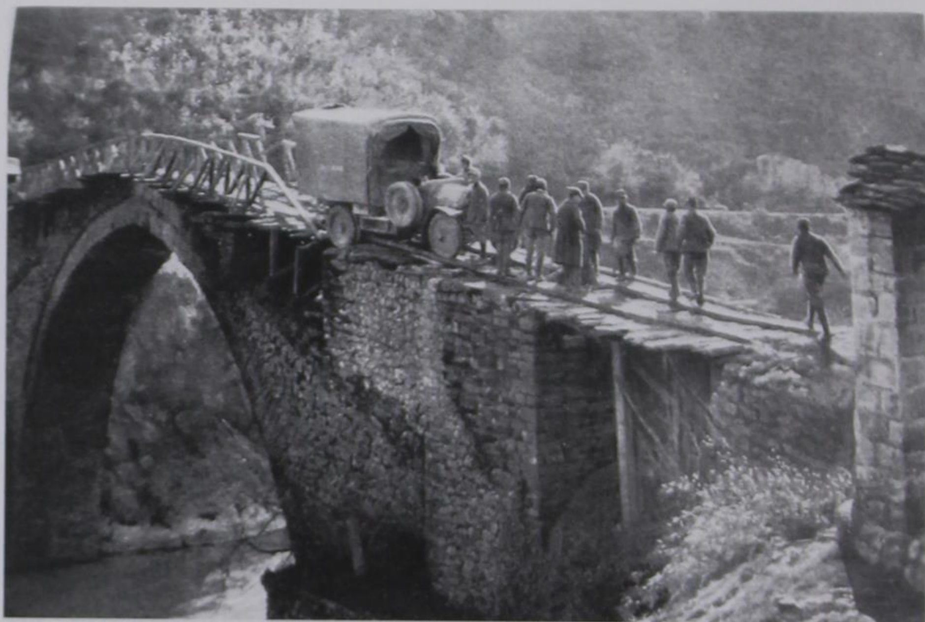
Εφημ. L'illustration 17-03-1917. Ένα φορτηγό αυτοκίνητο σε επικίνδυνη θέση πάνω στη γέφυρα του Σαραντάπορου [Μέρτζιανης], στα ελληνοαλβανικά σύνορα.
