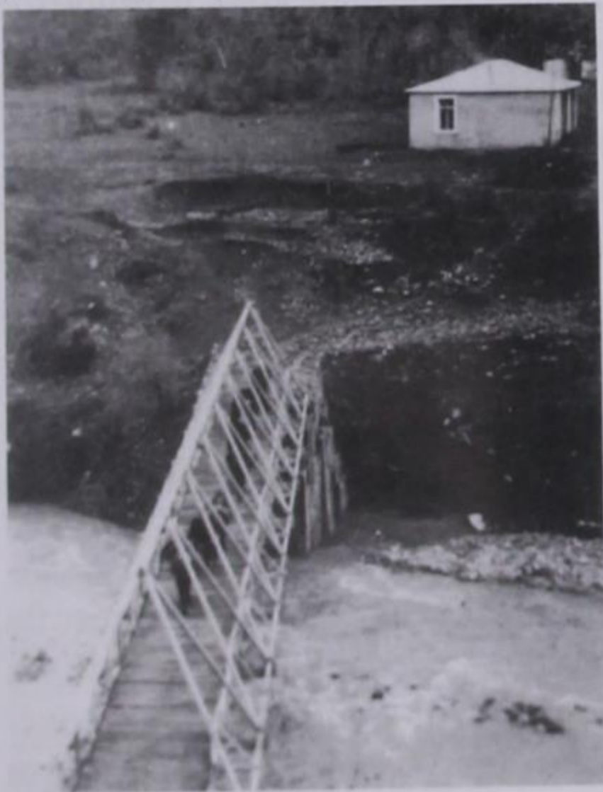
Η δικτυωτή, αμφιέρειστη (ιταλική) γέφυρα Στράτσιανης - Τοποθετήθηκε περί το 1920/22;; Φωτογραφία αρ. 198 β', από το αρχείο του Μουσείου Ηπειρωτών Μαστόρων στην Πυρσόγιαννη. Ευγενική παραχώρηση από τον Βασ. Παπαγεωργίου.
