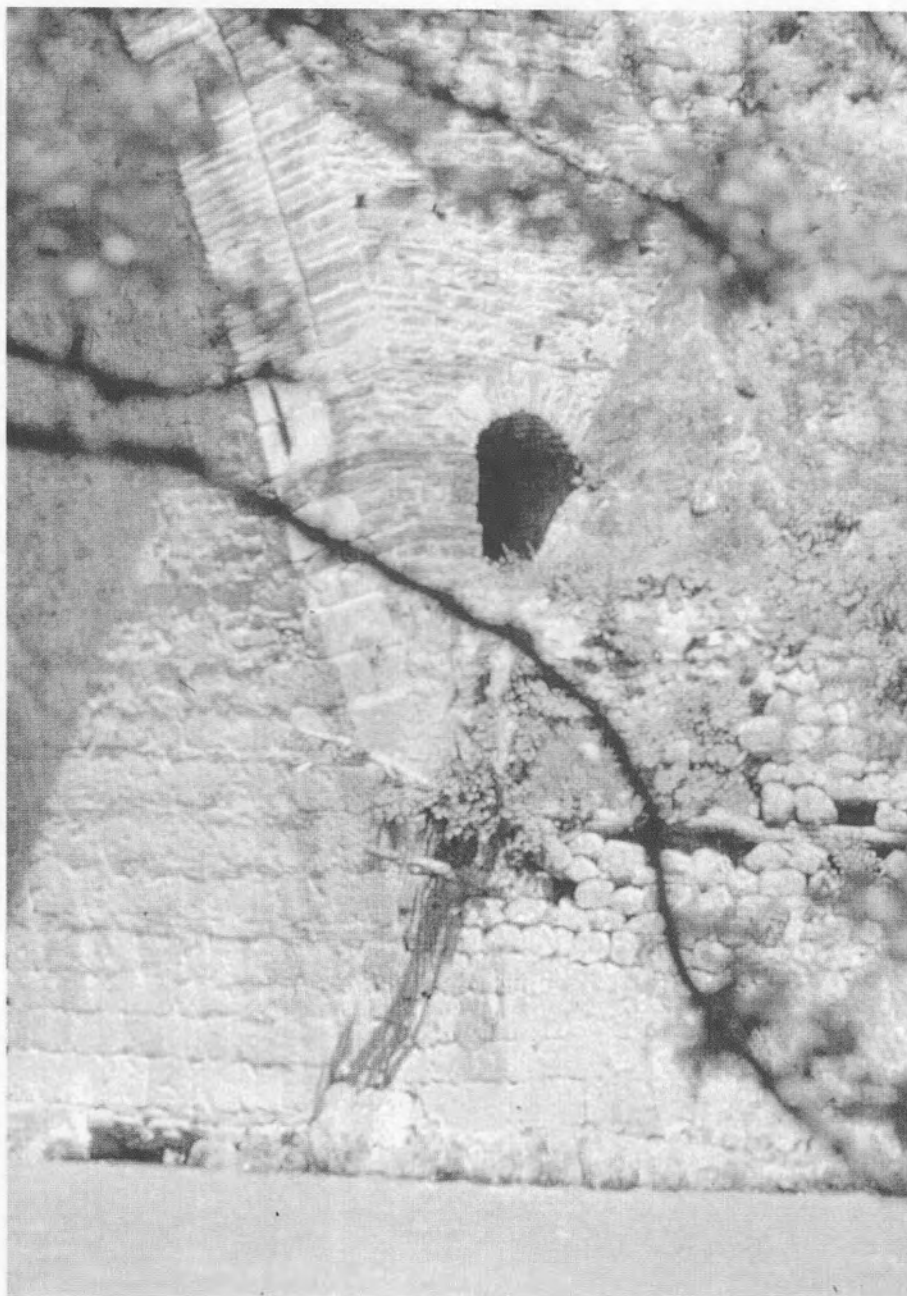
Εικ. 28. Αώος. Γέφυρα Κόνιτσας. Δεξιό (= βόρειο) ποδαρικό. Όψη από τα ανάκνη. Διακρίνεται η (διαμπερής) καμάρα για το αυλάκι νερού (1995).
