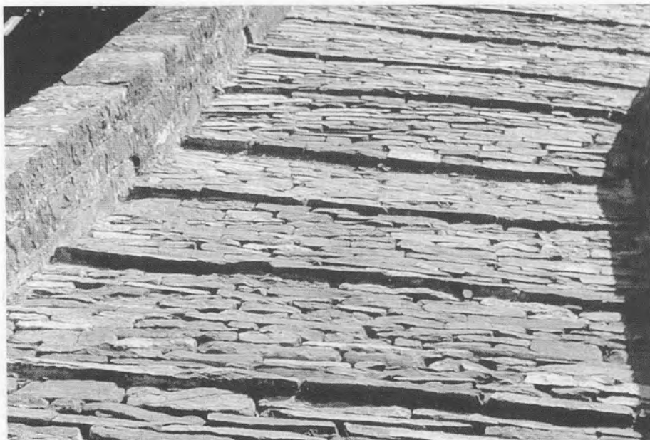
Εικ. 11. Σαραντάπορος. Γεφύρι της Ζέριμας, είτε Καντζιώτικο Γεφύρι. Ανακατασκευή λιθοστρώτου· είναι το κατερχόμενο τμήμα πάνω από τη μεγάλη καμάρα που οδηγεί προς την εθνική οδό (Φωτογραφία 1995).
