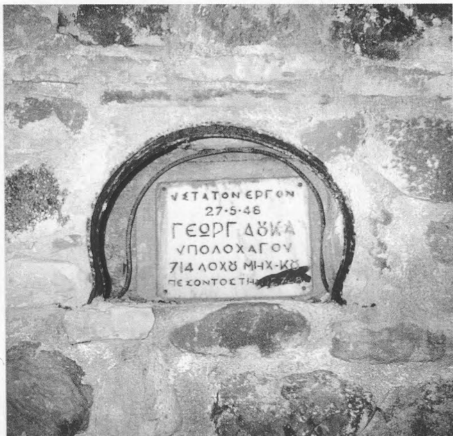
Εικ. 34. Αώος/Κόνιτσα. Κόγχη στο νεώτερο πέτρινο αναλημματικό τοίχο της τροποποίησης της βόρειας άκρης της παλιάς γέφυρας. Η οικοδομική επιγραφή έχει ως εξής: «ΥΣΤΑΤΟΝ ΕΡΓΟΝ | 27.5.[19]48 | ΓΕΩΡΓ. ΔΟΥΚΑ | ΥΠΟΛΟΧΑΓΟΥ | 714 ΛΟΧΟΥ ΜΗΧ[ΑΝΙ]-ΚΟΥ | ΠΕΣΟΝΤΟΣ ΤΗΝ 12.7.[19]48». (: Φωτογραφία 1995).
