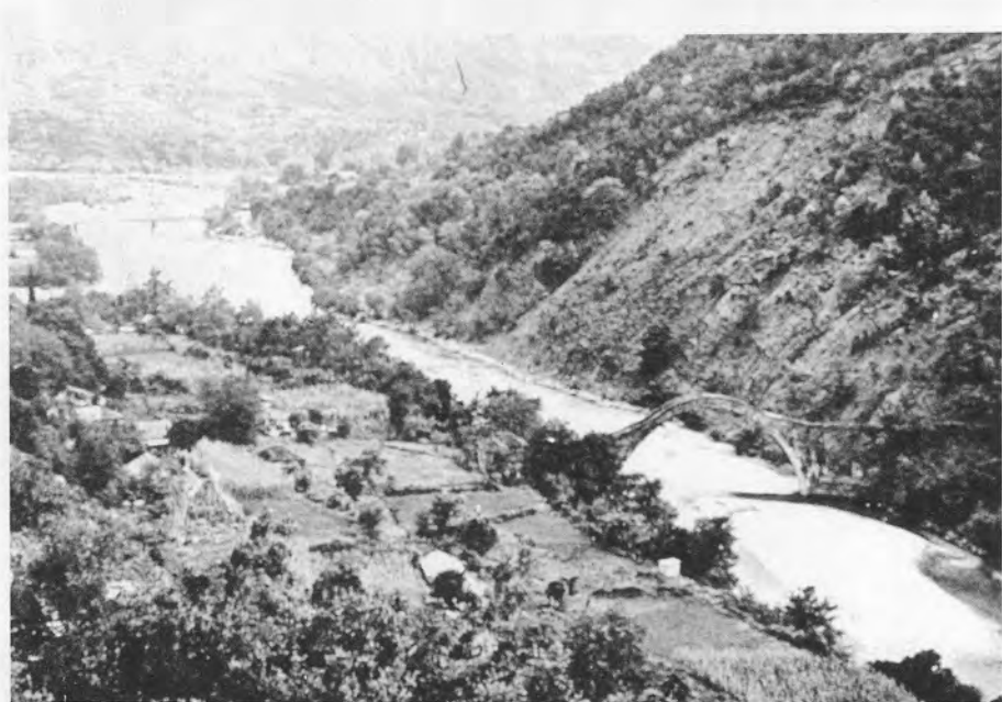
Εικ. 5. Αραχθος. Γέφυρα της Πλάκας (ή «Γέφυρα Βο(υ)ρδώ»). 1866. Πλάγια άποψη από τα ανάντη, ανεβαίνοντας το δρόμο προς το μοναστήρι Μονχούσι ή Παναγίας (: φωτογραφία Λουκίας Πολίτη, περ. 1978).
