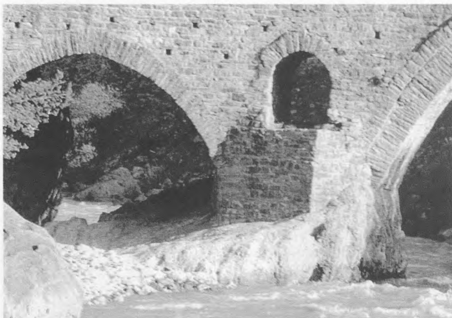
Εικ. 7. Σαραντάπορος. Γεφύρι της Ζέρμας είτε Καντζιώτικο γεφύρι. Μεσόβαθρο επί βράχων, με έμβολο και τόξο (αμφότερα για ανακούφιση του βάθρου στην περίπτωση πλημμύρας). Όψη από τα ανάντη, (1995).
