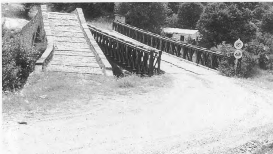
Εικ. 11Α. Σαραντάπορος. Γεφύρι της Ζέριμας ή Καντζιώτικο Γεφύρι. Το παλιό γεφύρι με ανανεωμένο κατάστρωμα, και η νεώτερη μεταλλική γέφυρα «Μπέλε-ϋ». Όψη από βορρά, προς την κατεύθυνση του χωριού Δροσοπηγή (πριν Κάντσι-κο). (1995).
