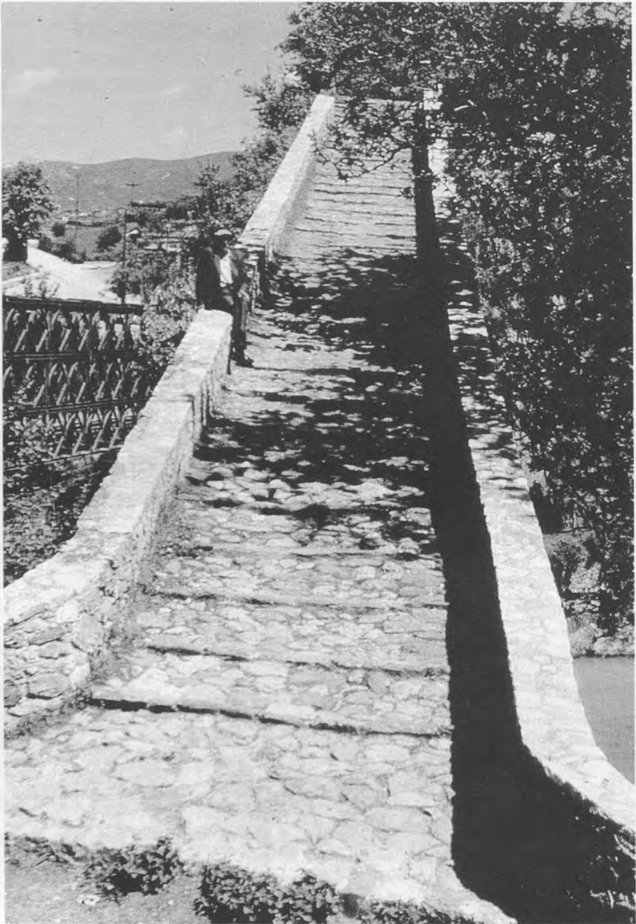
Εικ. 29Γ. Αώος. Γέφυρα Κόνιτσας. Νότιο ανερχόμενο κατάστρωμα, με τις «σύνβιες» (οριζόντιες αναβαθμίσεις, που διευκολύνουν το πέρασμα. Τα στηθαία χτιστά νεώτερα. (Φωτογραφία 1995)..
