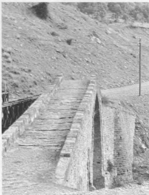
Εικ. 7. Σαραντάπορος. Γεφύρι της Ζέρμας είτε Καντζιώτικο γεφύρι. Μεσόβαθρο επί βράχων, με έμβολο και τόξο (αμφότερα για ανακούφιση του βάθρου στην περίπτωση πλημμύρας). Όψη από τα ανάντη, (1995).
