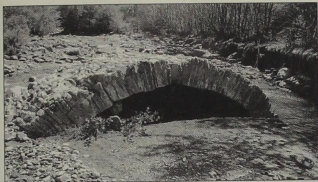
Εικ. 4. Κατάντης όψη γέφυρας Βουρκοποτάμου (φωτο: Βασ. Σκούρτης, Σεπτ. 2003).
