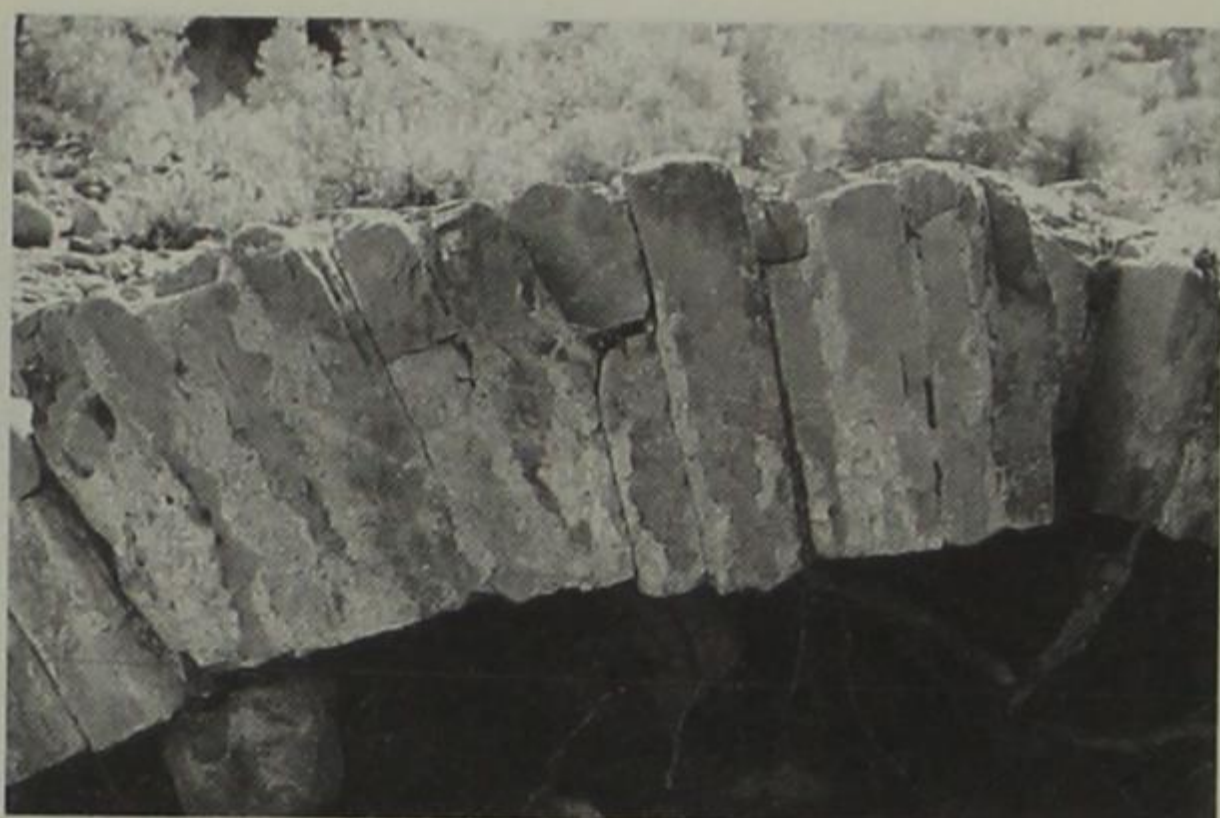
Εικ. 7. Αντιπροσωπευτικό δείγμα τοξολίθων κατάντη μετώπου γέφυρας Βουρκοποτάμου (φωτοθήκη Α.Π.: φιλμ φ.02.XI/03VIII-1, αριθμ. 31 της 13ης Αυγούστου 2003).
