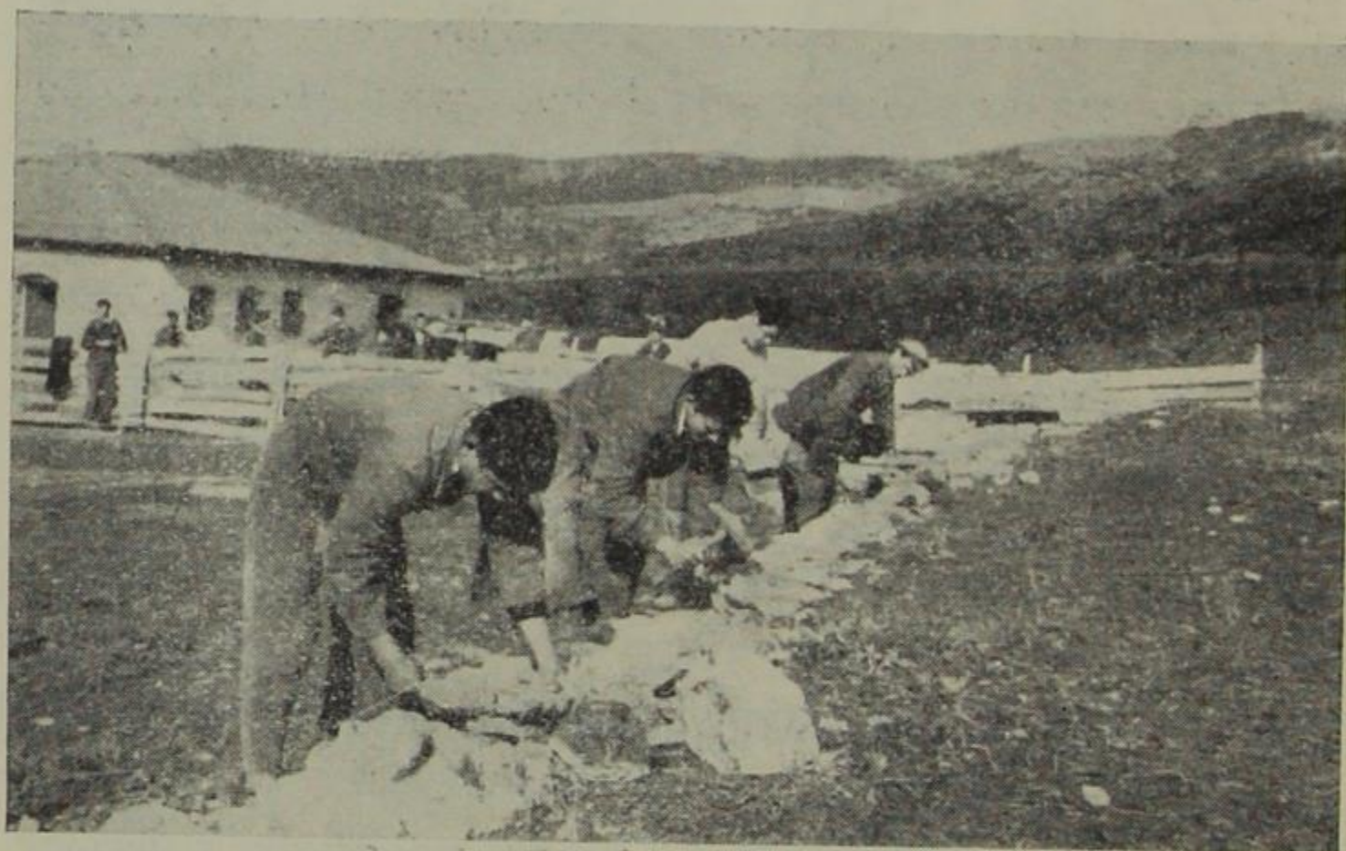
Διδασκαλία κτισίματος ξερολιθιάς πρός πρόληψιν διαβρώσεως εδάφους "Ανω Κτήμα
