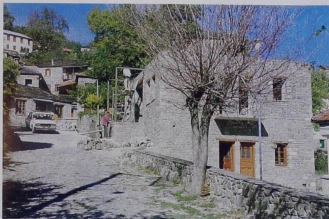
Το υπό ανακαίνιση κτίριο του Δημαρχείου.
