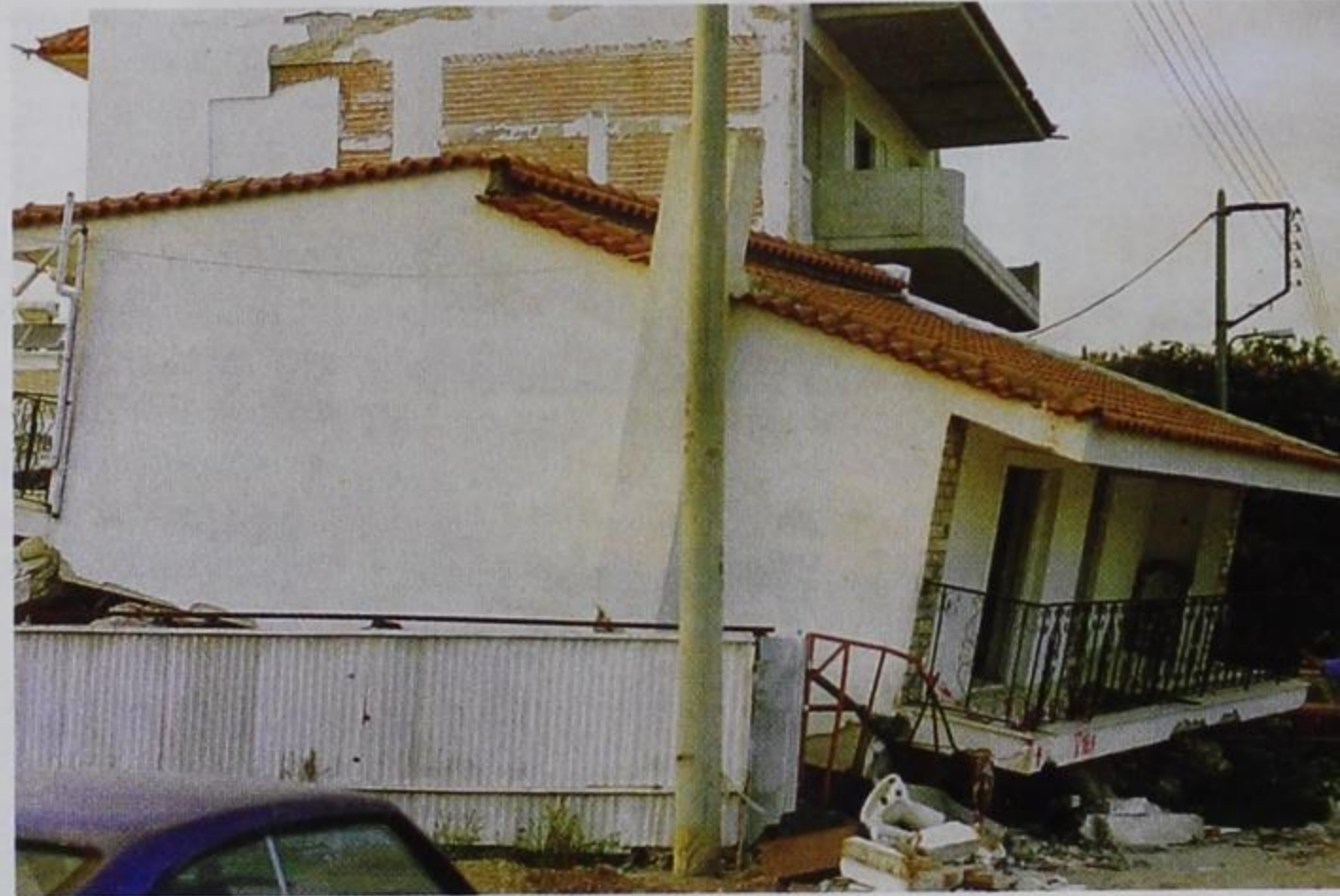
Το σπίτι του Θ. Σπυράκου. Ο όροφος που φαίνεται είναι ο τρίτος. Οι δύο άλλοι έγιναν ερείπια κάτω από τα οποία θάυτηκε ο άτυχος Θωμάς.
