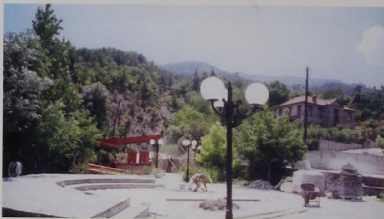
Εργασίες αποκατάστασης του πάρκου. Στο βάθος το κιόσκι.
