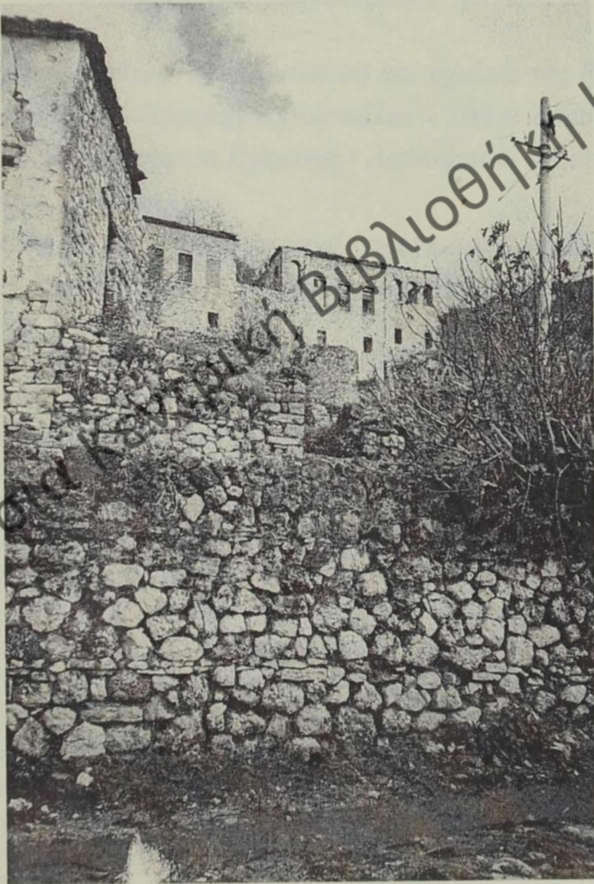
Άποψη του ερειπωμένου αρχοντικού των Ζαπλαίων στο Κάτω Λάμποβο, (Λάμποβο του Ζάλπα).
