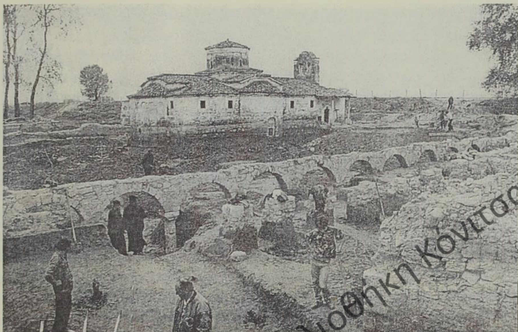
Εκσκαφικές εργασίες στο Μοναστήρι του Αγίου Κοσμά
