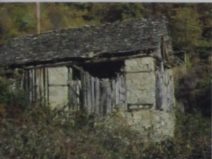
Καλύβα στον Γοργοπόταμο
