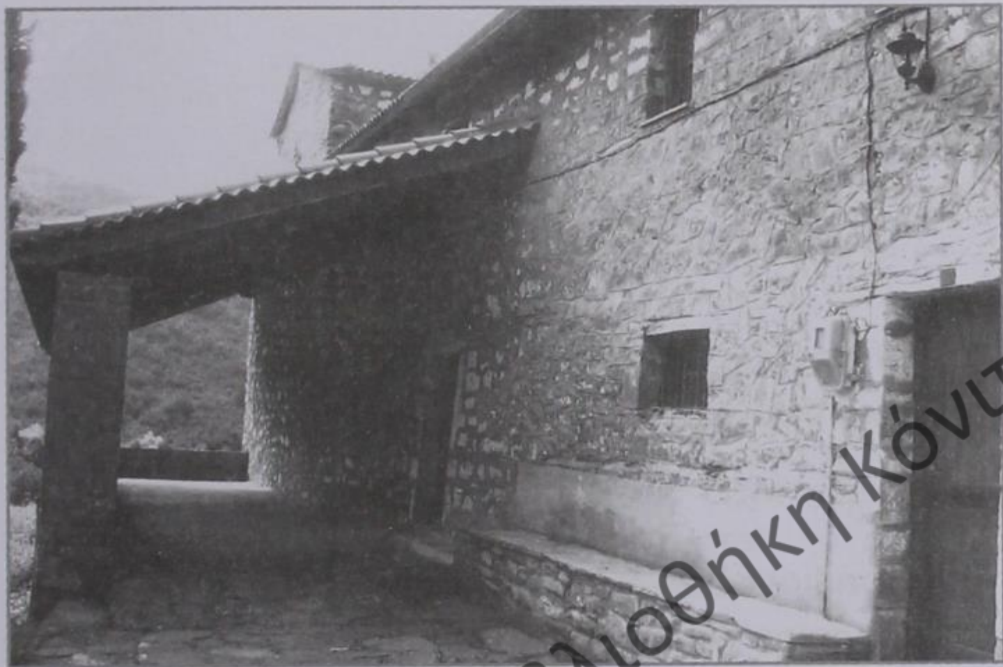
42. Τό χαγιάτι τοῦ ναοῦ τοῦ Ἁγίου Νικολάου, νεώτερη κατασκευή.
