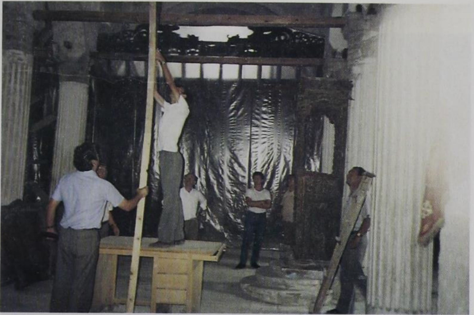
Η επισκευή έχει αρχίσει.
