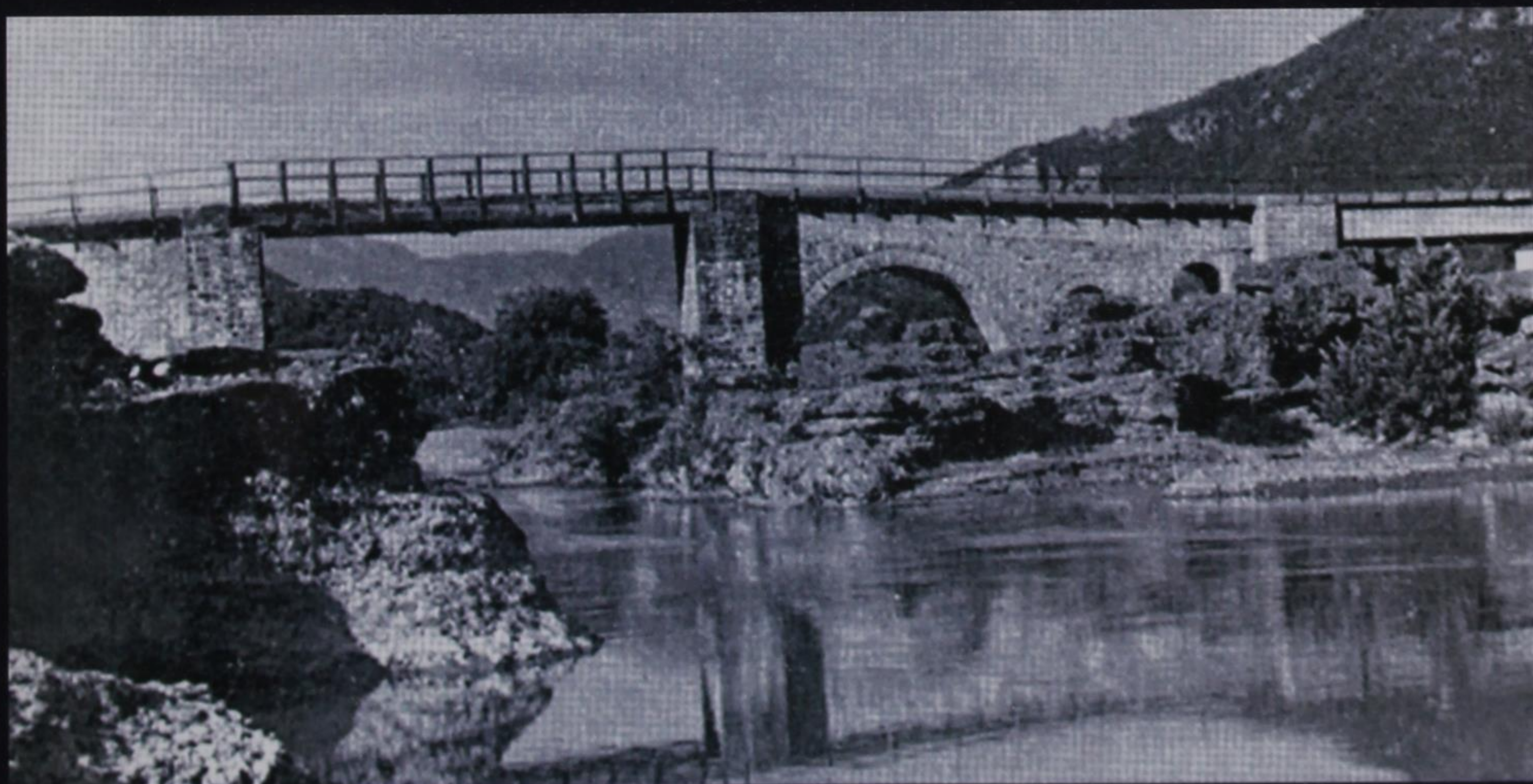
Η Μεσογέφυρα, η τρίτη κατά σειρά γέφυρα του Αώου, κοντά στη σμίξη του με τον Σαραντάπορο από την οποία επίσης σήμερα σώζονται μόνο τα βάθρα (αρχείο Γεωργίου Τάσσου).
