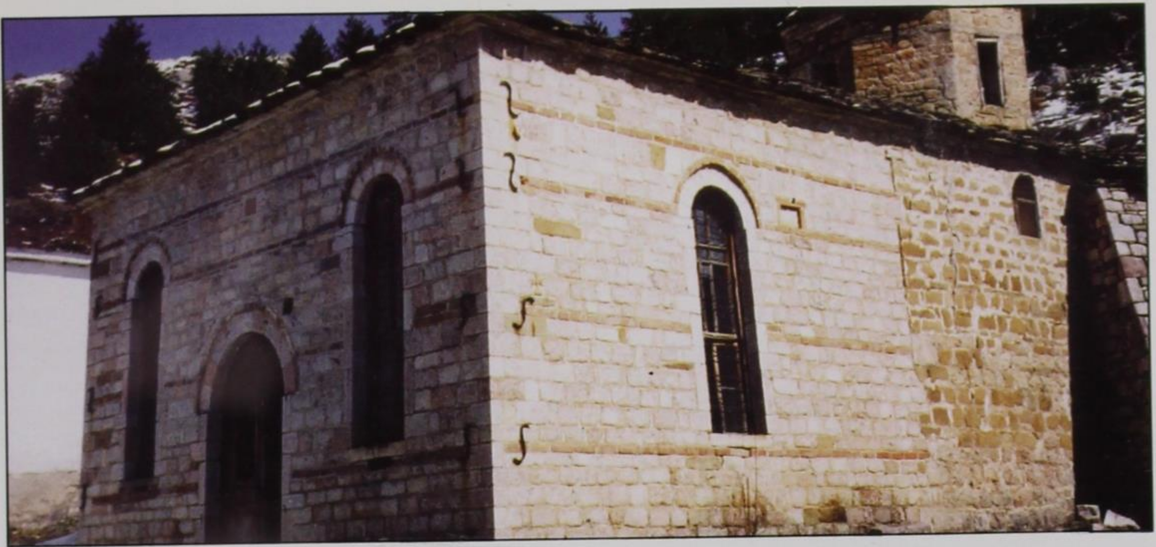
239. Μοσχόπολη. Μονή Προδρόμου. Καθολικό, άποψη νάρθηκα εξωτερικά από Ν.Δ.
