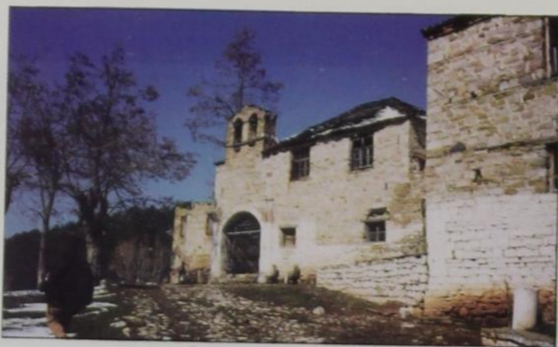
236. Μοσχόπολη. Μονή Προδρόμου. Εξωτερική άποψη εγκαταστάσεων από Ν.Δ.
