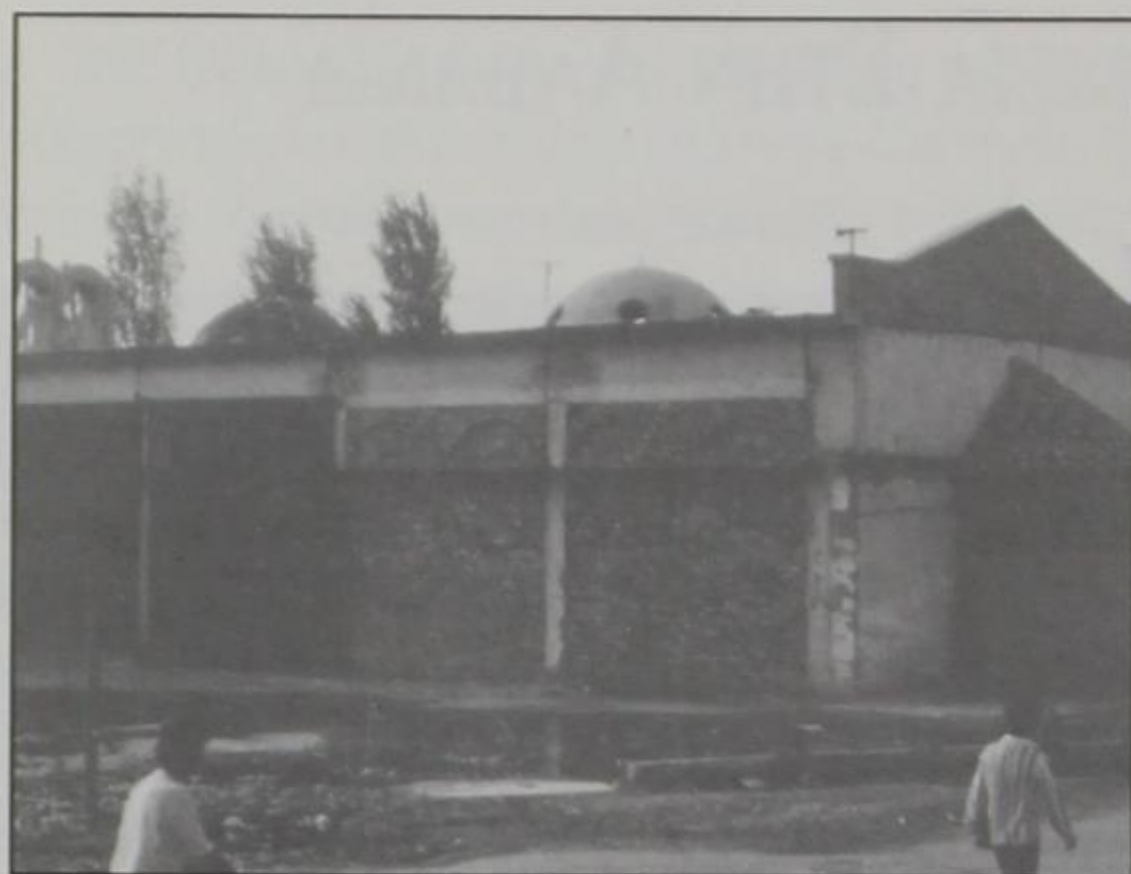
4. Αυλώνα. Ορθόδοξη εκκλησία μεταβληθείσα σε πυροσβεστικό.
