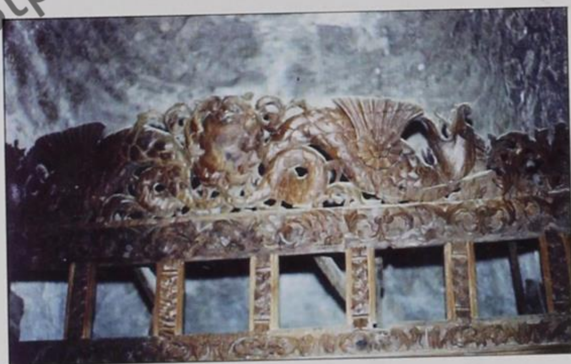
209. Κολικόντασι. Μ. Αγ. Κοσμά. Καθολικό. Εσωτερικό, τμήμα του συλημένου τέμπλου, με τους όφεις των Λυπηρών.
