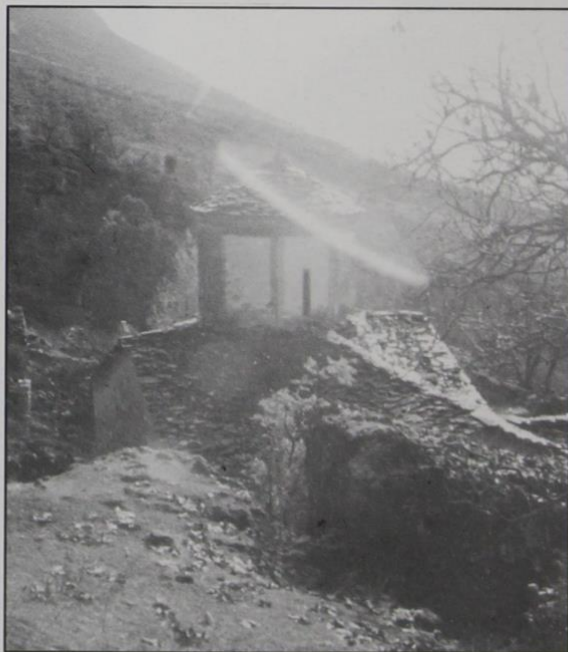
71. Τρανοσίστα Λιούντζης. Μονή Σπηλαίου, εξωτερική άποψη από Δ.
