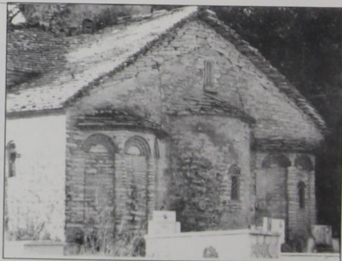
101. Ζερβάτι. Ναός Παναγίας από Α. Διακρίνονται εξωτερικά τα μεταγενέστερα στοιχεία: ανύψωσης της στέγης & πλαϊνών κογχών.
