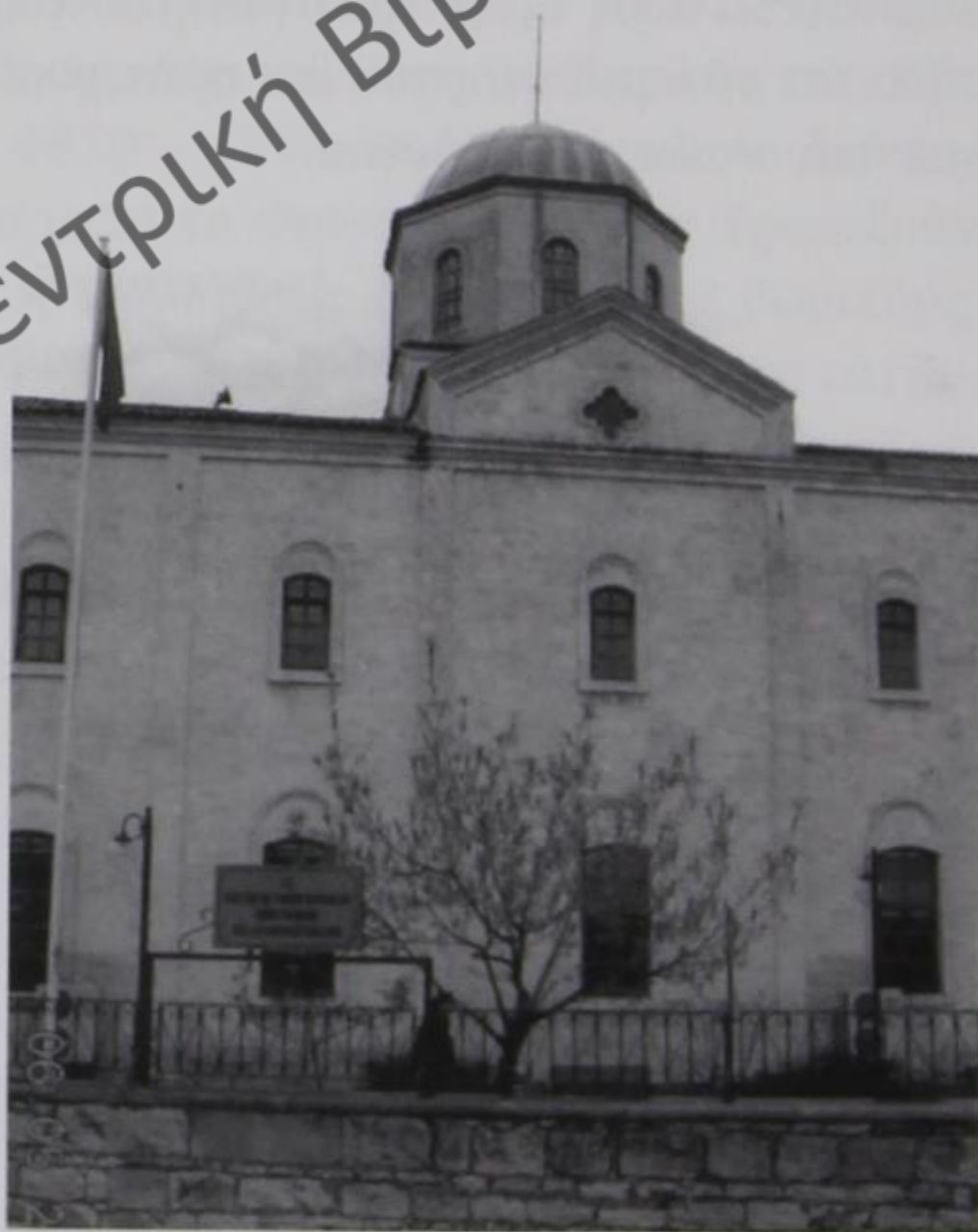
Εικ. 2. Κοτύωρα, η δυτική όψη του ναού.
