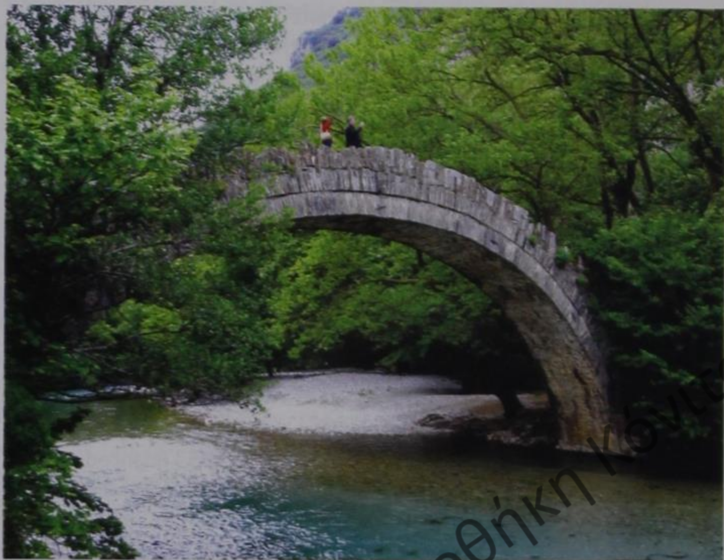
Voidomatis bridge, Kleidonia
