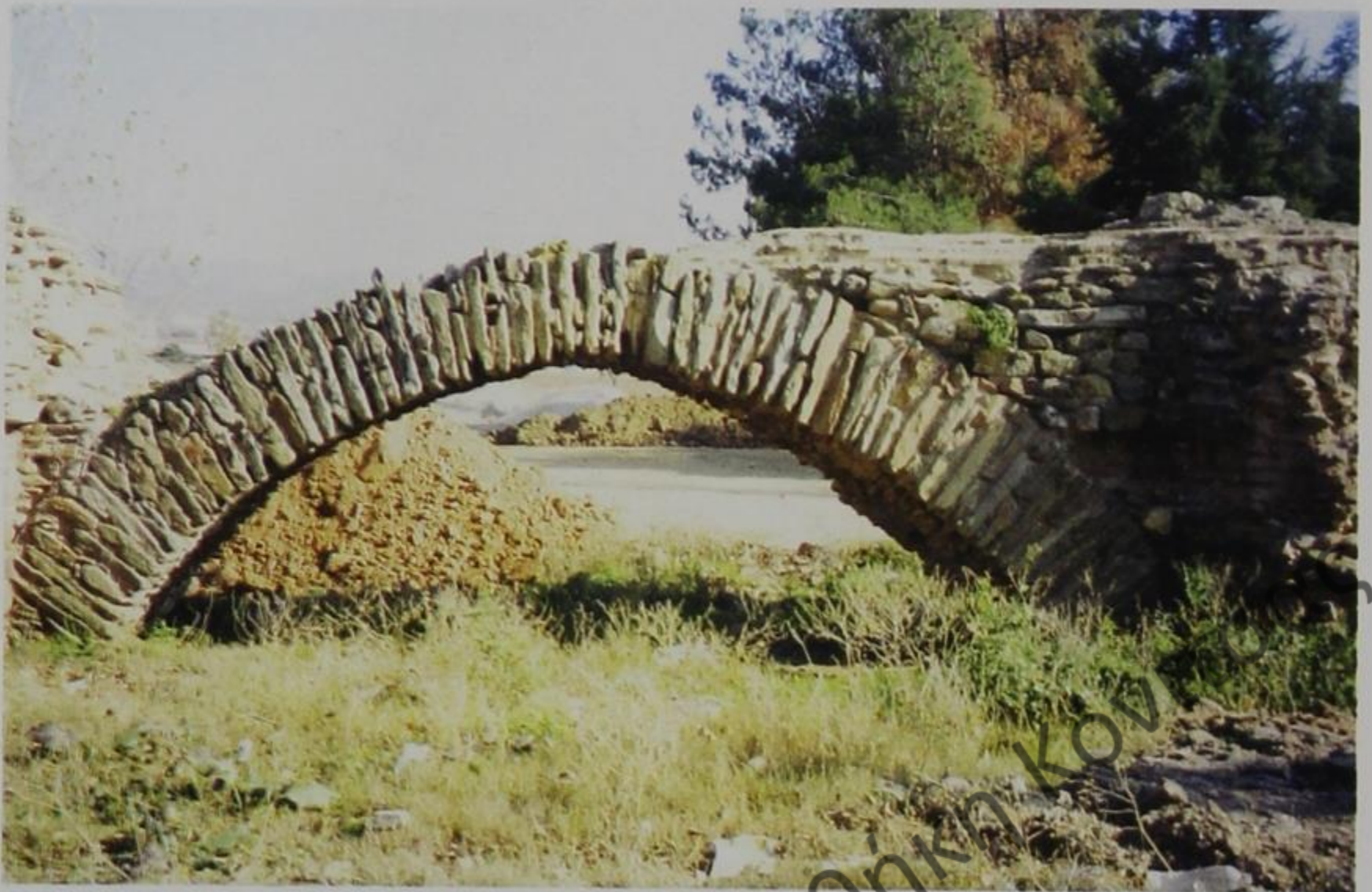
Εικ. 27. Πυλαία Θεσσαλονίκης, γειτονιά «Καπουτζήδες», θέση και γεφύρι «Καμάρα» (τώρα κι αυτό εκτός κοίτης). Λειψάνο παλαιοχριστιανικής γέφυρας μάλλον του 5ου αι. μ.Χ. Παρατηρείται ότι το τόξο δεν είναι μόνο (ελαφρά) οξυκόρυφο, αλλά διακρίνεται τελικά σε τέσσερις καμπύλους κλάδους (φωτ.: 3 Δεκ. 1999, Φωτοθήκη Α.Π.: Φ.99.ΧΙ/1 τελ., αριθ. 20).
