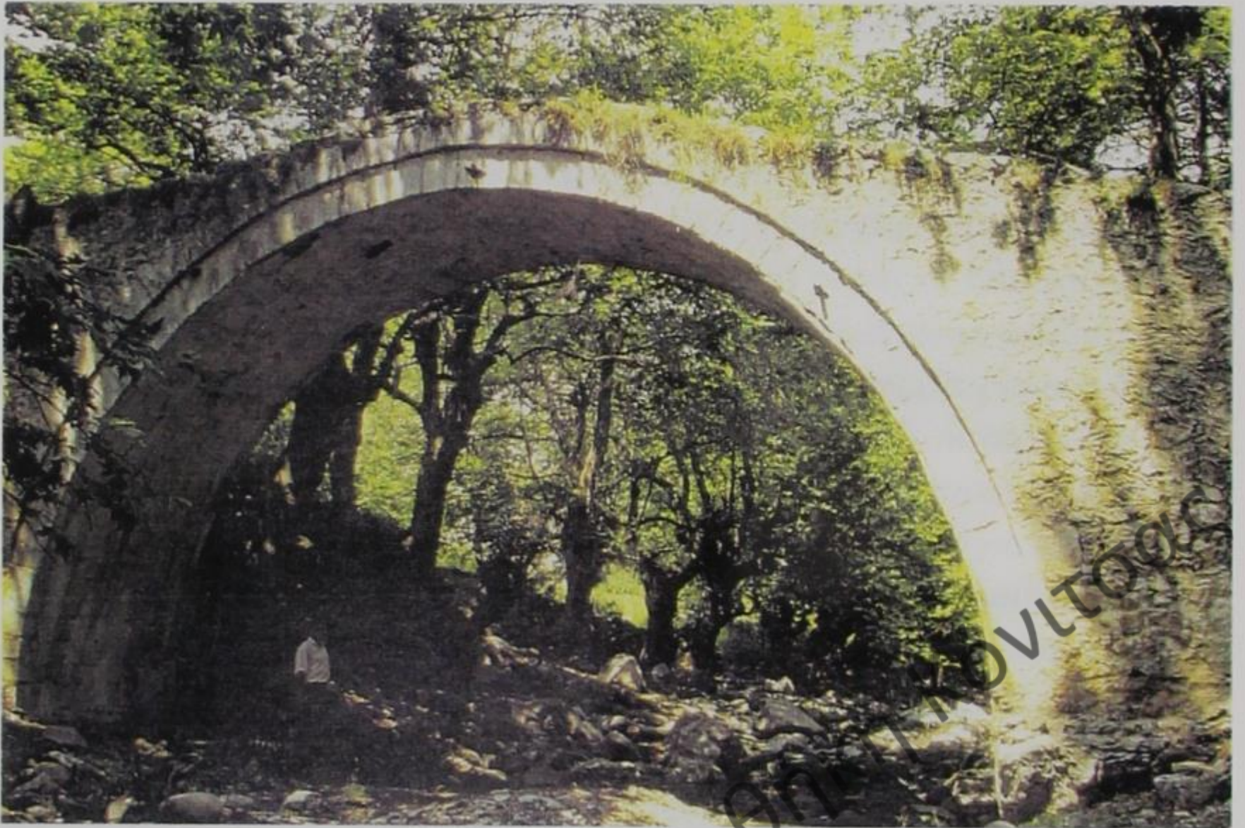
Εικ. 71. Γεφύρι στο χωριό Λάκκος Σερρών [Κτίσμα του β' μισού του 19ου αι.] από τα πιο καλοκτισμένα Ανατολικής Μακεδονίας με 3 «άρπιζες». (Φωτ. 1995: Γ. Τσότσος, 1997, σ. 150 εικ. 116).
