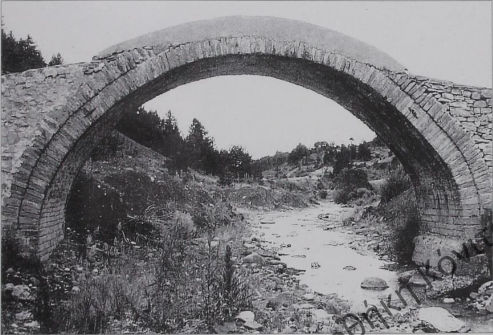
Εικ. 64. Γεφύρι του Μασσαγκάνη της Κρανιας Γρεβενών. Κατά παράδοση κτίστηκε πριν το 1850. (Φωτ. 1988: Γ. Τσότσος, 1997, σ. 56 εικ. 25).
