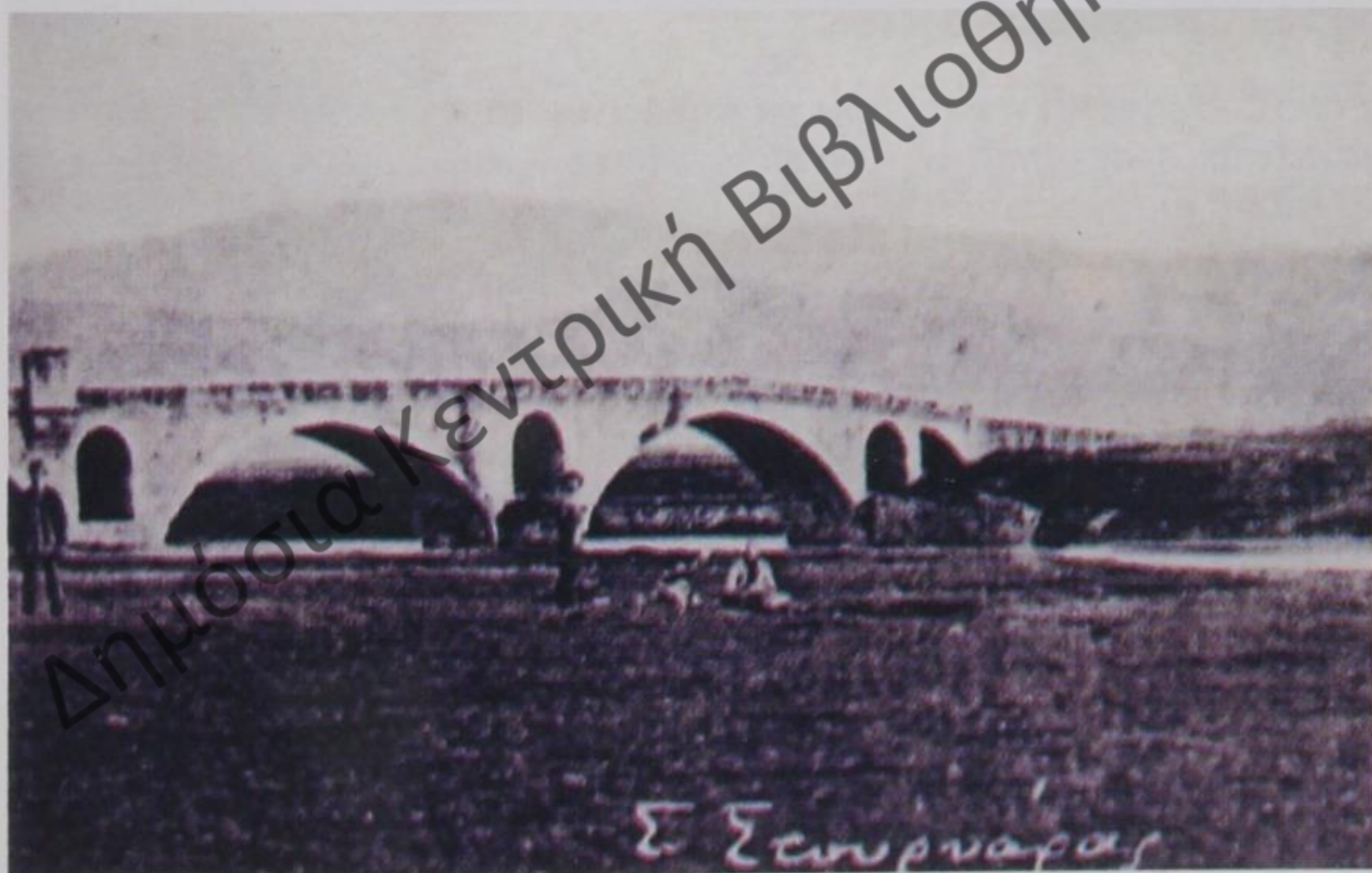
Εικ. 56Γ (επάνω), και 56Δ. «Γέφυρα Πασιά» στον Ενιπέα Φαρσάλων, 1752: Όψη από κατάντη (δεξιά βρίσκονται τα Φάρσαλα). Διακρίνεται δεξιά το μεγάλο ακραίο τεταρτοκυκλικό τόξο. Δεν σώζεται πλέον. (Πηγή: – Γ = Εφημερίδα The Illustrated London News , June 5, 1897, 768, εικονογραφεί μάχη Ελληνο-Τουρκικού πολέμου 1897. – Δ = Από καρτ-ποστάλ Στέφ. Στουρνάρα γύρω στα 1900. Και οι δύο πολύτιμες απεικονίσεις από το βιβλίο Αντ. Γαλερίδη κ. Α. (βλ. τίτλο σημ. 37) αντίστοιχα στις σελίδες 109 & 107).
