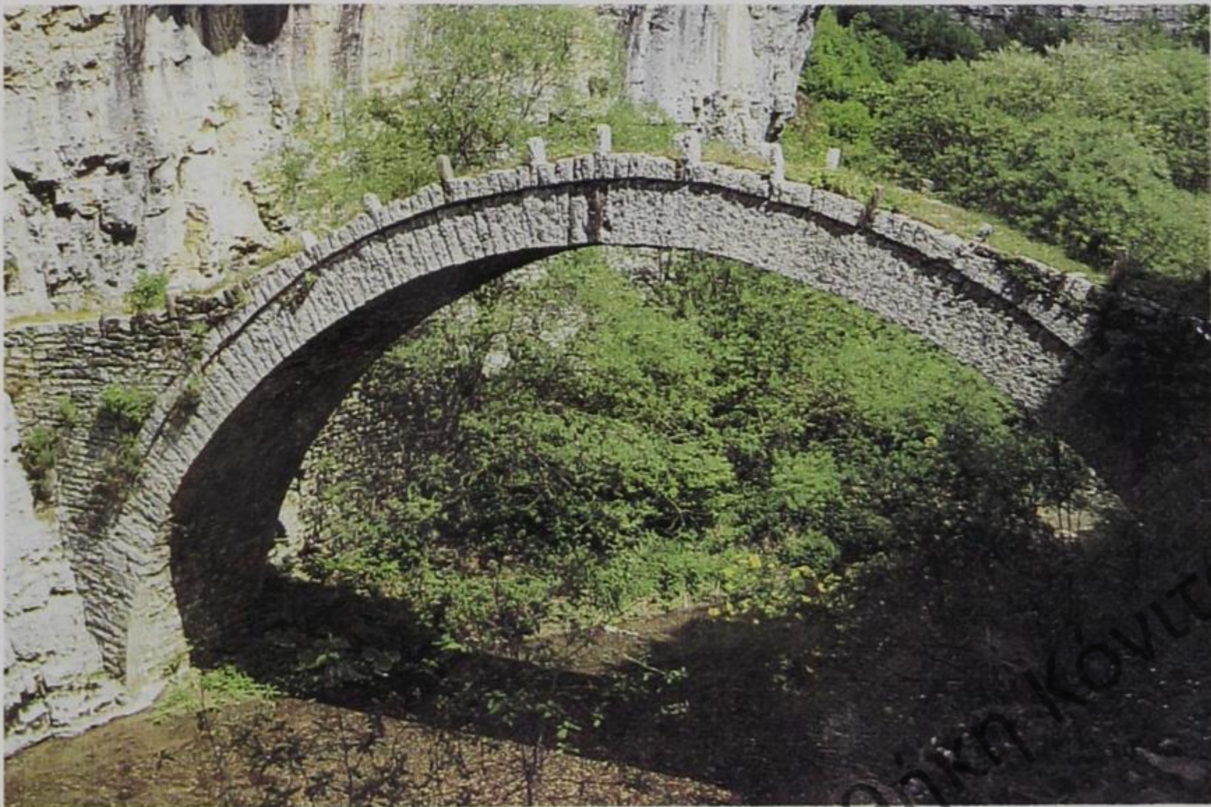
Εικ. 80. Γέφυρα του Κοντοδήμου (ή του Λαζαρίδη) ανάμεσα Κουκούλι και Κήπους στο Ζαγόρι, 1753. Χαρακτηριστικές με σιγούρια καλοτοποθετημένες «αρκάδες» (Σπ. Ι. Μαντάς, Ηπειρωτικά Γεφύρια , 1984, σ. 100 εικ. 55)
