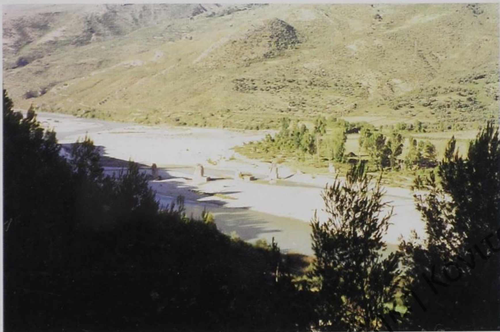
Εικ. 88. Ο Αώος κάτω από το Τεπελένι: στην κοίτη διακρίνονται βάθρα πολύτοξης γκρεμισμένης γέφυρας. (Η αριστερά δασωμένη πλευρά είναι κλιτύς του εκεί φρουρίου του Αλή Πασά Τεπελενλή. Ανέναντι οι υπώρειες του θρυλικού όρους Σεντέλι –υψομ. 1802 μ.– επέκταση της αιματοβαμμένης το 1940-1941 Τρεμπεσίνας –1929 μ. (Φωτ. 11 Σεπτ. 1995 Α.Π.: Φ. 95.IX/5, αριθ. 29).
