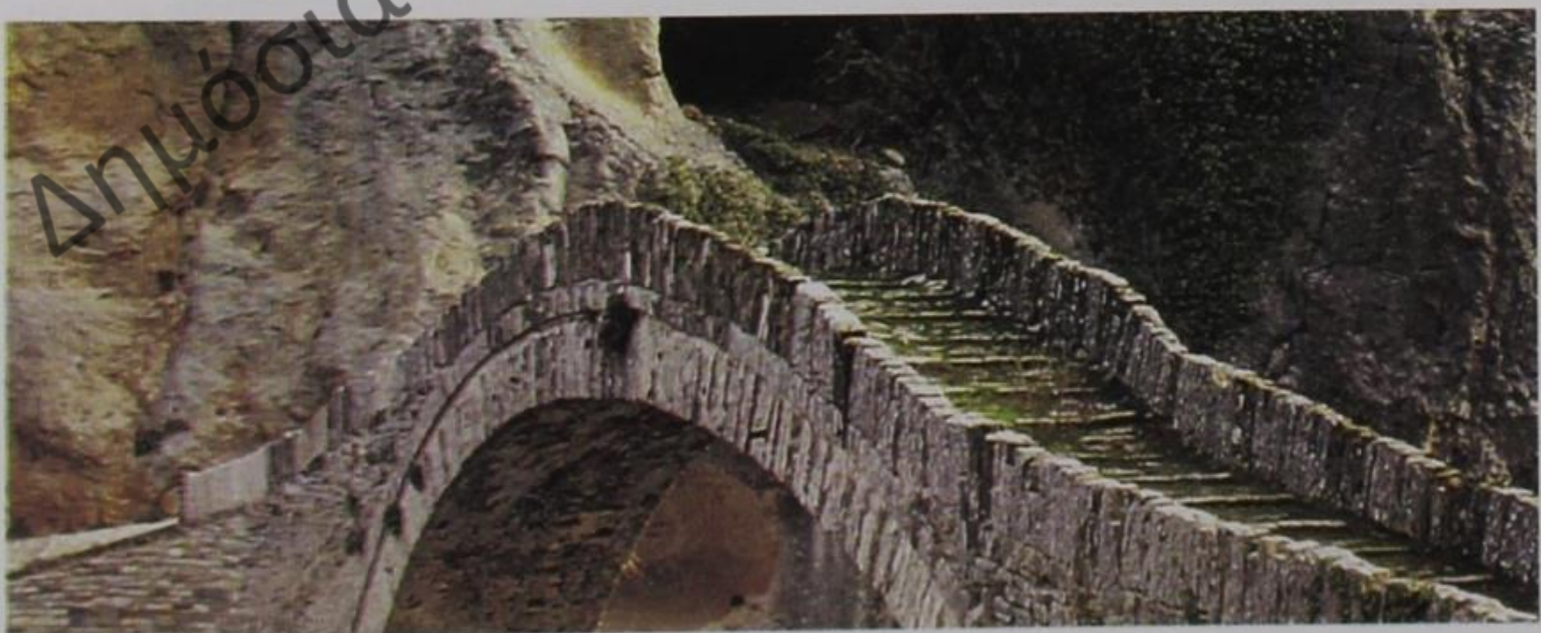
Εικ. 82Α και Β. Γεφύρι Νούτσου (ή Κόκορη μετά το 1910) στο Βίκο Ζαγορίου. Αρχική κατασκευή 1750. Ανακατασκευή 1768. Μεταγενέστερες επισκευές. Α' (επάνω) = Συνολική άποψη. Β' (κάτω) = Λεπτομέρεια κεντρικού στηθαίου. (Φωτ. Σπ. Ι. Μαντάς, Ηπειρωτικά Γεφύρια , 1984, σ. 93 εικ. 47).
