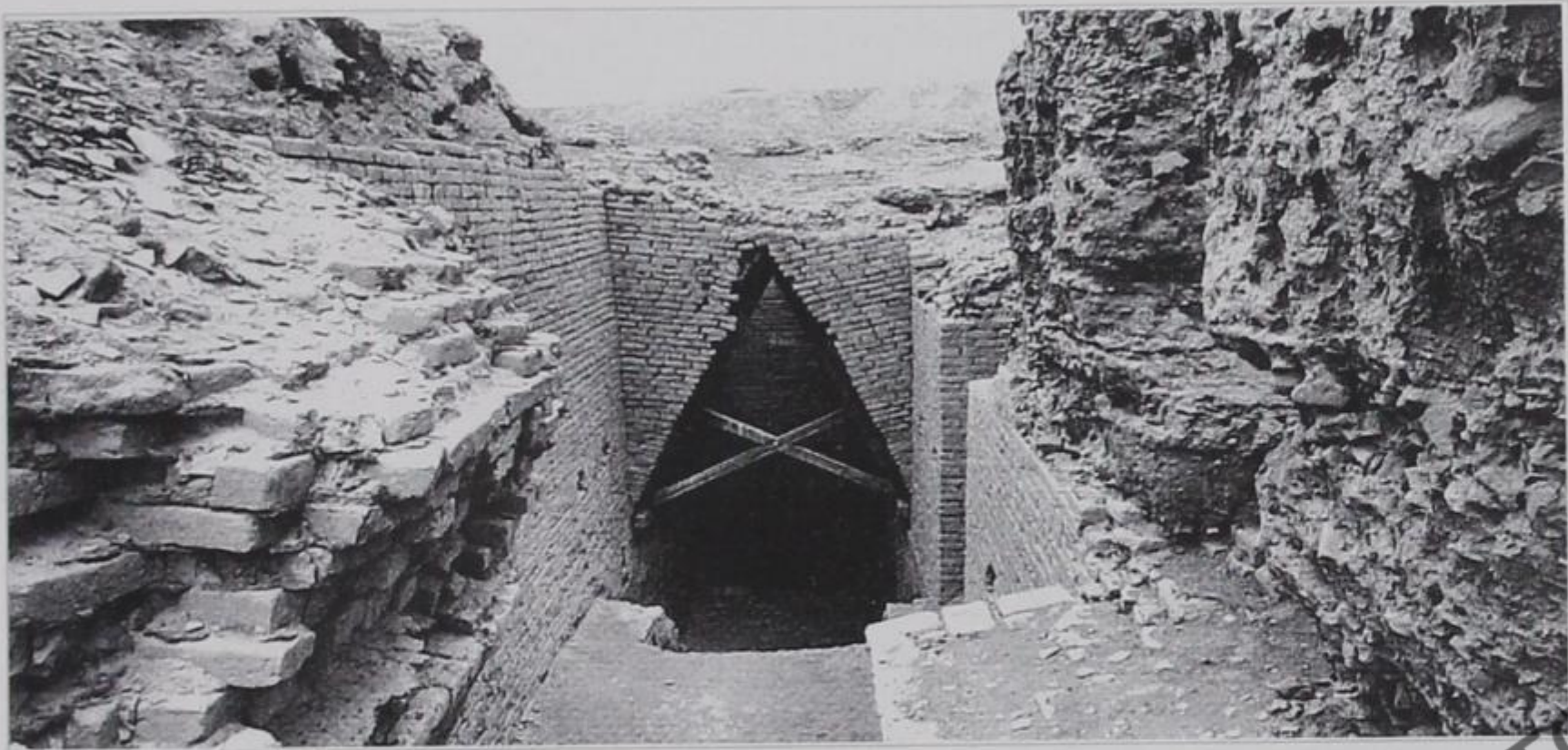
Εικ. 2. Κάλυψη με εκφορικό τρόπο της εισόδου βασιλικής ταφικής κρύπτης της ΙΙΙ Δυναστείας της Ουρ, στην πόλη Ουρ, περιόδου 2100-2000 π.Χ. (Πηγή Α. Moortgat (21982), βλ. σημ. 1: από εικόνα του αριθ. 165, προβλ. κείμενο του σ. 108).
