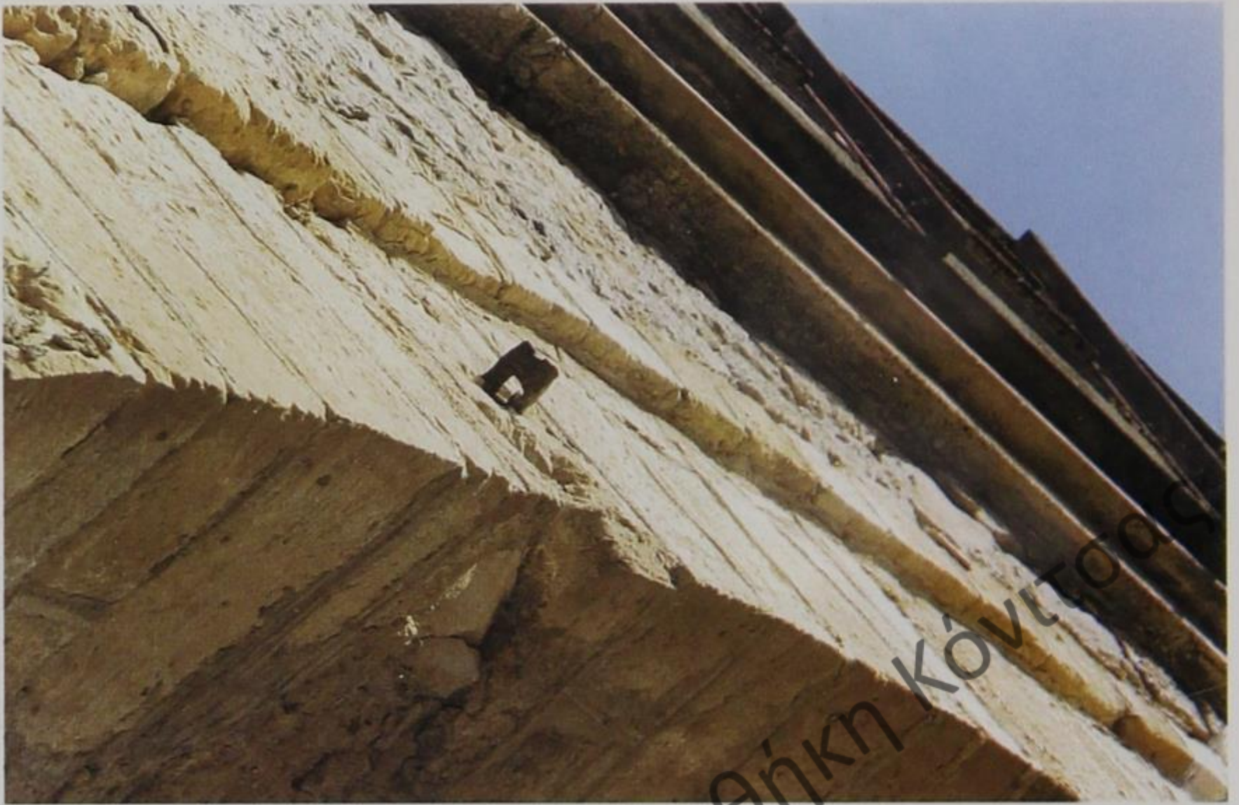
Εικ. 59. «Γεφύρι του Πασιά» στον Εμιλέα Φαρσάλων. 4ο τόξο από αριστερή όχθη. Όψη από ανάντη (= ανατολική). Διακρίνεται η άκρη διαμπερή ελκυστήρα στην τρύπα της οποίας πέραναγε η κάθετη αγκύρωση, η κατ' εξοχήν «άρπεζα» (: Φωτ. 07 Αυγ. 2000, Α.Π.: Φ.00, VII/τ. αριθ. Ε).
