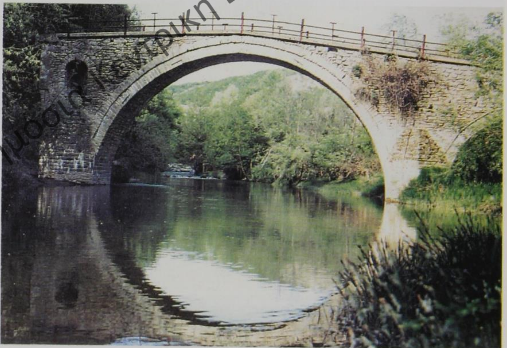
Εικ. 69. Γεφύρι Τσιούκαρη στην Πραμόρτσα, έργο μεταξύ 1886-1890. Η μεγάλη καμάρα: διακρίνονται οι 4 «άρπιζες». (Φωτ. 1987: Γ. Τσότσος, 1997, σ. 75 εικ. 39).
