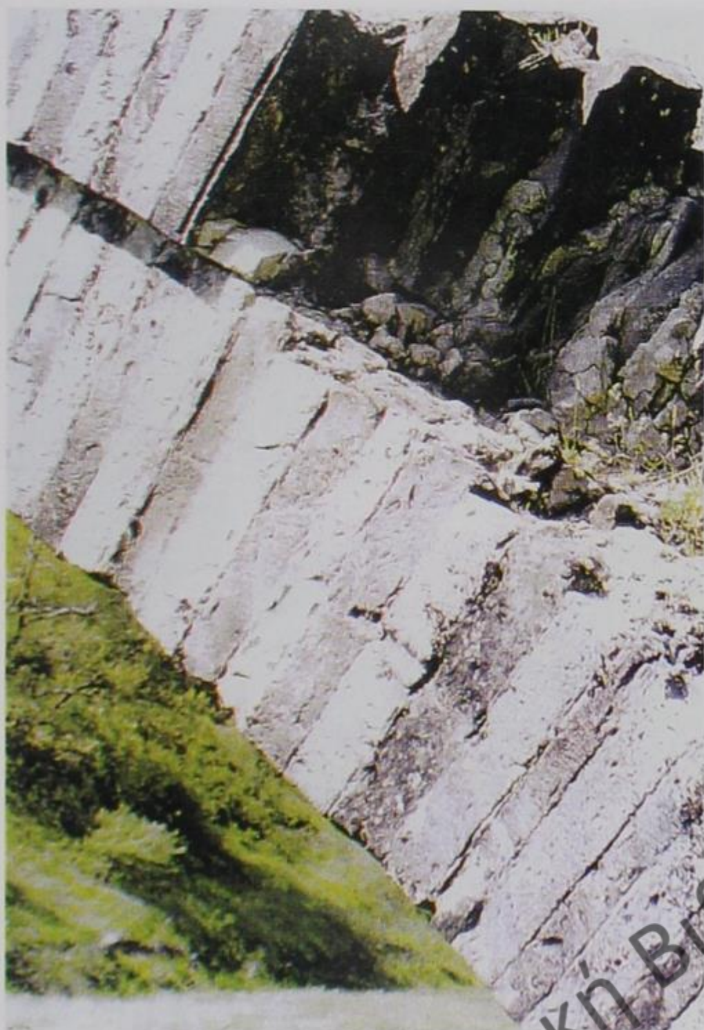
Εικ. 58. «Γεφύρι της Κυράς» ή της «Μπαλγιούμας» στον Άραχθο, 1762. Λεπτομέρεια. Κάτω τόξο («στεφάνι») και δεύτερο υπερκείμενο διαμπερούς διάταξης (Φωτ. Α.Π. 10.5.1995: Β. Παπαγεωργίου / Α. Πετρονώτης, σ. 304 εικ. 17).
