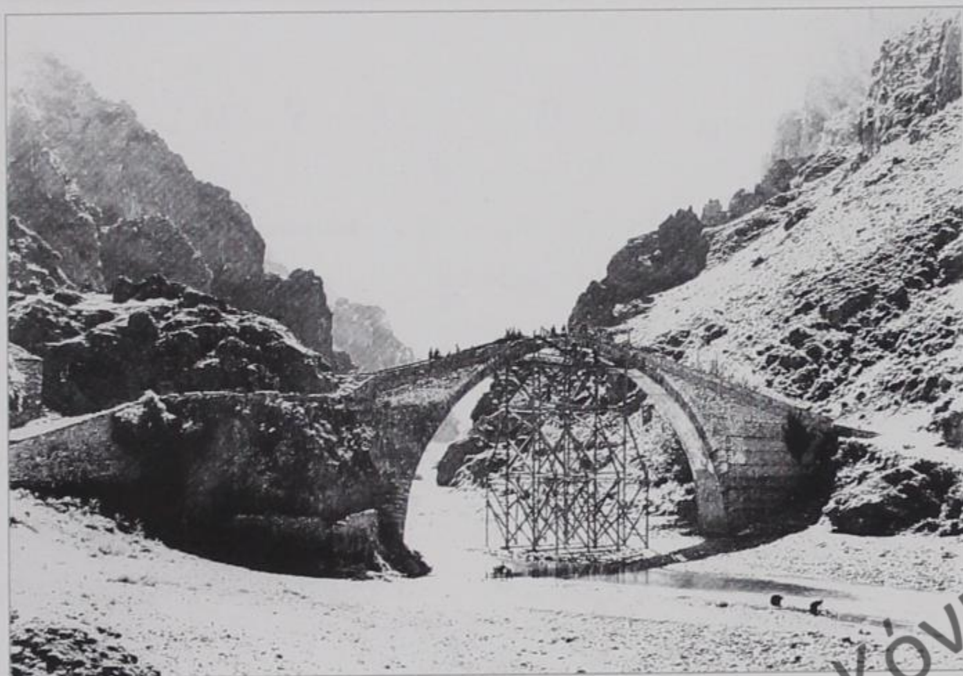
Εικ. 32. Γεφύρι Κόνιτσας στον Αώο. Έργο 1869-1870 Πυρρογιαννίτη πρωτομάστορα Ζιώγα Φρόντζου (π. 1815 - π. 1893). Εδώ επισκευάζεται μετά τον βομβαρδισμό του το 1913 από τον υποχωρούντα τούρκο Γειαβίτ Πασά [προφανώς το ίδιο καλοκαίρι]. Τα στηρίγματα του καλουπιού πατήσανε στην κοίτη (Φωτ. Σπ. Μαντά, που αποδίδει στον Fr. Boissopoulos).
