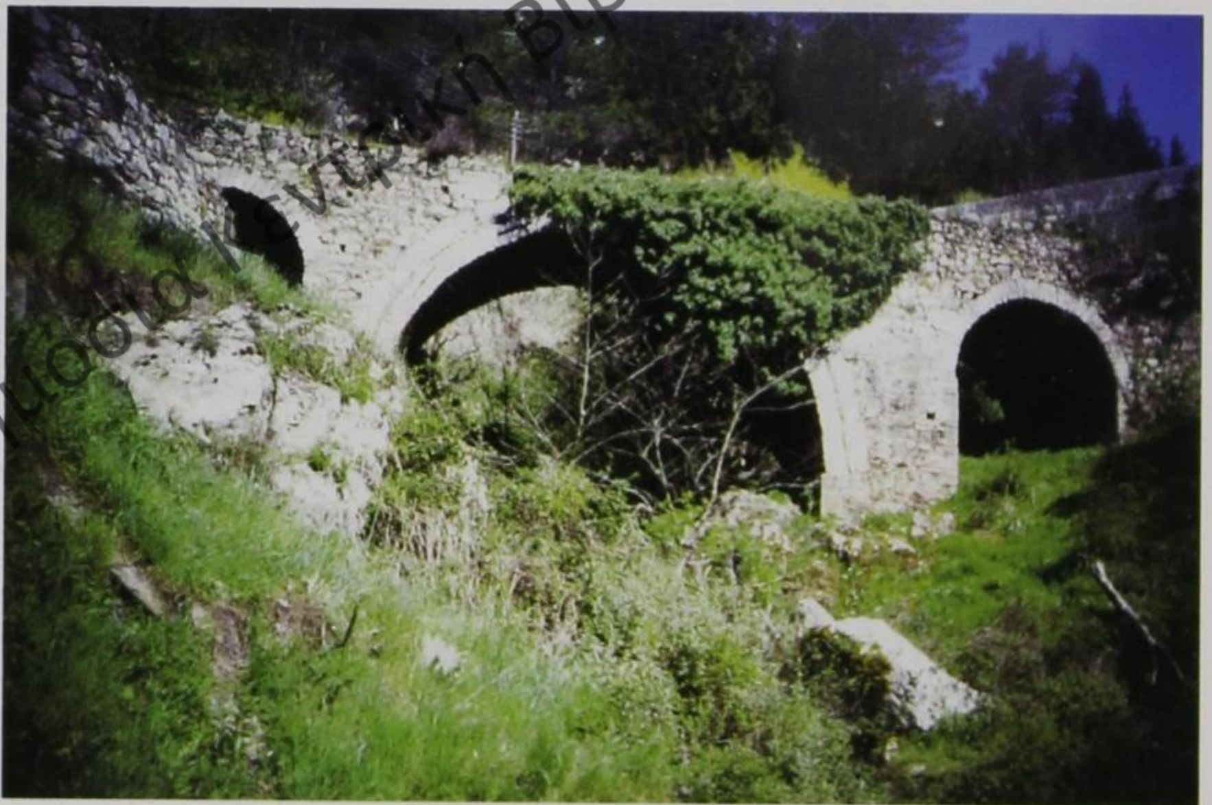
Εικ. 64A. Δημητσάνα. Τρίτοξη γέφυρα στα ανάντη κοιμητηρίου, κάτω από την χρησιμοποιούμενη σήμερα οδογέφυρα, κοντά στη Βρύση του Κουρή, 1851. (Φωτογραφία Γ. Ζαχαρόπουλου, Μεγάλη Δευτέρα, 09.04.2001).
