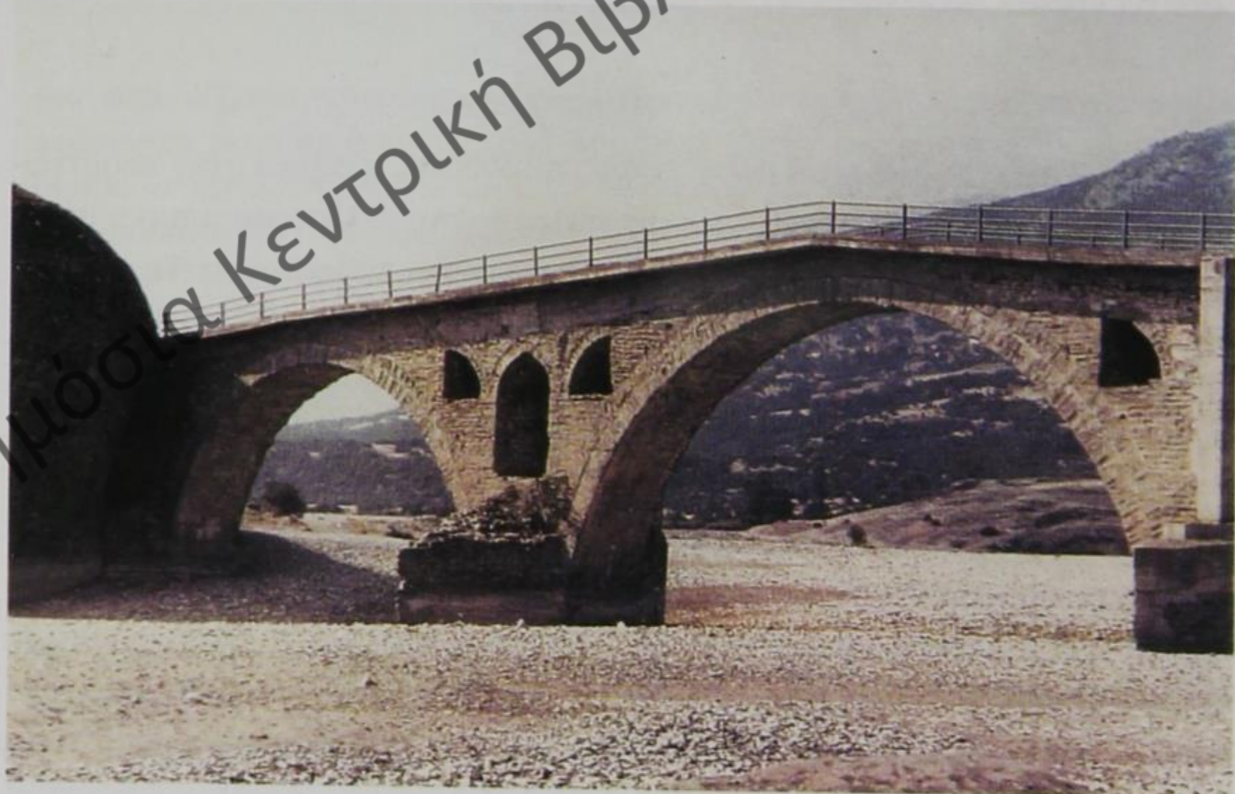
Εικ. 55. Γέφυρα Σαρακήνας, περιοχής Τρικάλων στον Πηνειό. Όψη από ανά- ντη. – Α' (επάνω): Φωτογραφία Δημ. Μιχαηλίδη θεωρούμενη του 1887. – Β' (κάτω): Λεπτομέρεια χαρακτηριστική μεσοβάθρου με 3 ανακουφιστικά τόξα, εξ ων τα δύο ιδιόμορφα τεταρτοκυκλικά. (Πηγή: Αντ. Γαλερίδης κ.Α. 1995, αντί- στοιχα σ. 199 / εικ. 159 και σ. 200 / εικ. 160).
