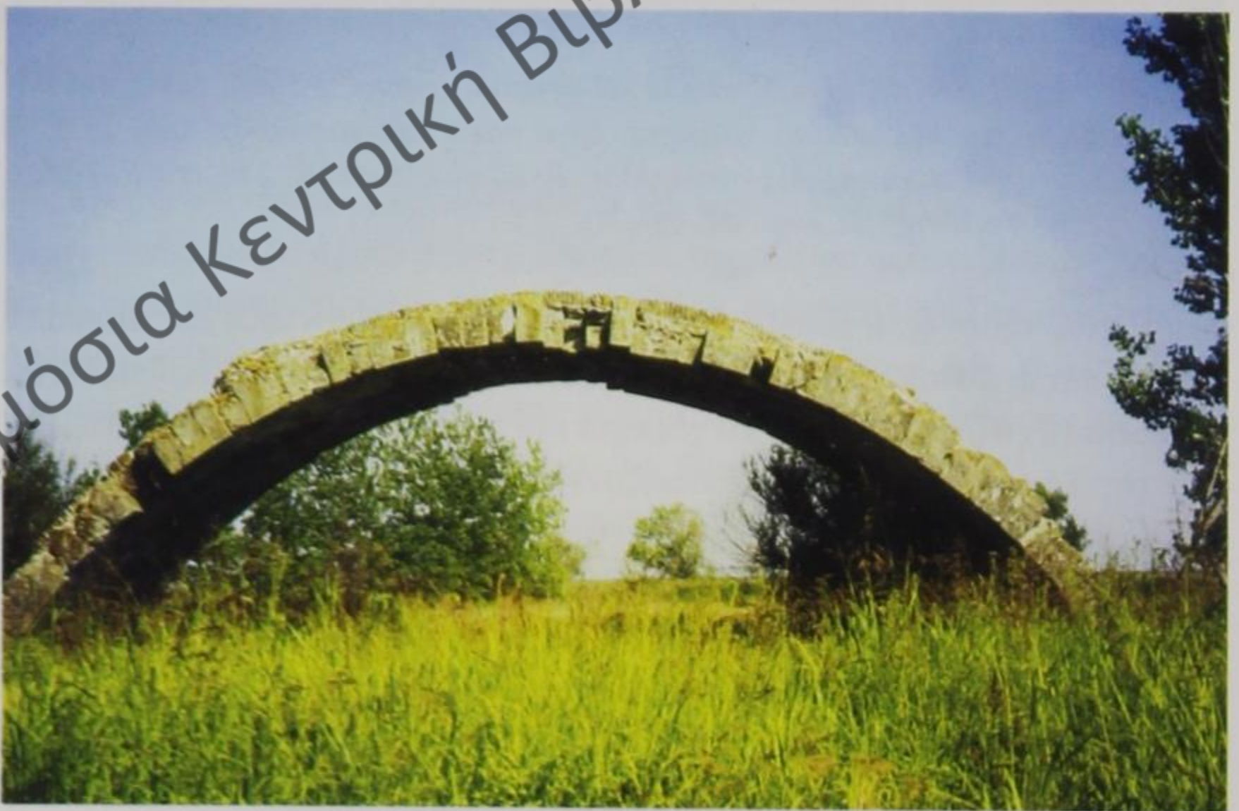
Εικ. 21. «Κλειδί» (κοντά στη Θεσσαλονίκη και στο ομώνυμο χωριό): το εναπομένον καλολαξευμένο λίθινο τόξο πολύτοξης ρωμαϊκής γέφυρας, έργο περί το 300 μ.Χ. επί του Λουδία, ο οποίος τώρα έχει αλλάξει κοίτη. Όψη από τα ανάντη (= βορειοδυτικά). (Φωτ. 2 Ιουλ. 2000. Φωτοθήκη Α.Π.: Φ.00.VI/1, αρ. 34).
