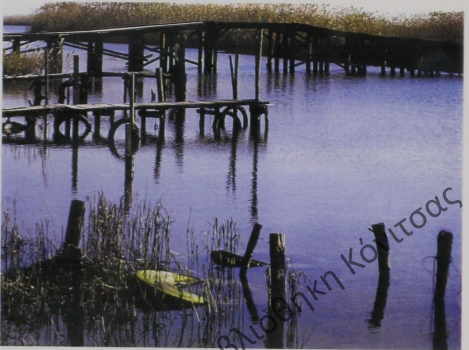
Εικ. 47Α. Ξύλινη γέφυρα και προβόλους επί ξυλίνων πασσάλων στο δέλτα του ποταμού Αξιού. (Πηγή: ποτάμια· υδάτινοι δρόμοι. Φωτογραφία Δημήτρ. Ταλιάνης. Κείμενο Γιάν. Ρούσσος. Επιμέλεια Αθηνά Δούντση. χ. τόπο έκδοσης: εκδόσεις «Τοπίο», χ.χ. ISBN 960-7646-19-3), σελ. 163).
