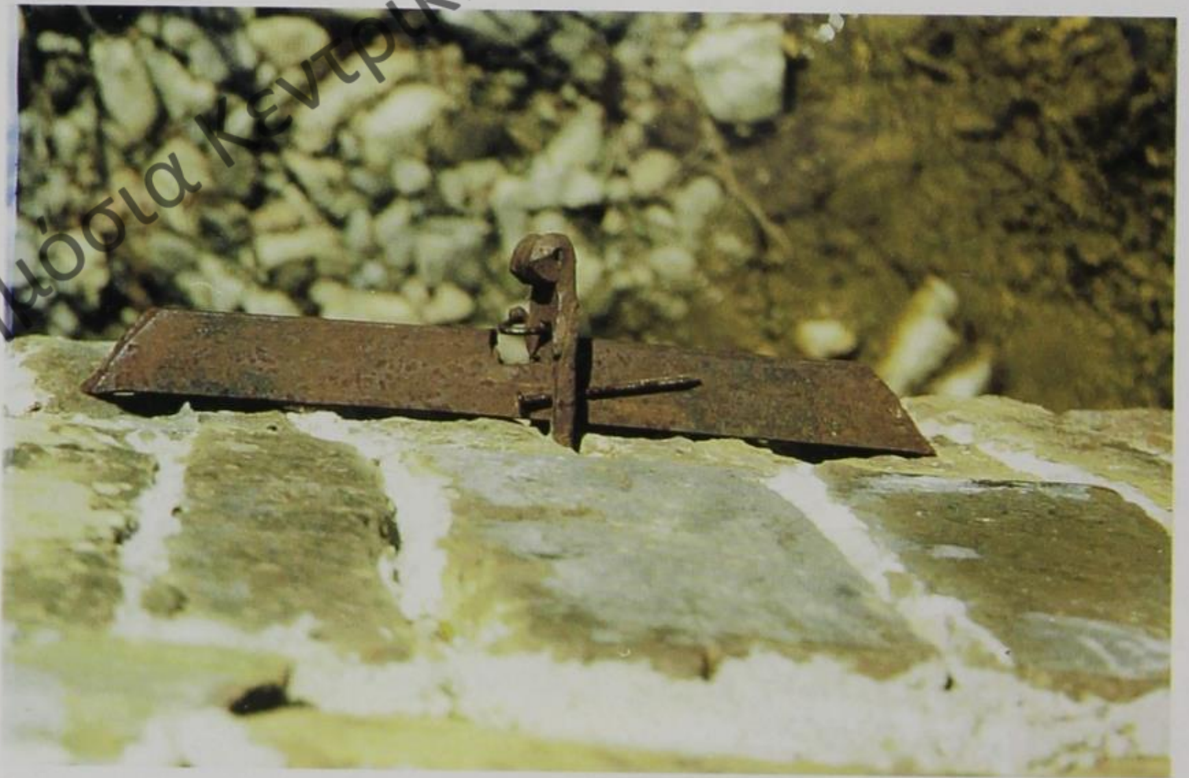
Εικ. 73Β. «Της Τοπόλ'τσας το Γεφύρι» (βλ. εικ. 72Α και Β, ιδίως 73Α). Λεπτομέρεια: Μια «άρπιζα», κοιτάζοντάς την από πάνω. (Φωτ. 1998 Α.Π.: Φ. 98.ΙΙΙ/1, αριθ. 36).
