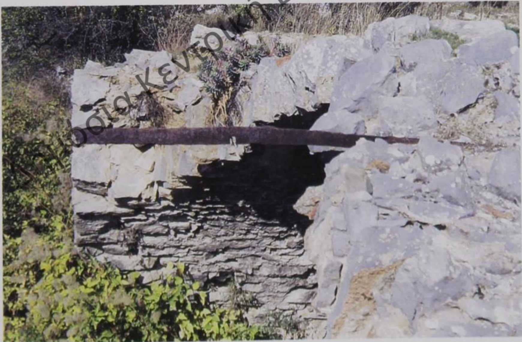
Εικ. 62Β. Ένας από τους δύο σιδερένιους ελκυστήρες του ισλαμίζοντος γεφυριού στον ποταμό Ελισσόνητα του κάμπου της Νταβιάς (βλ. εικ. 62Α). (Φωτ. 5 Νοεμ. 1998, Α.Π.: Φ. 98. ΧΙ/1, αριθ. 12).
