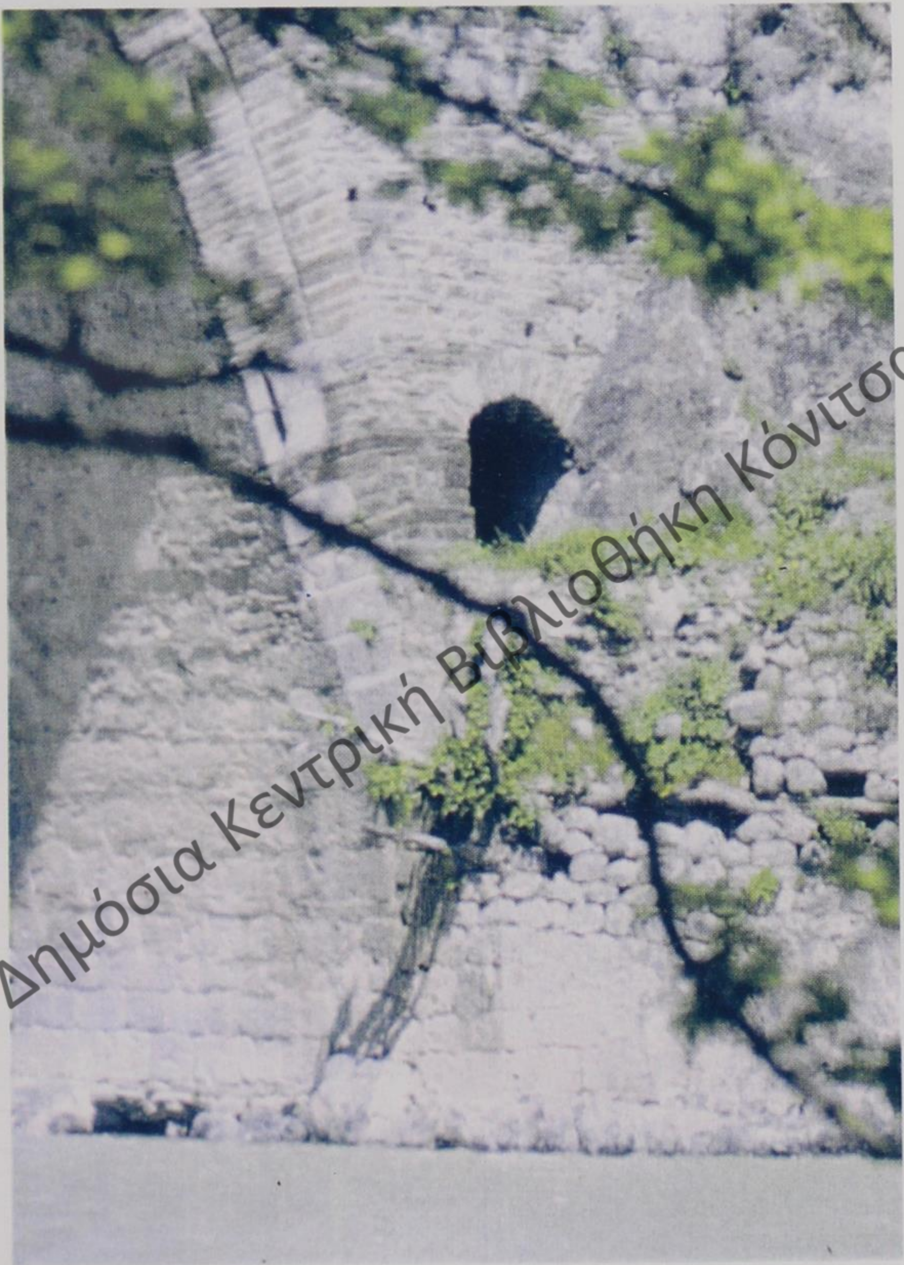
Εικ. 28. Αώος. Γέφυρα Κόνιτσας. Δεξιό (= βόρειο) ποδαρικό. Όψη από τα ανά- ντη. Διακρίνεται η (διαμπερής) καμάρα για το αυλάκι νερού (1995).
