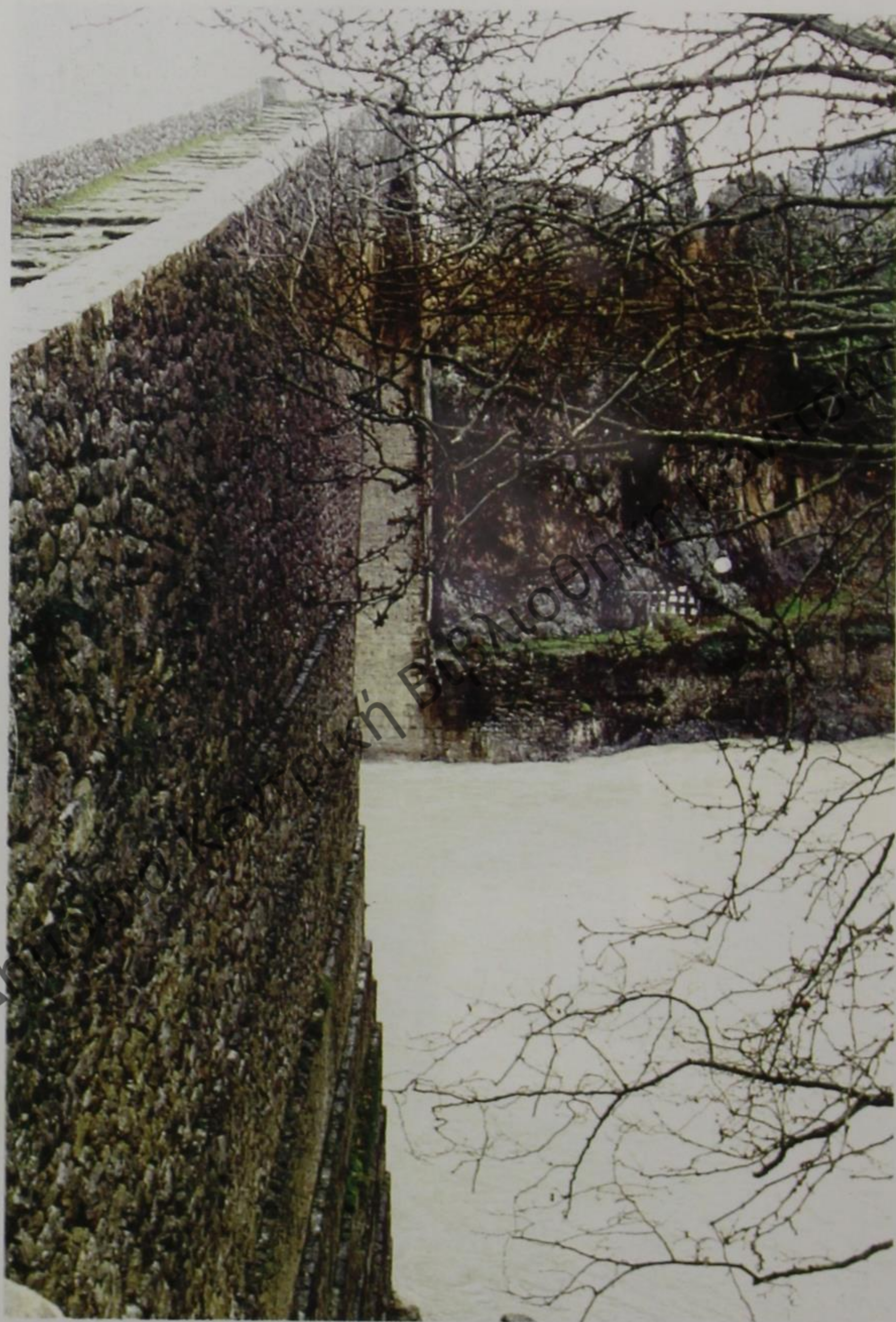
Εικ. 31. Αώος. Γέφυρα Κόνιτσας. Η προς τα ανάντη (ανατολική) πλευρά, φωτογραφημένη από το νότιο (αριστερό) ποδαρικό (1996).
