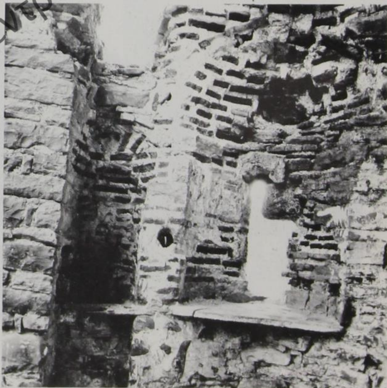
4. Μολυβδοσκέπαστο, ναός Αγ. Δημητρίου· οι κόγχες της βόρειας πλευράς του ιερού
