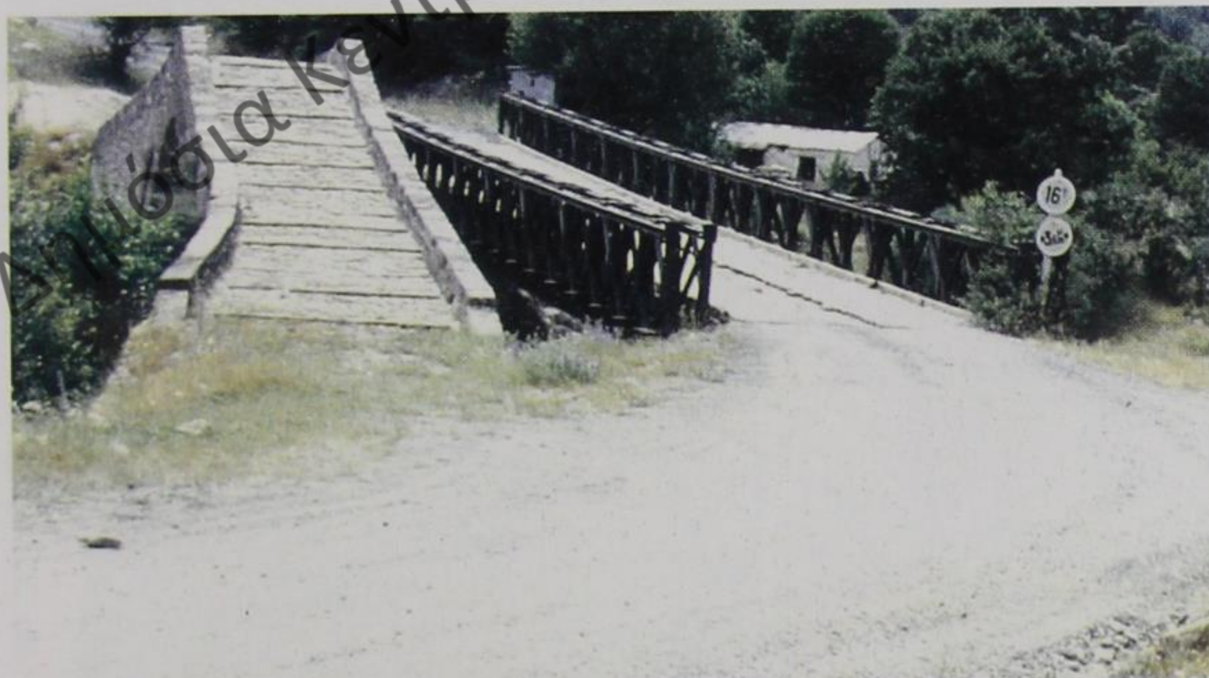
Εικ. 11Α. Σαραντάπορος. Γεφύρι της Ζέρμας ή Καντζιώτικο Γεφύρι. Το παλιό γεφύρι με ανανεωμένο κατάστρωμα, και η νεώτερη μεταλλική γέφυρα «Μπέλε-ϋ». Όψη από βορρά, προς την κατεύθυνση του χωριού Δροσοπηγή (πριν Κάντσι-κο). (1995).
