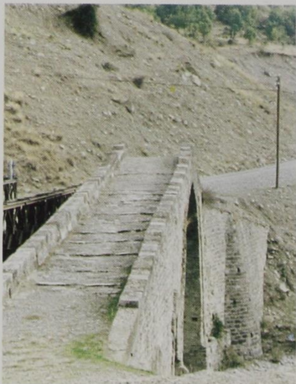
Εικ. 7. Σαραντάπορος. Γεφύρι της Ζέρμας είτε Καντζιώτικο γεφύρι. Μεσόβαθρο επί βράχου, με έμβολο και τόξο (αμφότερα για ανακούφιση του βάθρου στην περίπτωση πλημμύρας) Όψη από τα ανάντη, (1995).
