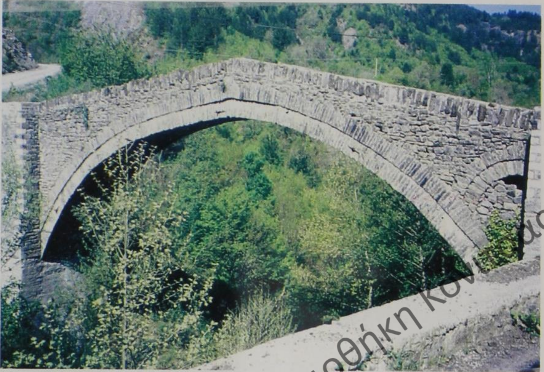
Εικ. 19. Πουρνιά Κόνιτσας. Γέφυρα Μαύρης Πέτρας. Όψη από τα ανάντη. Δεξιά (= ανατολικά) το φαινομενικά τεταρτοκυκλικό ανακουφιστικό τόξο. (1995).
