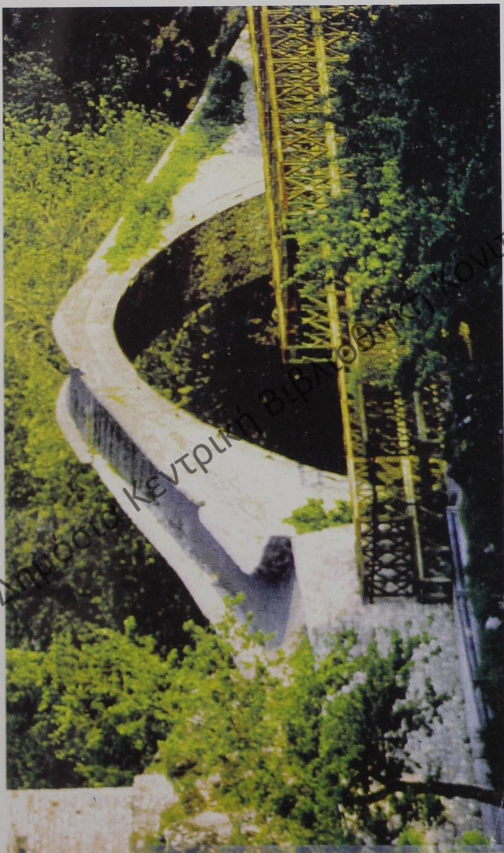
Εικ. 32. Αώος. Οι γέφυρες της Κόνιτσας: η παλαιά πέτρινη τοξωτή και η νεώτερη μεταλλική επιφιέρειστη Bailey «Μπέλεϋ» (1995).
