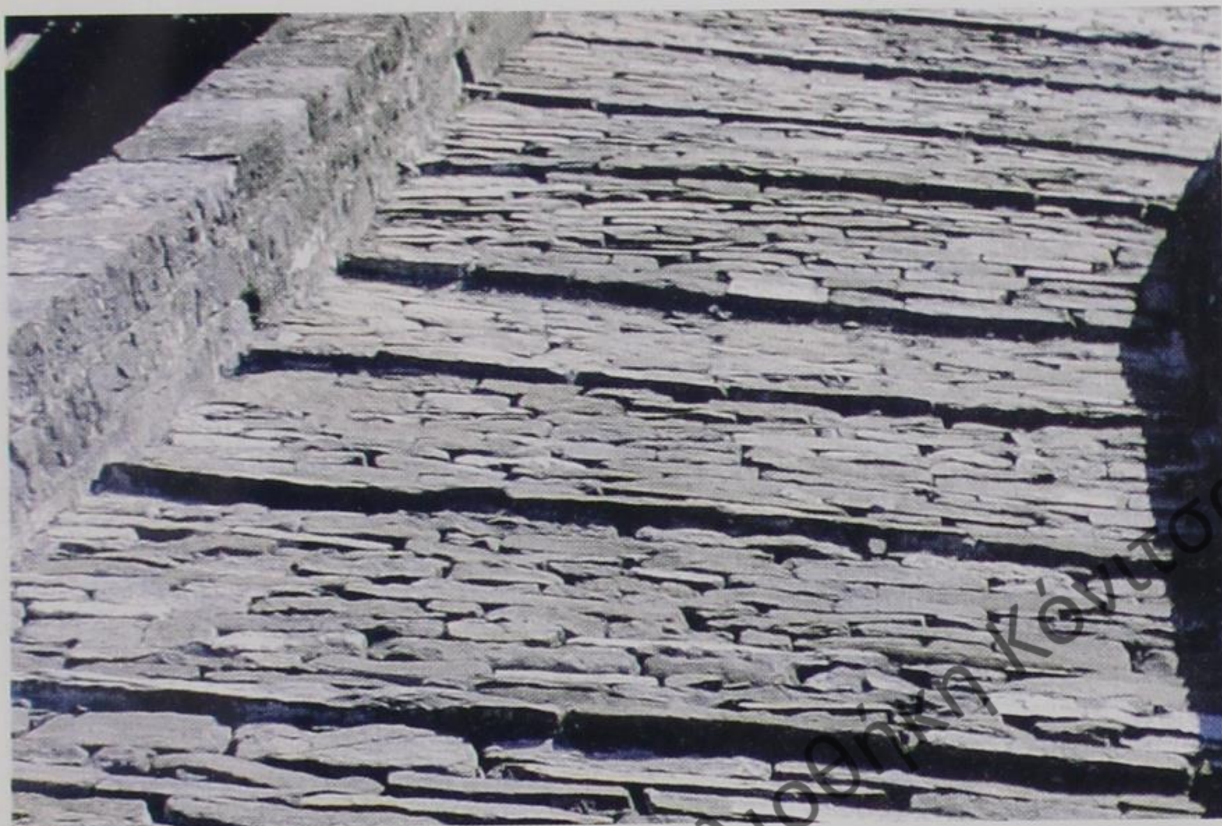
Εικ. 11. Σαραντάπορος. Γεφύρι της Ζέρμας, είτε Καντζιώτικο Γεφύρι. Ανακατασκευή λιθοστρώτου· είναι το κατεχομένο τμήμα πάνω από τη μεγάλη καμάρα που οδηγεί προς την εθνική οδό (Φωτογραφία 1995).
