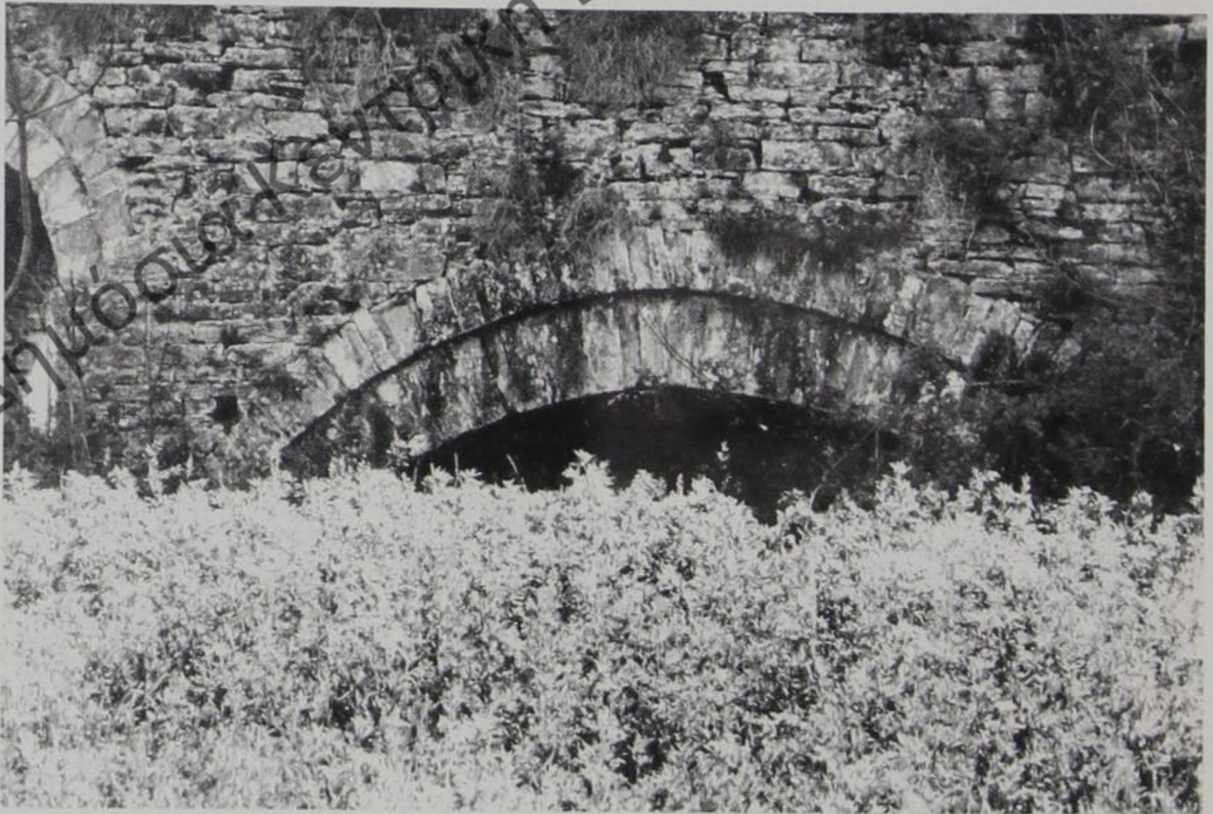
Εικ. 15. Άραχθος. Νότια από τη «Μπαλντούμα». Το μικρότερο (υπάρχον) τόξο παλαιού γεφυριού. Όψη από τα ανάντη (1995).
