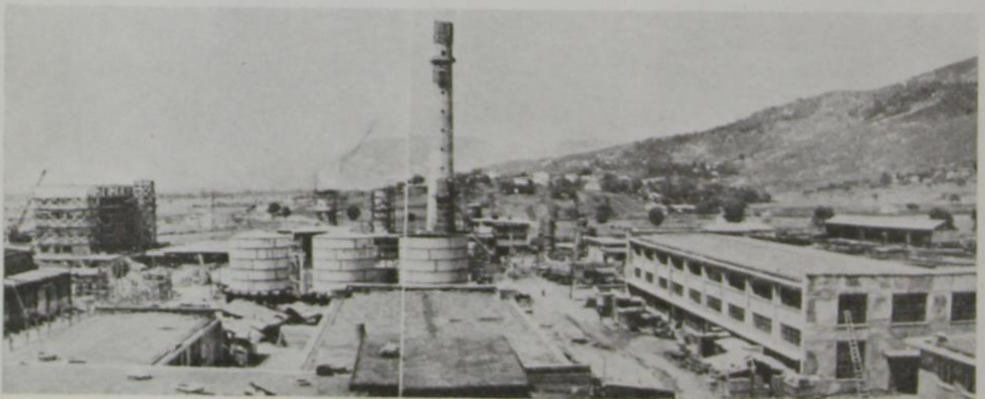
Μερική άποψη του εργοστασίου υπερφωσφορικῶν λιπασμάτων στό Λάτς
