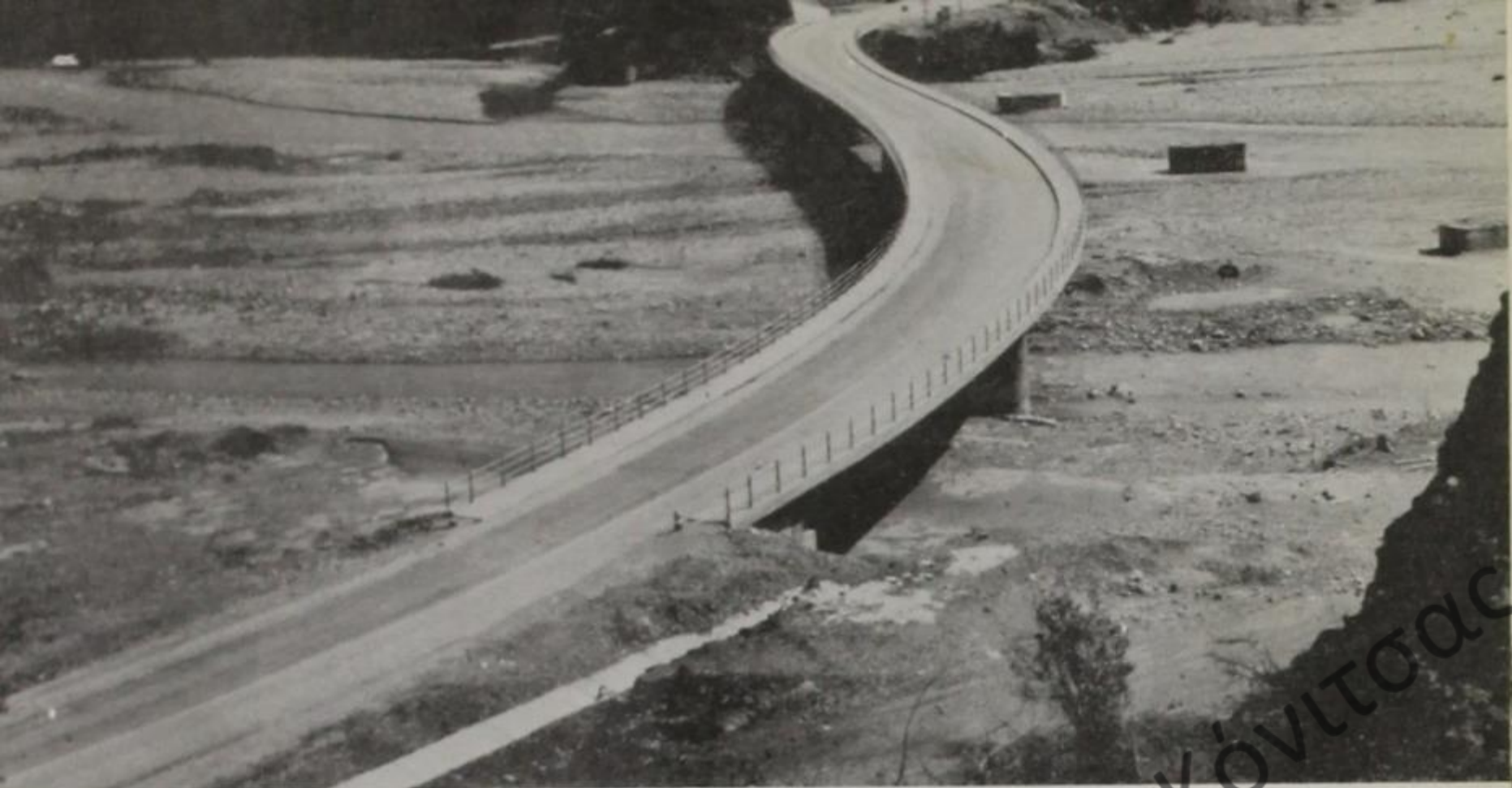
Γέφυρα Σπηλιωτοπούλου-Εθνική οδός Ιωαννίνων - Κονίτσης - Νεαπόλεως Κοζάνης
