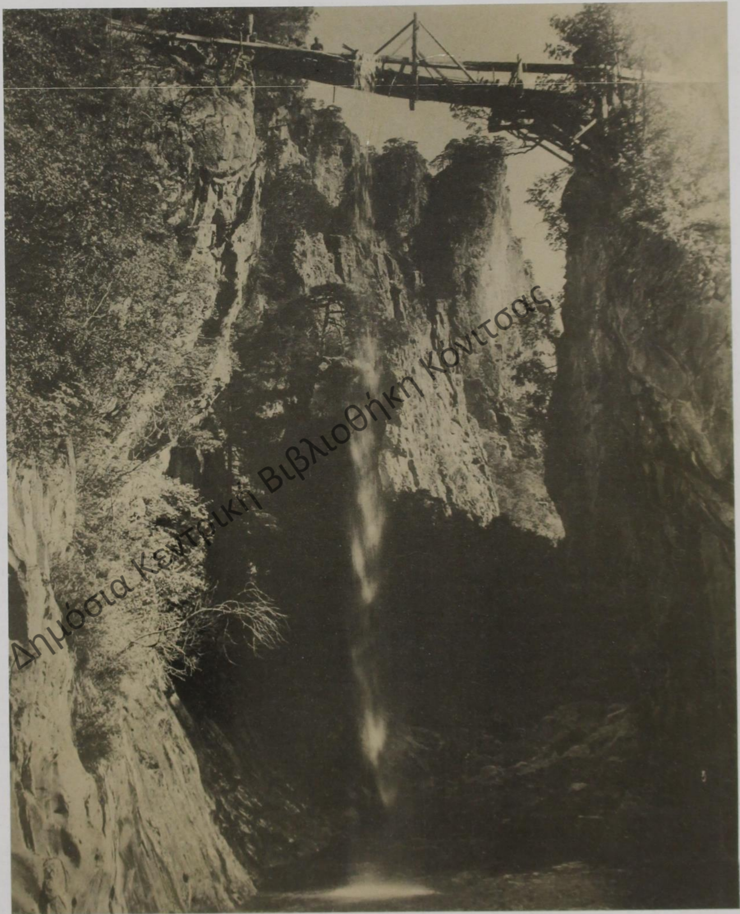
3. Ευλογέφυρο στον Αώο, περιοχή Στομίου, το 1938.
