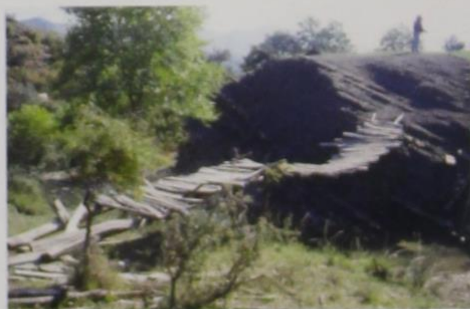
Ξύλινο γεφύρι στο Καβαλάρι
