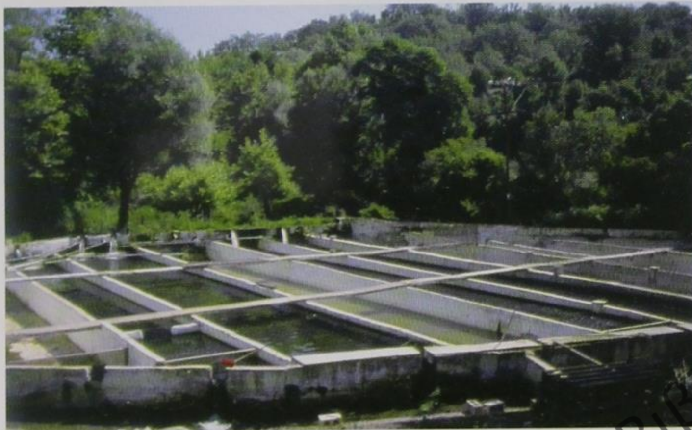
Ιχθυοτροφείο στο Λούρο
