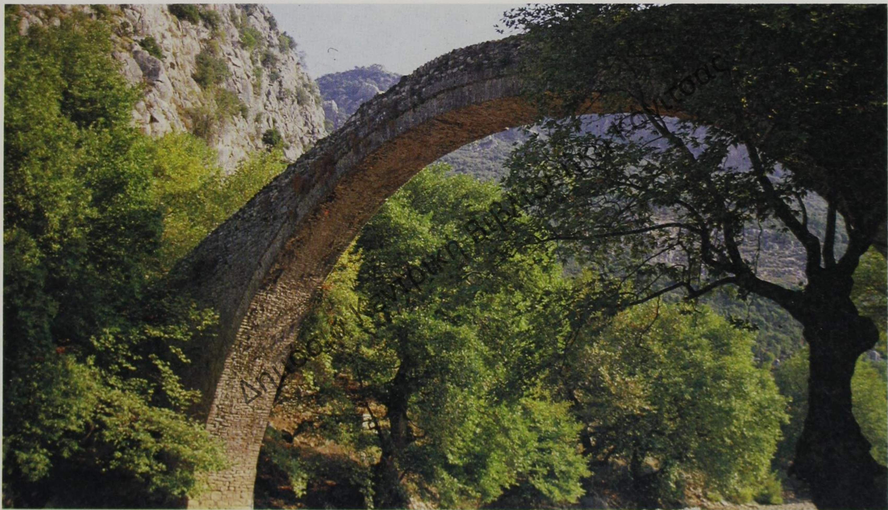
77. Με ένα και μοναδικό τόξο ανοίγματος 34,5 μέτρων, το γεφύρι της Πόρτας είναι χτισμένο με πελεκημένες πέτρες αντί των σχιστόλιθων που συνηθίζονταν στην κυρίως Ήπειρο.
