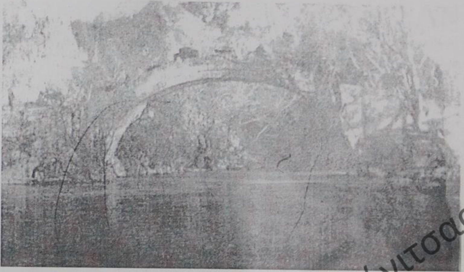
Η γέφυρα του Βοϊδομάτη η διάβαση της οποίας επέτρεψε την προχώρησιν των φαλάγγων ενισχύσεως προς την πολιορκημένην πόλιν.
