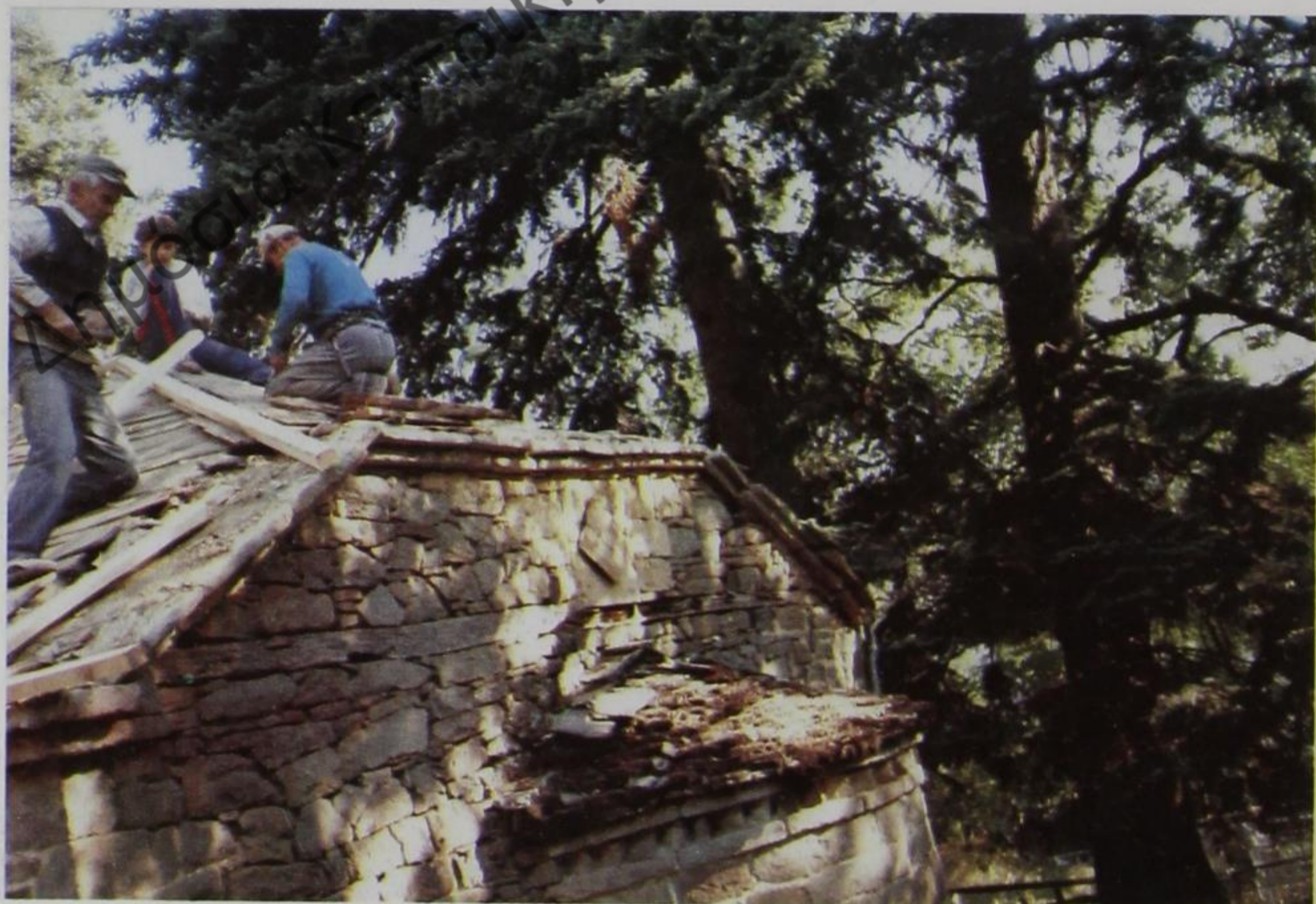
Αϊ-Νικόλας – Επισκευή της οροφής
