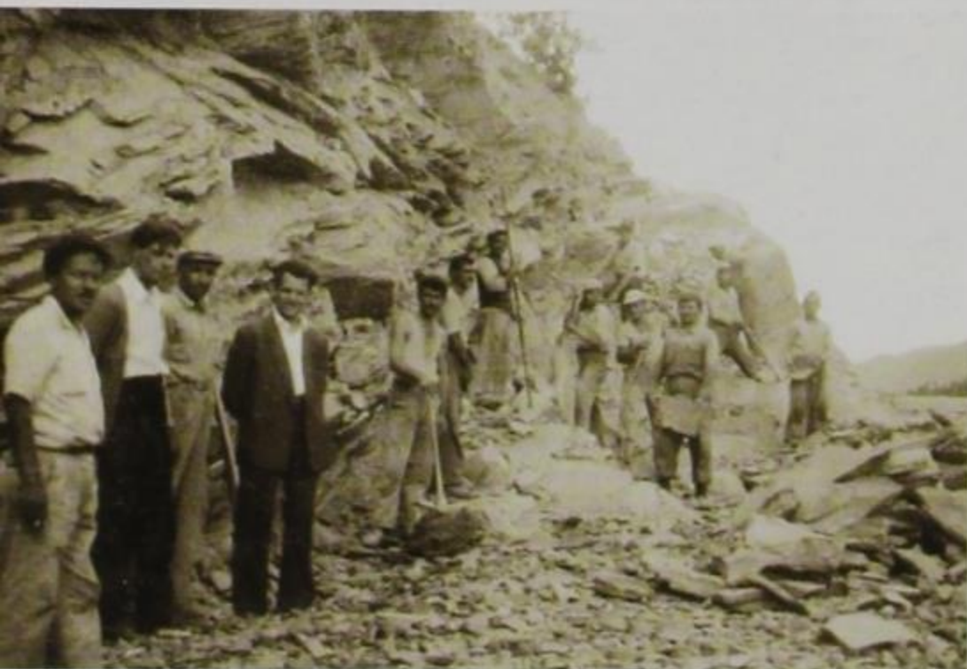
Διάνοιξη εθνικής οδού Κονίτσας-Κοζάνης (θέση Κλειδί), 1958.
