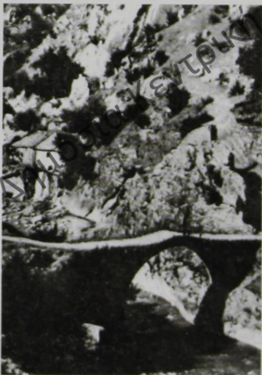
Πέτρινο γεφύρι στο Βουρμπιανίτικο (1872). Στο βάθος διακρίνεται ο Σελτσιώτικος μύλος.
