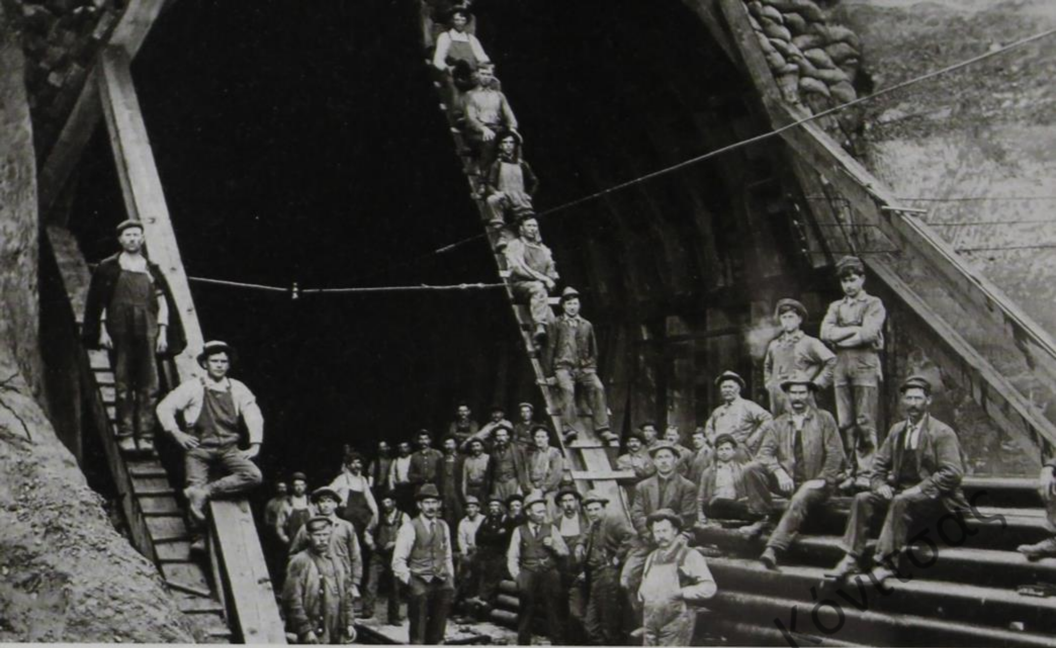
1927 Ηπειρώτες μαστόροι σε εργασίες διάνοιξης σιδηροδρομικής γραμμής, Ντιρόντ ΗΠΑ.
