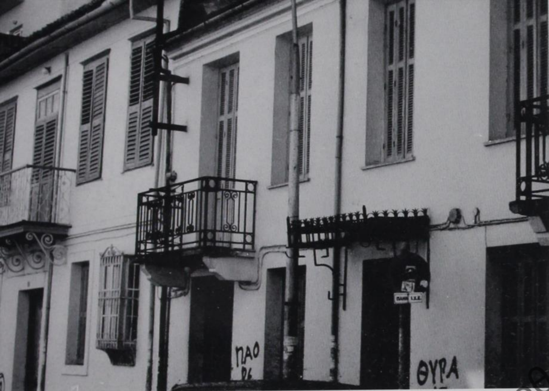
117-118. Γιάννινα. Όψιμη παράδοση στις σιδηροκατασκευές (117), χαρακτηριστικά καφασωτά με "φρύδια" και φεγγίτη στην πόρτα (118).
