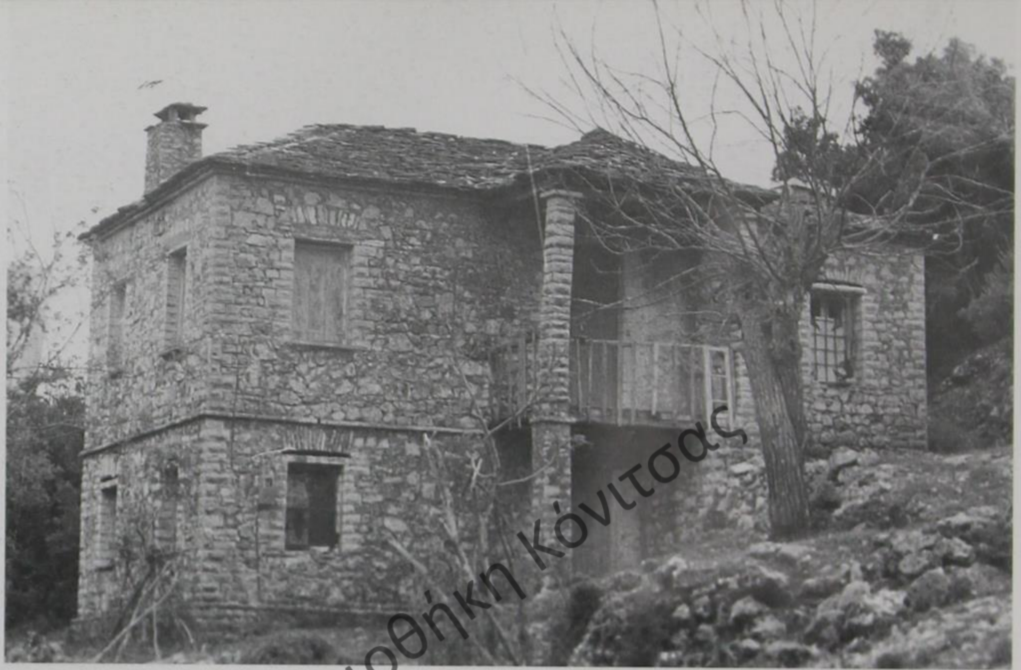
92. Άμπελοχώρι Τζουμέρκων. Χαρακτηριστικές περι- πτώσεις τοιχοδομής, στε- γασμένου εξώστη, υπέρ- θυρων κ.λπ. στα δύο δια- φορετικά σπίτια.
