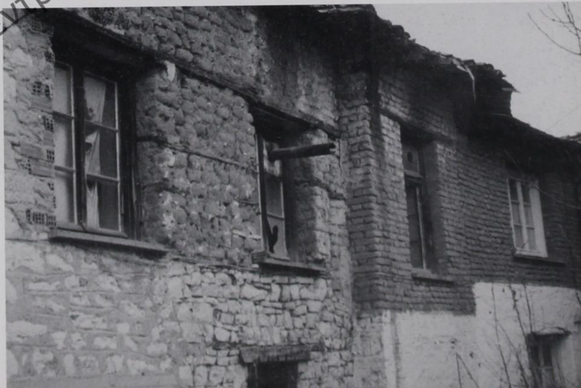
113-114. Στά Γιάννινα. Σοβᾶς και ἐκδοχῆς στὴν πρόσοψη (πάνω), τοιχοποιΐα με πλινθοδομή (κάτω).
