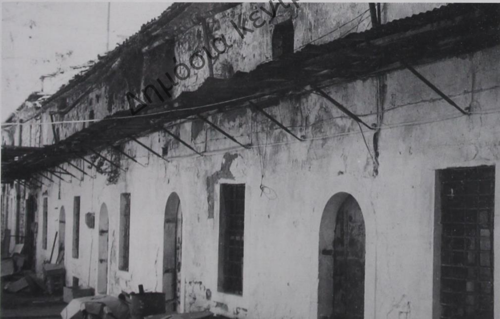
190-191. Στοά Λιάμπεη (190) και στοά Γαμπάϊ (191) στά Γιάννινα.
