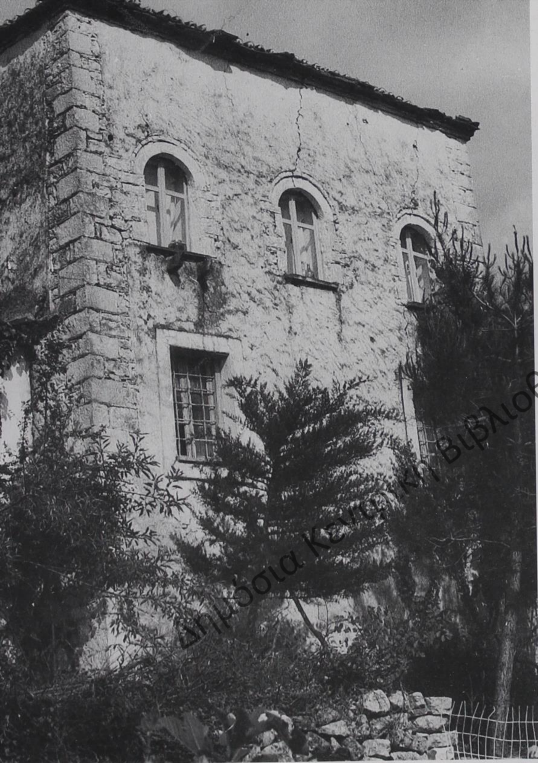
43. Πυργόσπιτο στην Παραμυθιά. Κομσὴ καὶ προσεγμένη οἰκοδομή, μὲ σιδηροκατασκευὲς καὶ φου- ρούσια κάτω ἀπ' τὰ χαρακτηρι- στικὰ παραθύρια.
