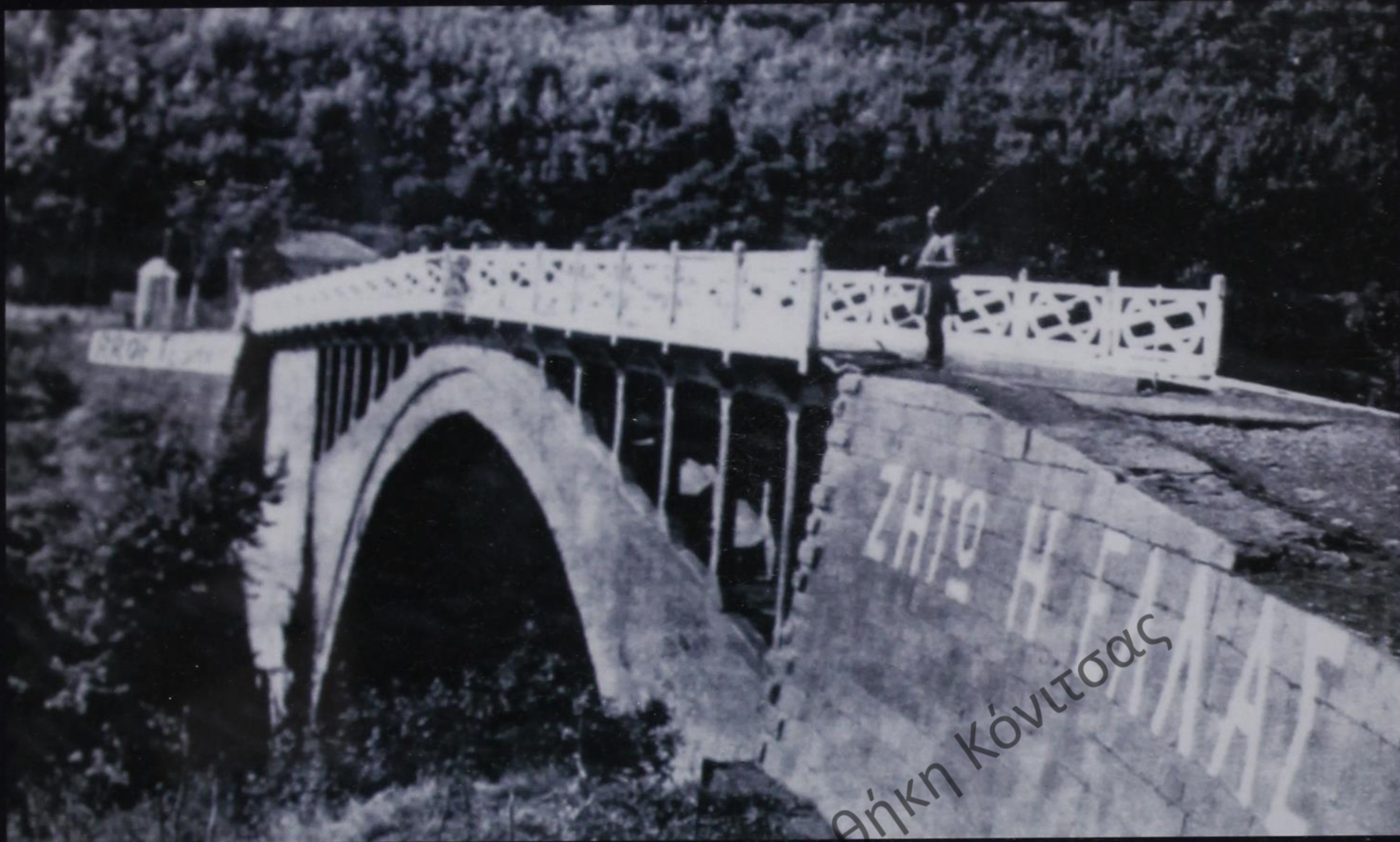
Η γέφυρα της Μέρτζανης, με τους συνοριακούς σταθμούς Ελλάδος και Αλβανίας εκατέρωθεν αυτής, διέσχισε τα νερά του Σαραντάπορου μέχρι τον Β' Παγκόσμιο Πόλεμο, οπότε και ανατινάχτηκε.
