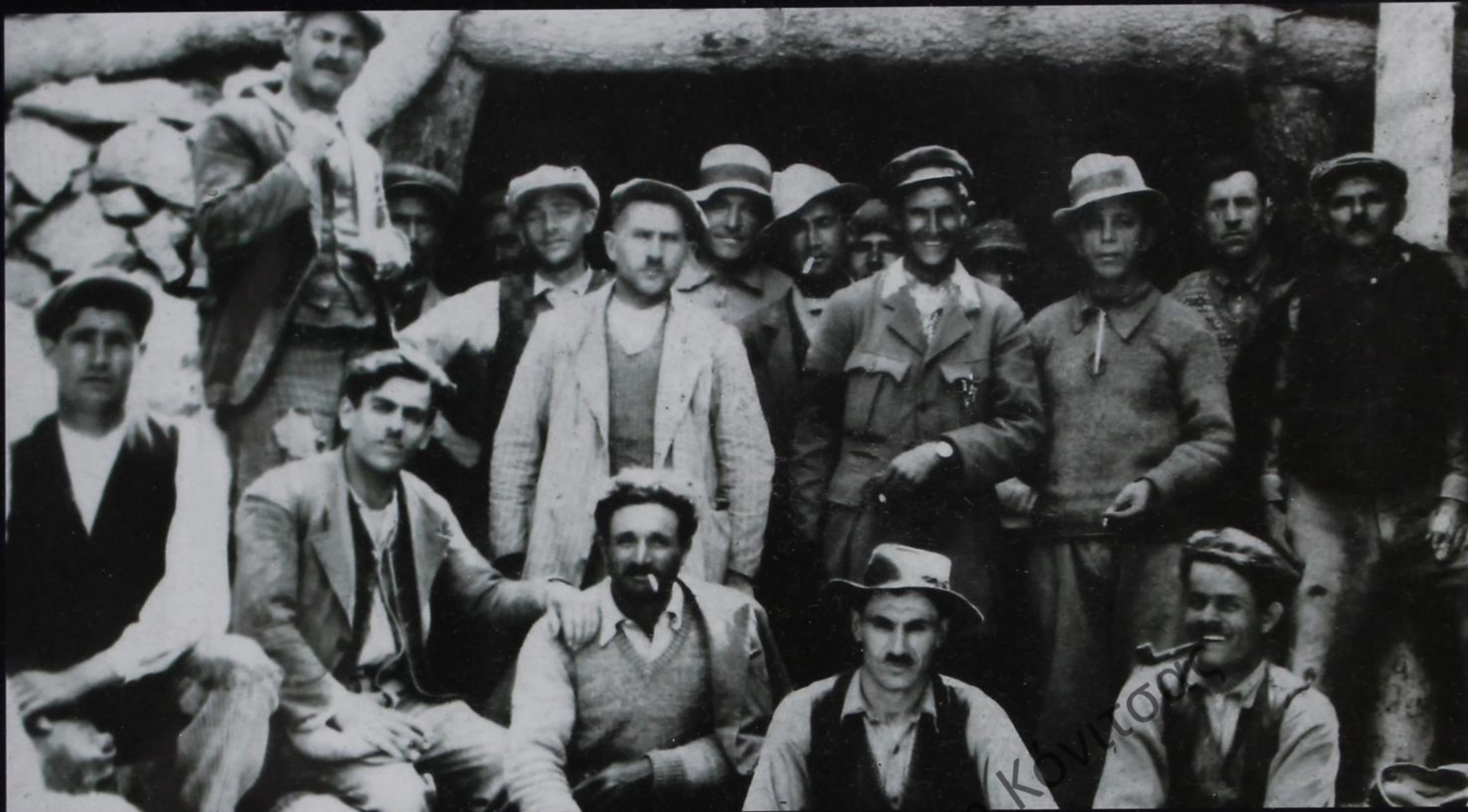
Περσία. Ηπειρώτες και Δυτικομακεδόνες (Ντολιανιάτες) μαστόροι σε έργα κατασκευής σηράγγων, το 1935. Persia. Craftsmen from Epirus and Western Macedonia (Ntoliianiates) in tunnel construction works, in 1935.
