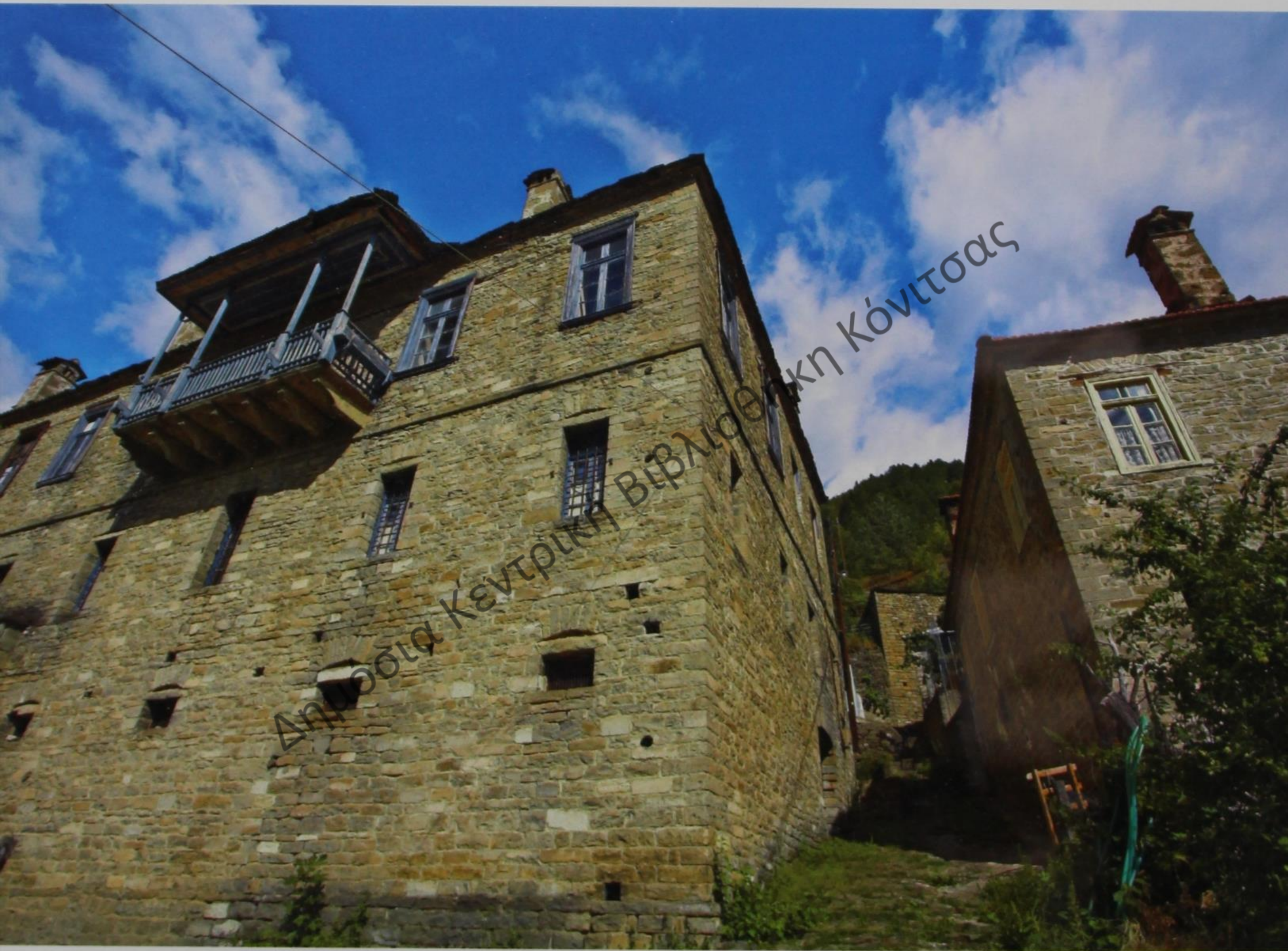
Οι μαστόροι της Καστάνιανης εξήντησαν τις αρχιτεκτονικές και τεχνικές τους δεξιότητες στην κατασκευή των δημόσιων και ιδιωτικών κτηρίων του χωριού τους. Επάνω, αρχοντικά του χωριού και δεξιά ο καθεδρικός ναός του Αγίου Νικολάου και το Δημοτικό Σχολείο.
