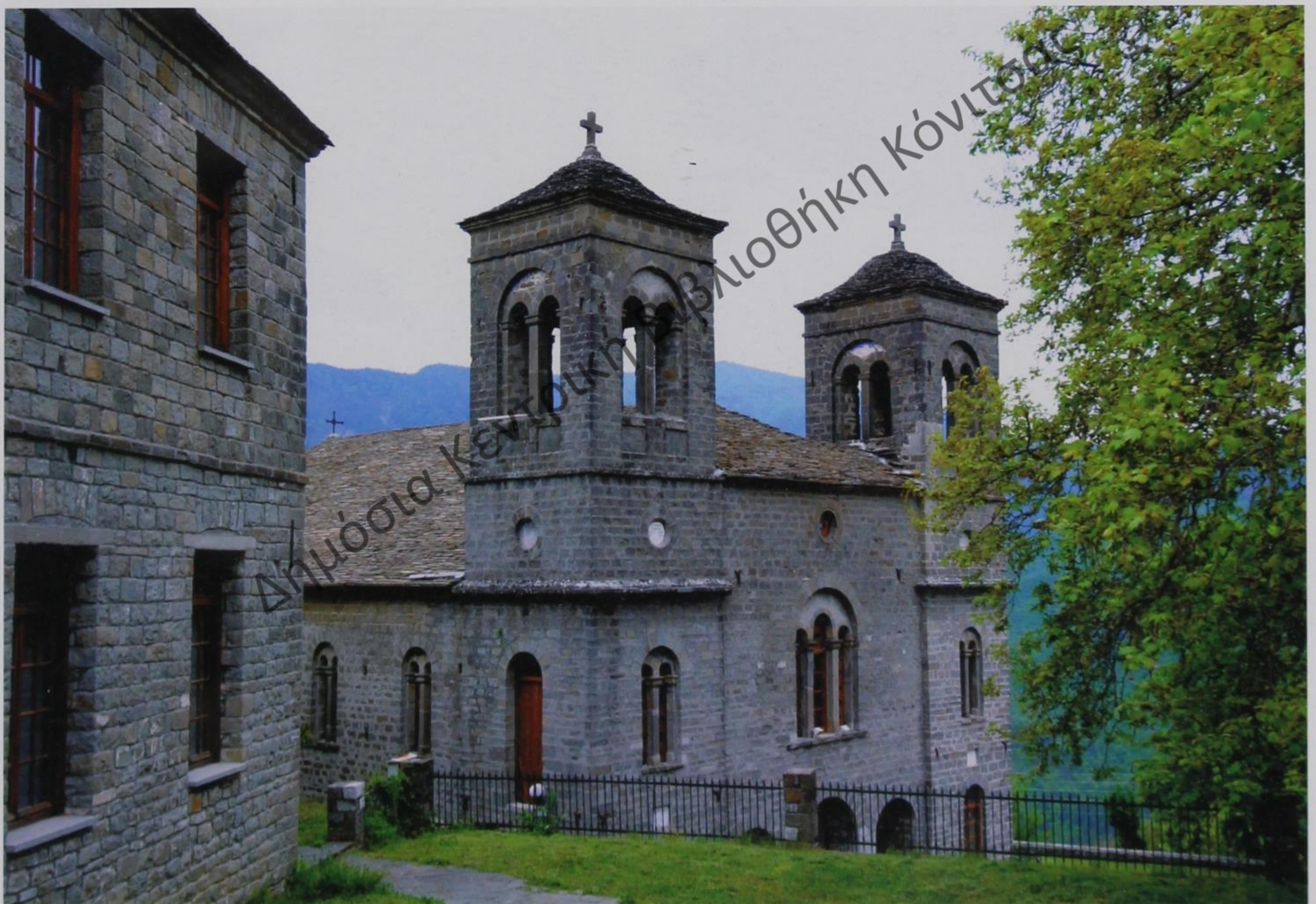
Ο ενοριακός ναός του Αγίου Γεωργίου στην Πυρσόγιαννη, με το χαρακτηριστικό διπλό καμπαναριό, χτίστηκε το 1904 στη θέση παλαιότερου ναού και βρίσκεται δίπλα στο σχολείο του χωριού, το οποίο σύντομα θα στεγάσει το Εθνολογικό Μουσείο Ηπειρωτών Μαστόρων.
