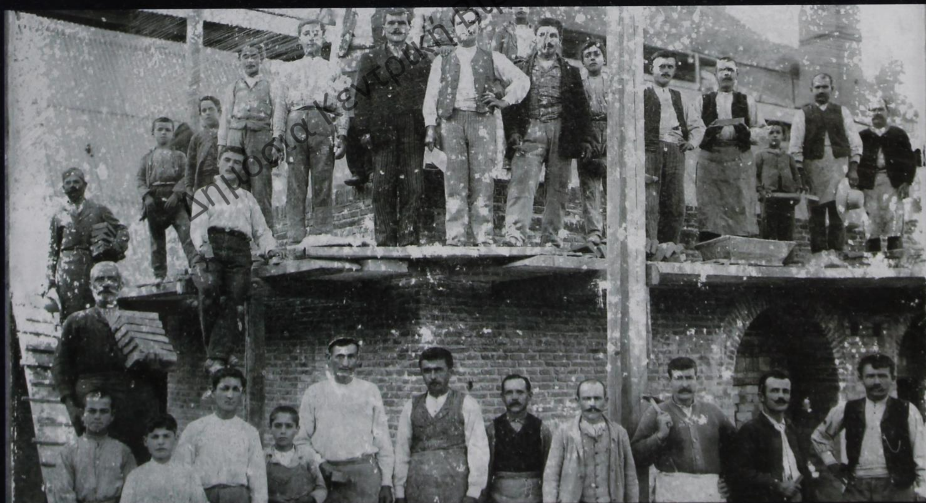
Λίμνη Ευβοίας, Βουρμπιανίτες μαστόροι στην σκαλωσιά, το 1914. (Μαστόροι-χτίστες από τα Μαστοροχώρια της Κόνιτσας, 2009 σελ. 153-Μαστοροχώρια, 2004, σελ.64-Αρχείο περ. «Αρμολοί» και Μουσείο Ηπειρωτών Μαστόρων, Πυρσόγιαννη). Limni Evias. Craftsmen from Vourmpiani on a scaffolding, in 1914. (Craftsmen-builders from the Mastorohoria of Konitsa, 2009 p. 153 - Mastorohoria, 2004, p. 64 - "Armoloi" archive and Museum of Epirotic Craftsmen, Pyrsogianni).
