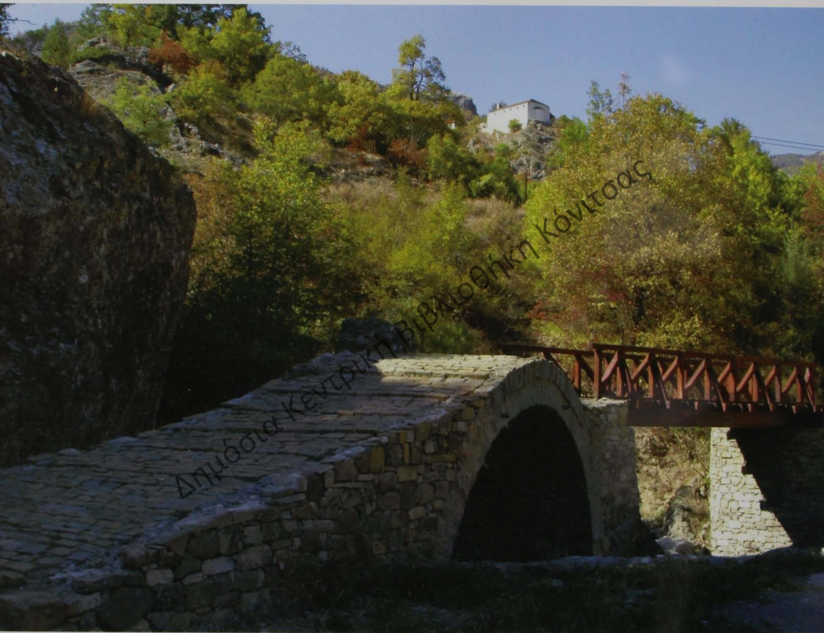
Το γεφύρι στο Παρασπόρι, λίγο πριν από το χωριό Χιονιάδες και στο βάθος ο ενοριακός ναός της κοινότητας, αφιερωμένος στον Άγιο Αθανάσιο. The bridge in Paraspori, just before Chioniades village and in the background the parish church of the community, dedicated to Saint Athanasios.
