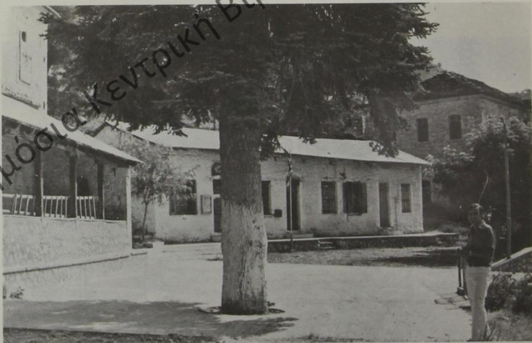
4. Ἀμάραντος. Ἀποψη τῆς κεντρικῆς πλατείας ἀπὸ τὸ ὕψος τῆς νότιας πλευρᾶς τῆς ἐκκλησίας. Στὸ χαμηλὸ στενόμετρο κτίριο συστεγάζονται ἕνα παντοπωλεῖο, τὸ κοινοτικό κατάστημα καὶ τὸ καφενεῖο (Π.Εβ.ὄμ.χαρτ.Κ3) .
