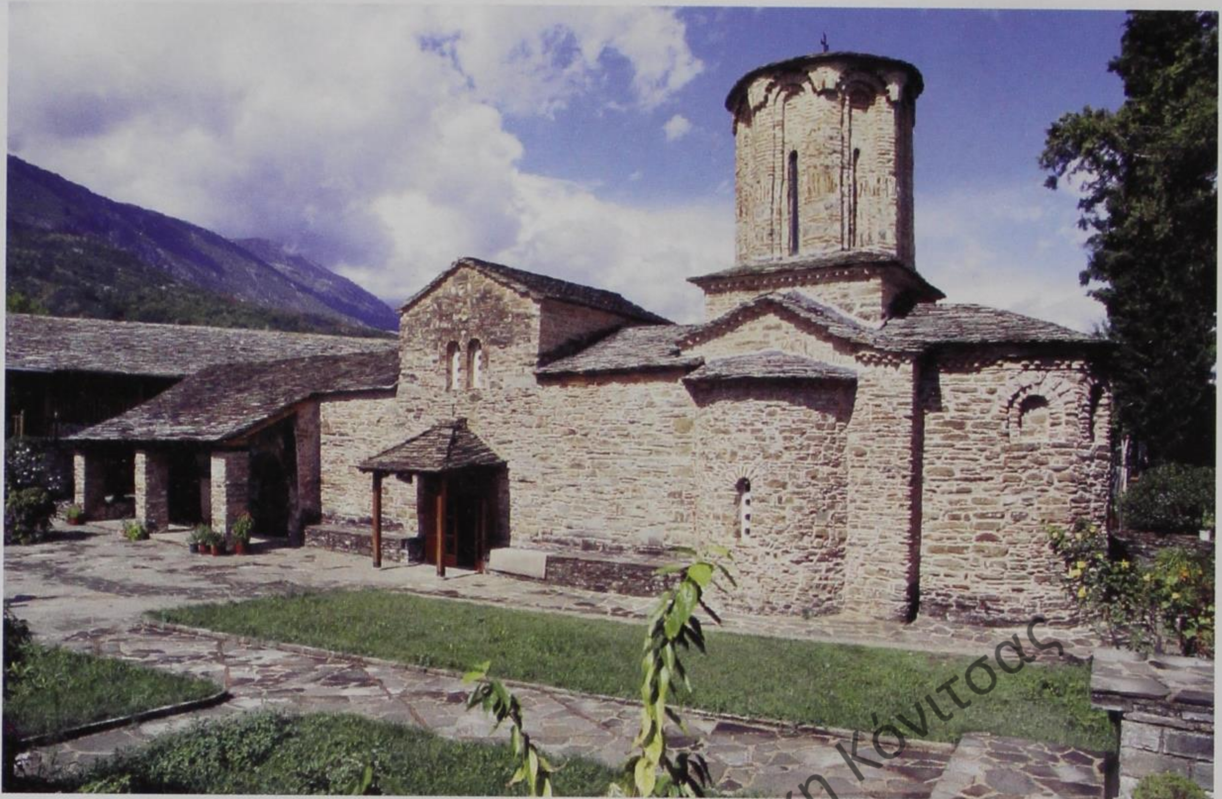
72. Μονή Κοίμησης Θεοτόκου Μολυβδοσκεπάστου. Άποψη του καθολικού από νοτιοανατολικά.
