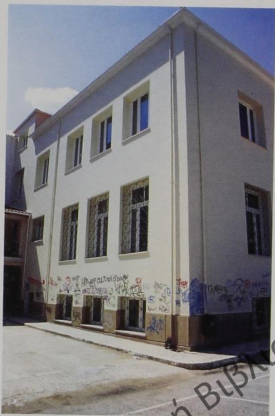
Το θαυμάσιο κτίριο της Ζωσιπαιάς Παιδαγωγικής Ακαδημίας, στην οδό Δωδώνης, μία μόλις ημέρα μετά την ολοκλήρωση των εργασιών συντήρησης και αποκατάστασης του, τον Οκτώβριο του 2003. Μια μερίδα της νεοελληνικής νεολαίας ζει ακόμα στην εποχή των Βησιγόθων...
