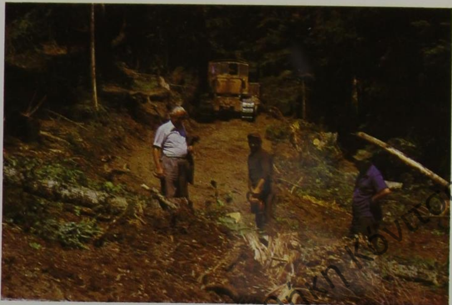
Διάνοιξη του δασικού δρόμου.
