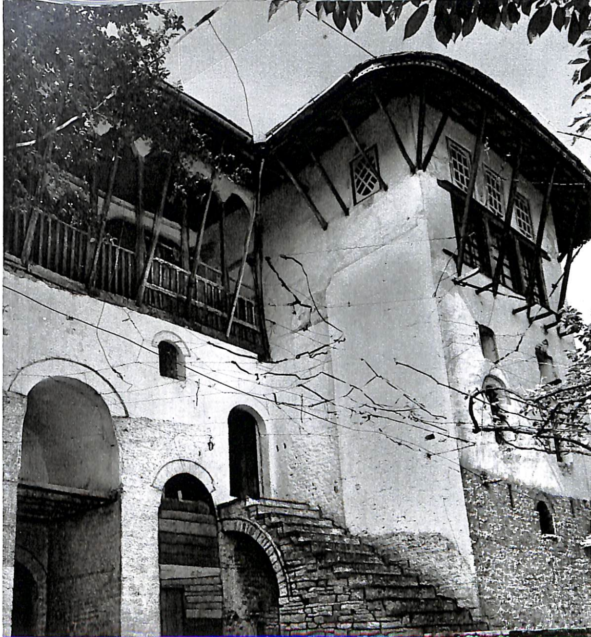
Banesë në lagjen Palorto, viti 1823. gjendja mbas restaurimit
