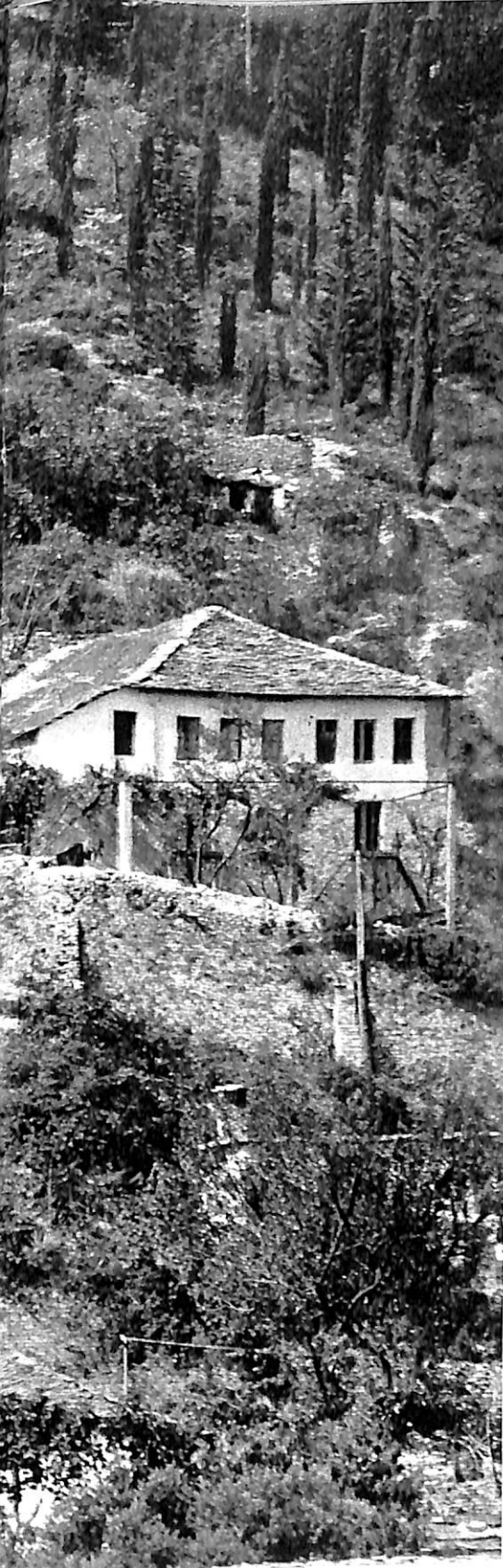
Banesë në lagjen Teqe (gjendja para restau- rimit).
