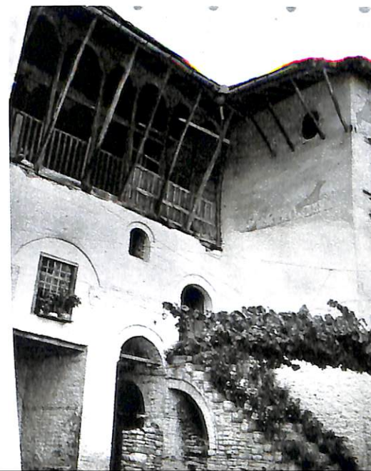
Banesë në lagjen Palorto, viti 1823. gjendja para restaurimit
