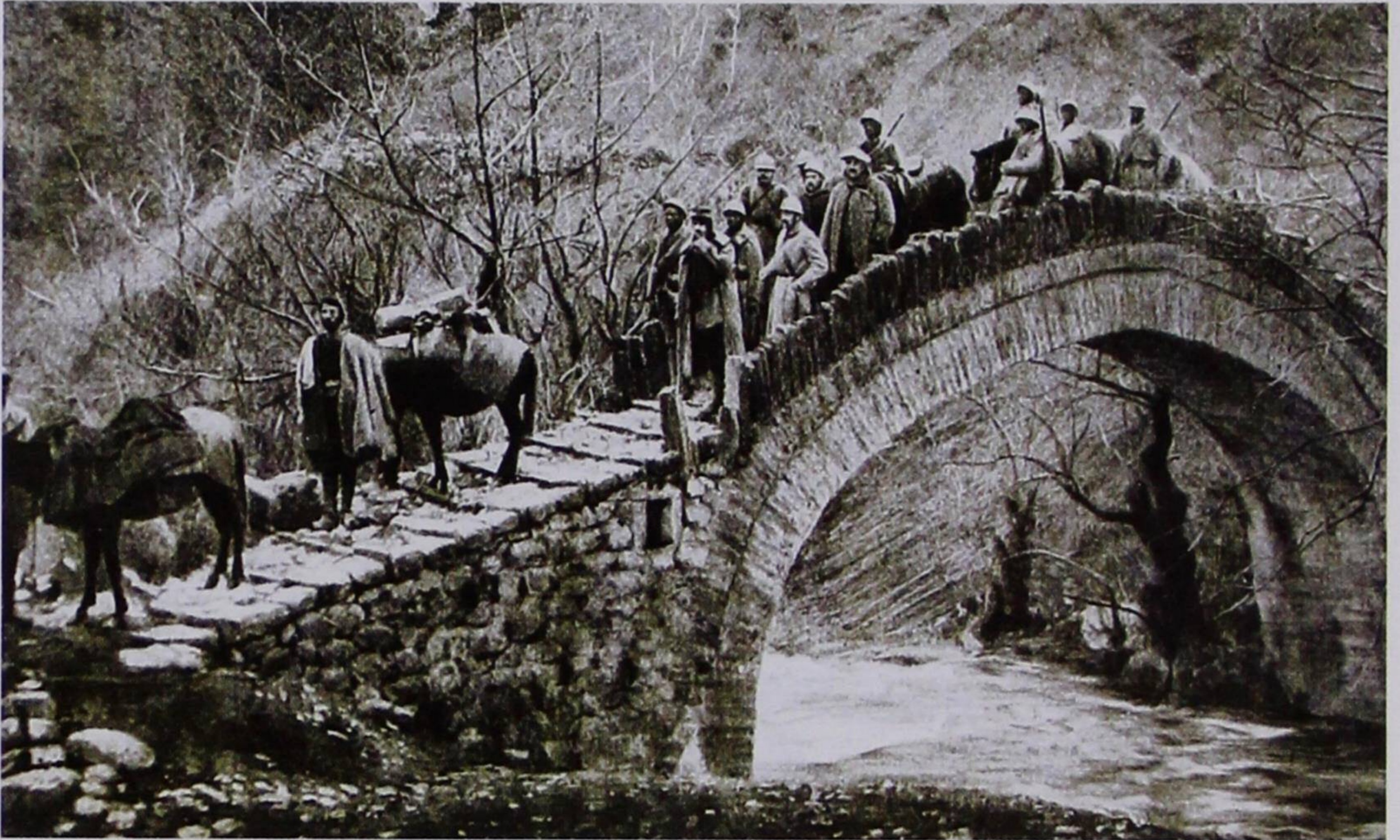
(Φωτ. 1-1): Η «γέφυρα Γιάτση» το 1917. Όψη ανάντης. Σενεγαλέζοι ακροβολιστές του γαλλικού στρατού διαβαίνουν τη γέφυρα. [ Πηγή: Γαλλική εφημερίδα L'illustration, 17-03-1917 ].
