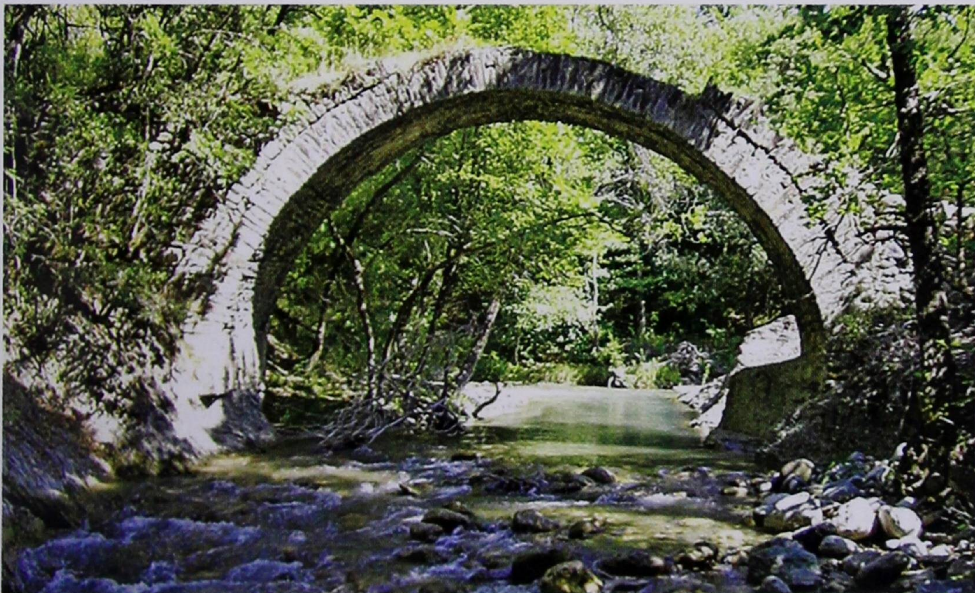
(Φωτ. 3-1): Κατάντης όψη της «γέφυρας Σμίξης». [ Πηγή: Παραχώρηση Σταύρου Κούκη, εξ Αμαράντου ].
