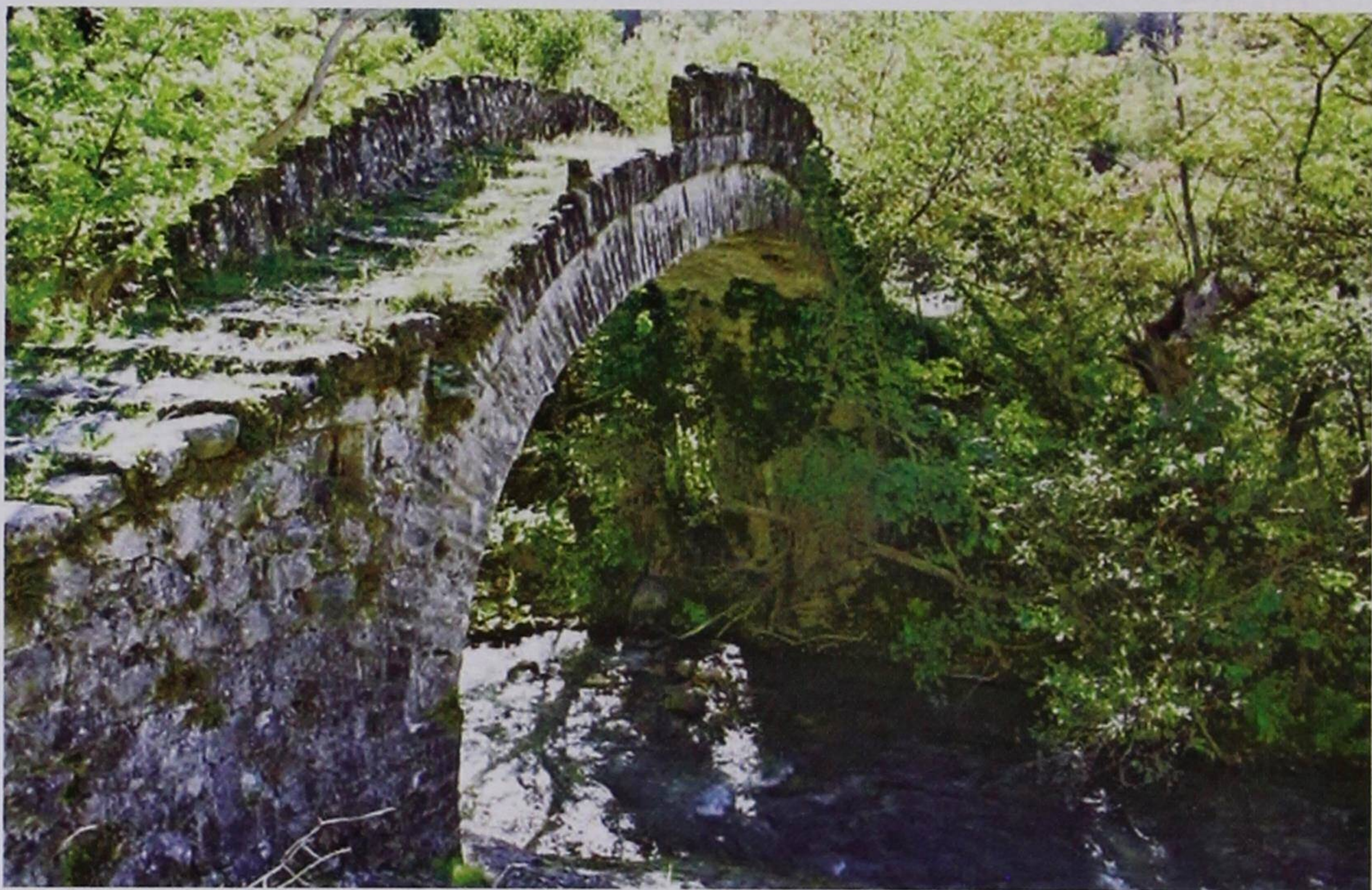
(Φωτ. 1-3): Ανάντης όψη της «γέφυρας Γιάτση» περί το 2010. [Πηγή: Παραχώρηση Σταύρου Κούκη, εξ Αμαράντου].
