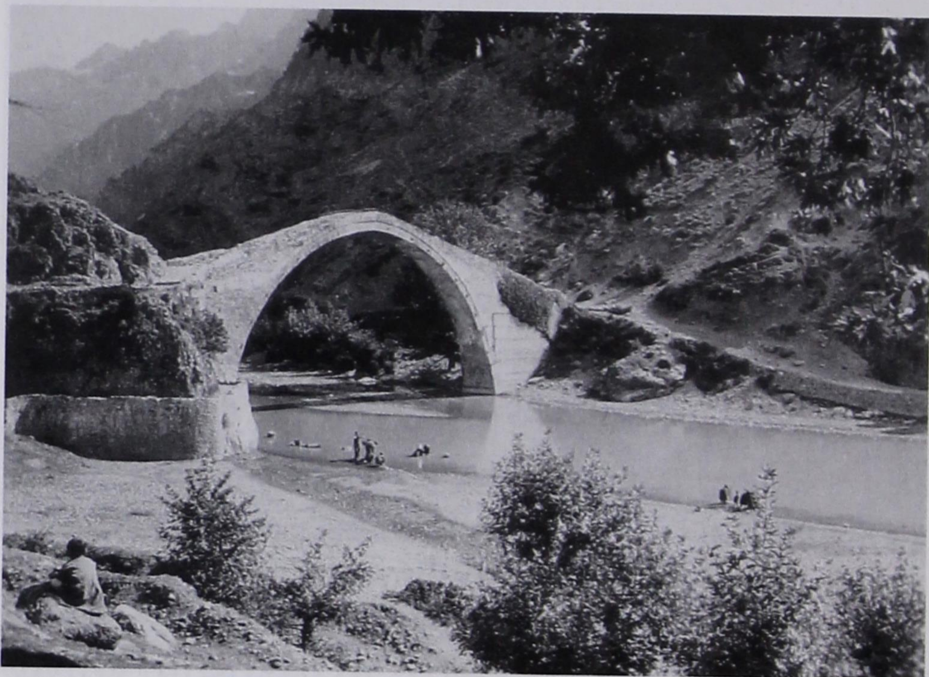
Το πετρόχτιστο μονότοξο γεφύρι της Κόνιτσας σε παλαιότερη φωτογραφία.
