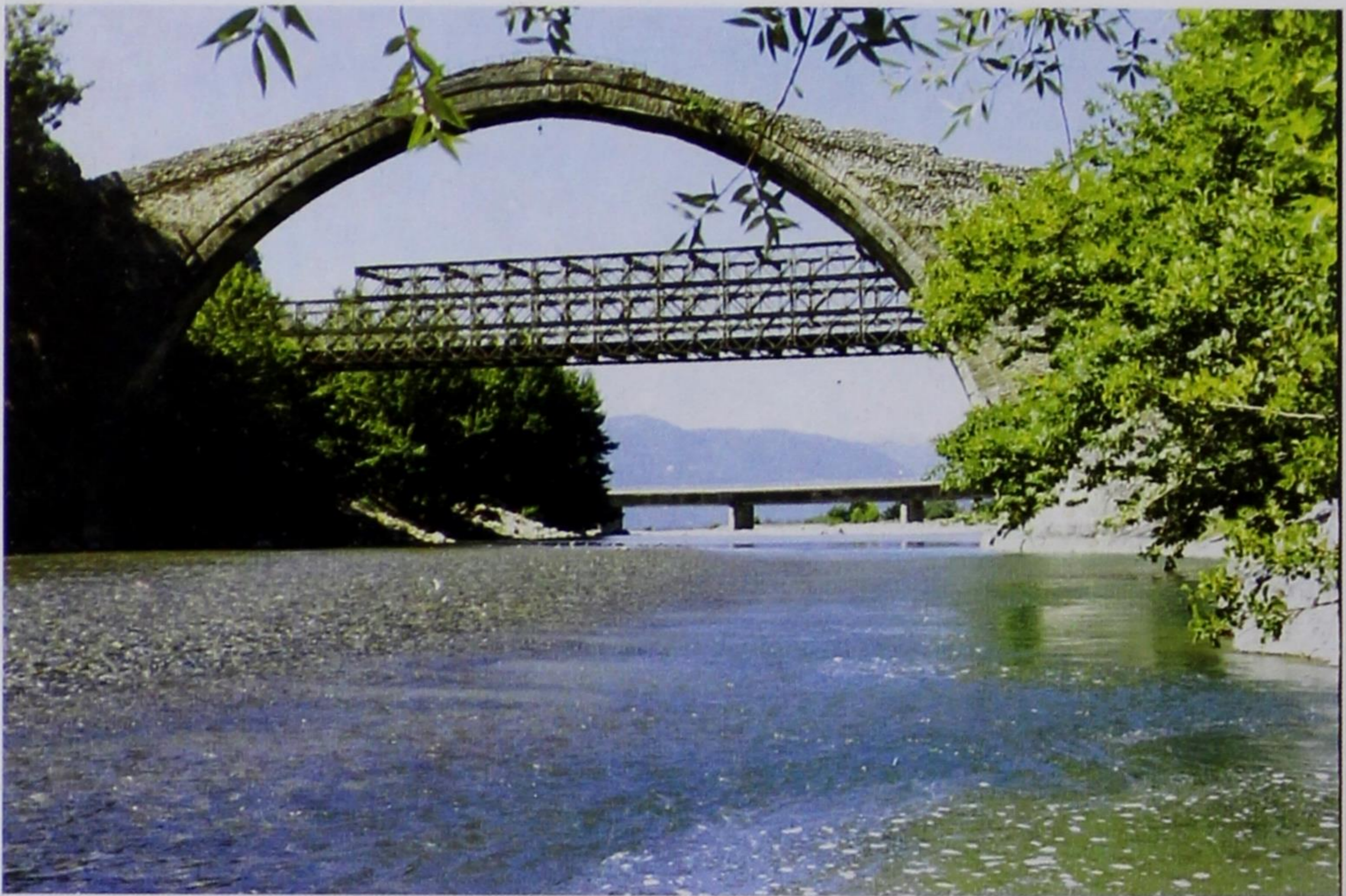
Εικ. 67. Αώος. Γεφύρι της Κόνιτσας. Όψη από τα ανάντη. Διακρίνονται οι «άρπιζες» στο κάτω τόξο (και ακόμα η γέφυρα Μπέλεϊ» (Bailey), που αποσύρθηκε την 1 Ιουλίου 2000 (: πληροφορία Γιάννη Τσαρούχη, Κόνιτσα, 07.11.2000) και η νεώτερη της Εθνικής οδού Ιωαννίνων-Κοζάνης). (Φωτογραφία μετά το 1980 περίπου, Ιω. Καπάϊου, Κόνιτσα).
