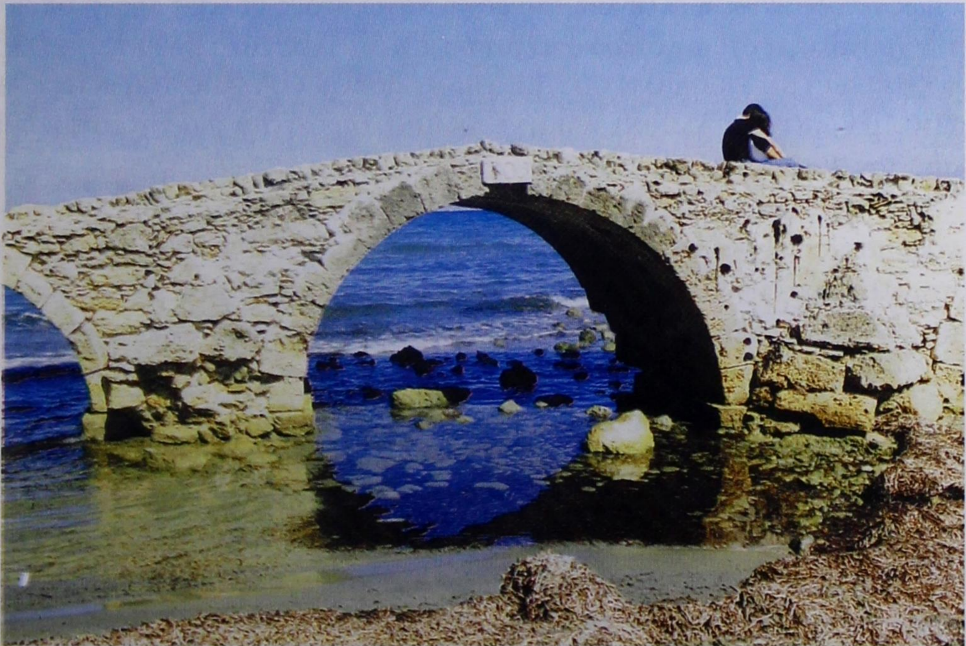
Εικ. 24. Ζάκυνθος, θέση «Αργάσι». Η τρίτοξη νυν «θαλασσογέφυρα», έργο του 1805 της «Επτανήσου [πρώτης ελληνικής] Πολιτείας» – Πάνω: το σύνολο της τρίτοξης γέφυρας. (Φωτ.: προ του 1975, Διονυσίου Α. Ζήβα, αρχιτέκτονα καθηγητή, Αθήνα). – Κάτω: το κεντρικό τόξο με την επιγραφή «1805». (Φωτ.: περίπου 1995, Νικ. Βασιλικού, Αρχείο Ιωάνν. Ν. Κούτση, αρχιτέκτονα, Αθήνα).
