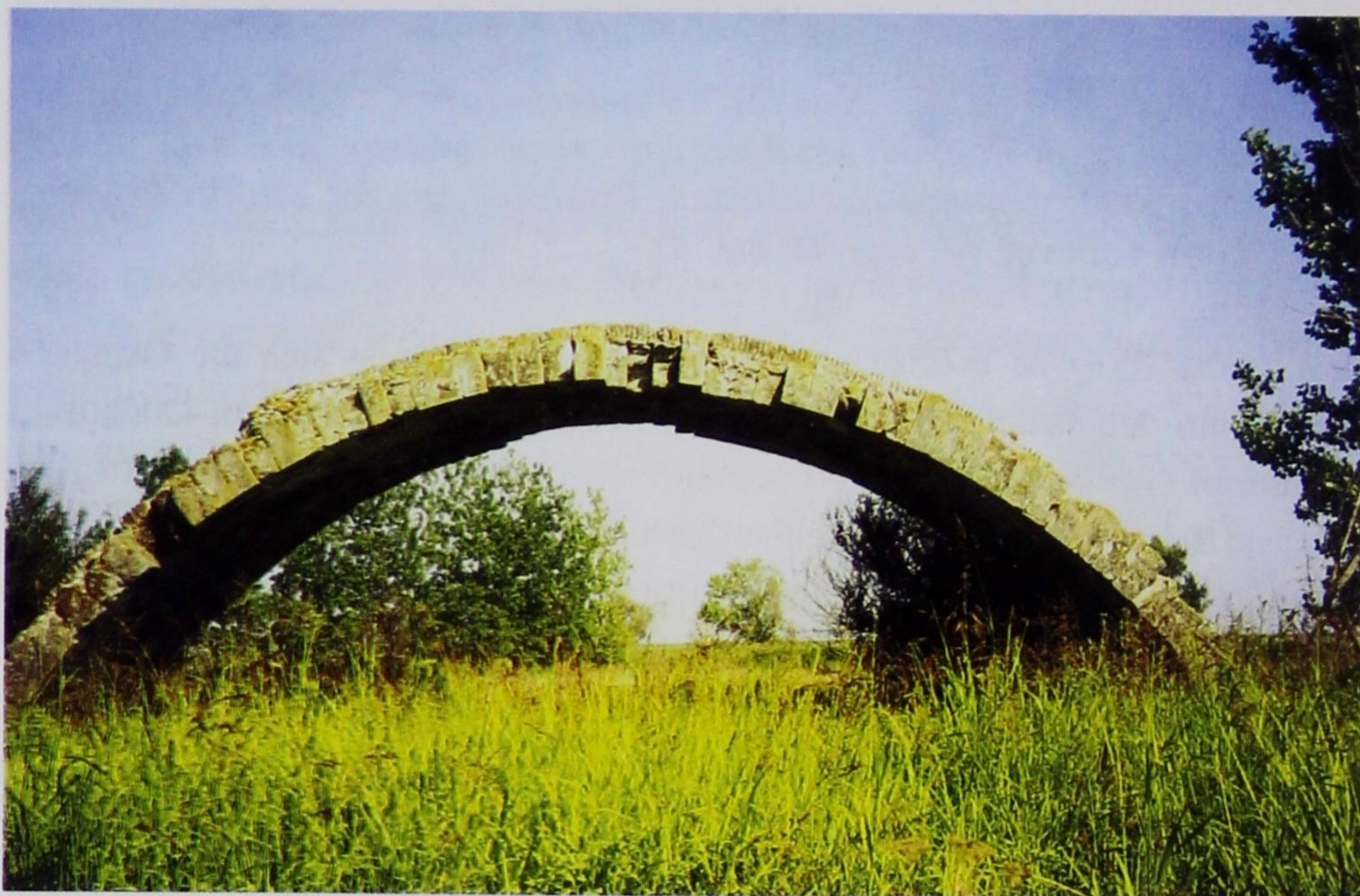
Εικ. 21. «Κλειδί» (κοντά στη Θεσσαλονίκη και στο ομώνυμο χωριό): το εναπομένον καλολαξευμένο λίθινο τόξο πολύτοξης ρωμαϊκής γέφυρας, έργο περί το 300 μ.Χ. επί του Λουδία, ο οποίος τώρα έχει αλλάξει κοίτη. Όψη από τα ανάντη (= βορειοδυτικά). (Φωτ. 2 Ιουλ. 2000. Φωτοθήκη Α.Π.: Φ.00.VI/1, αρ. 34).
