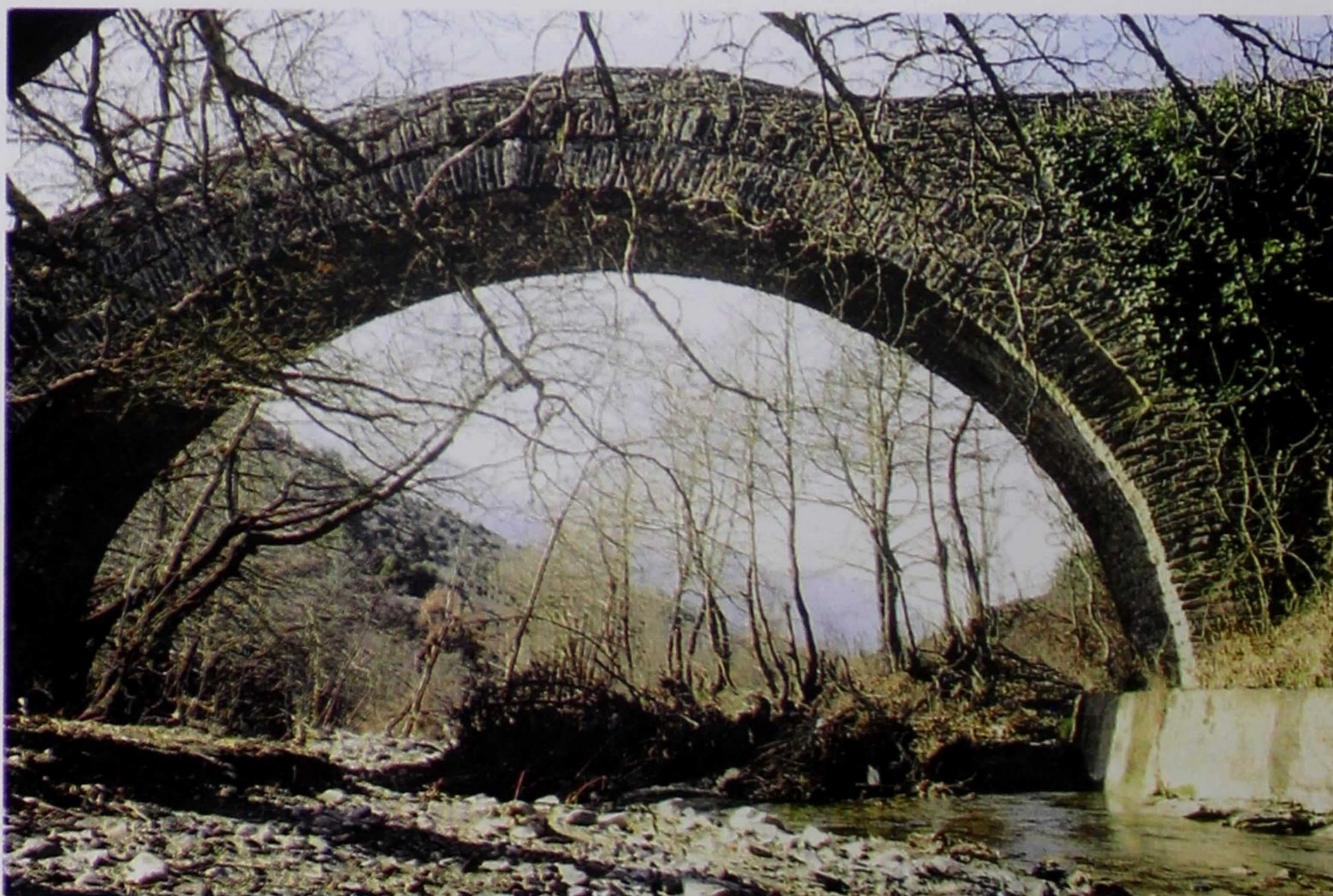
Εικ. 72Β. «Της Τοπόλ'τσας το Γεφύρι»: ομόλογη της Εικ. 72Α. Ώρα που ο ήλιος γέρνει. Διακρίνεται δεξιά η φωτισμένη αρχή α) της καμάρας/διαφορετικής καμπυλότητας και β) και πάνω απ' αυτή του δεύτερου τόξου (Φωτ. 2000 Φανής Σαρρή / Phaos Photos).
