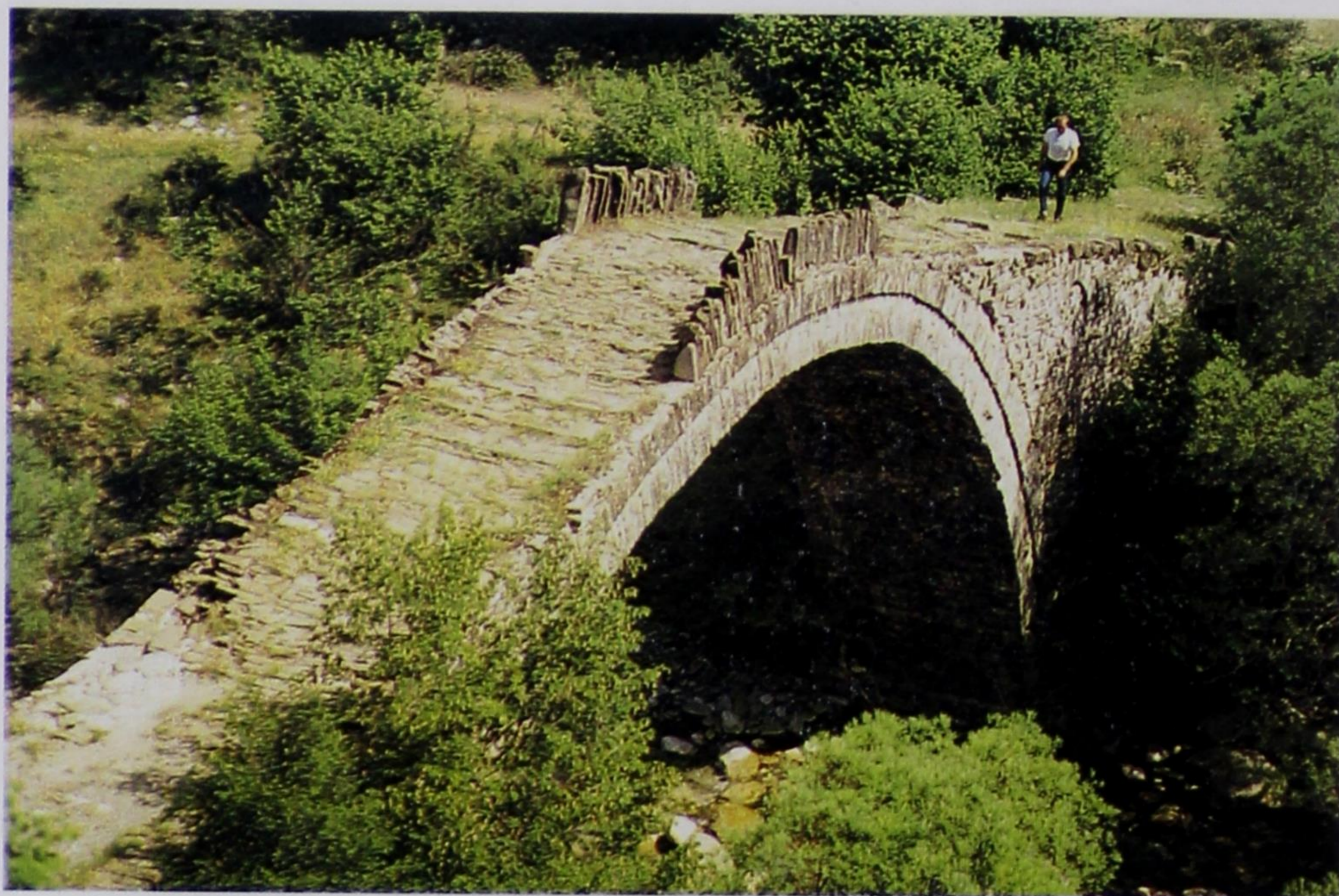
Εικ. 81. Το Γεφύρι του Χάτσιου στο Βικάκι, κάτω από το Τσεπέλοβο στο Ζαγόρι. 1804. (Χορηγός Λάμπρος Χάτσιος). Οι «αρκάδες» συμπυκνώνονται και δημιουργούν στηθαίο στη ράχη μόνο της καμάρας (φωτ. Σπ. Ι. Μαντάς, Ηπειρωτικά Γεφύρια , 1984, σ. 99, εικ. 54).
