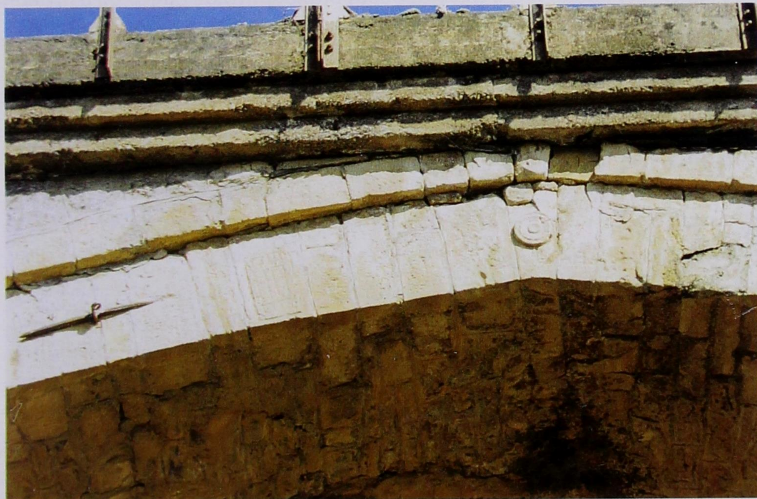
Εικ. 78Α. «Γεφύρι του Πασιά» στον Ενιπέα Φαρσάλων. Όψη από ανάντη πρώτου τόξου από αριστερή όχθη. Στο «κλειδί» διακοσμητικός ομφαλός, αριστερά «άρπεζα», δεξιά της στον δ' λίθο ορθογώνιο γεωμετρικό γραμμικό σχέδιο (Φωτ. 07.08.2000, Α.Π.: Φ.00.VII/τ. αριθ. 35Α).
