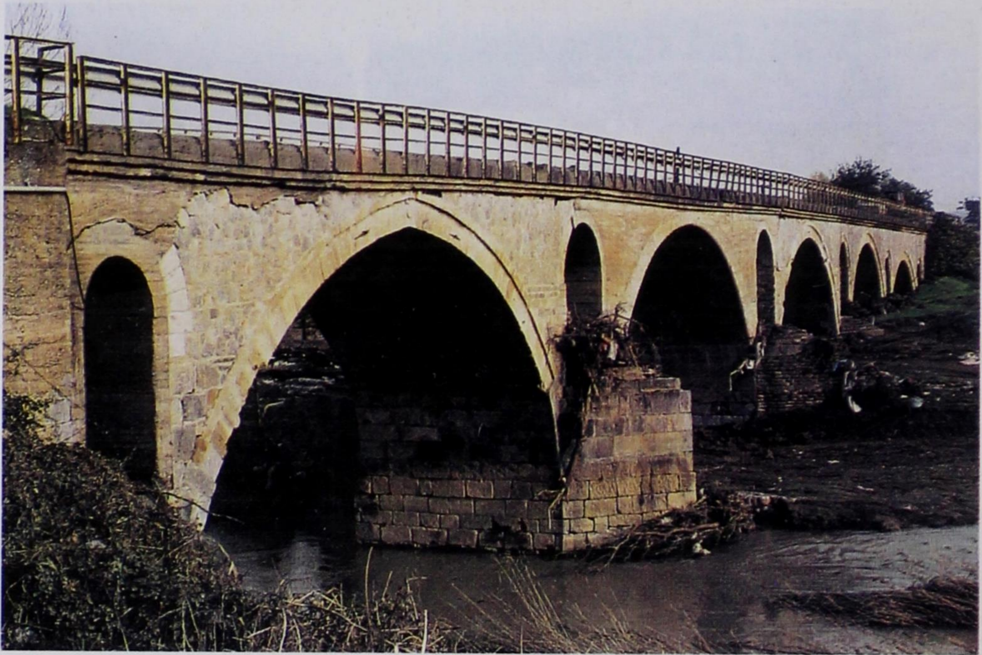
Εικ. 78. «Γεφύρι του Πασιά» στον Ενιπέα Φαρσάλων. Αρχικό κτίσιμο 1752. Όψη από ανάντη: διακρίνονται οι «άρπεζες» στο πρώτο τόξο επί της βαθείας κοίτης, επίσης στο τρίτο (: φωτ. Αντ. Γαλερίδης κ.Α., 1995, σ. 108 εικ. 85).
