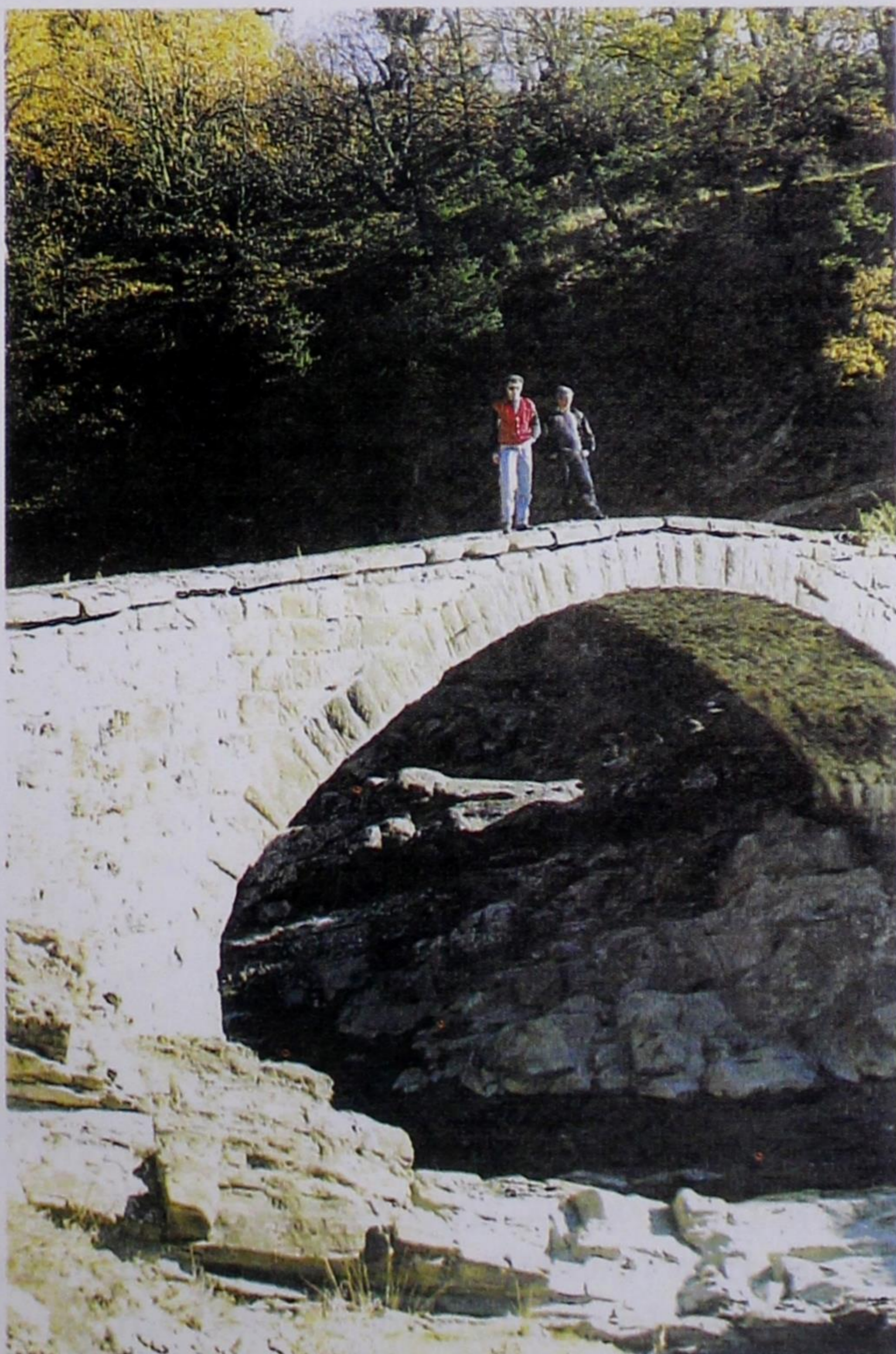
Εικ. 70. Γεφύρι «στο Νιδρούζι» (περιοχής Γρεβενών) με 2 «άρπιζες» (βλ. §77). (: φωτ. Γ. Τσότσος, 1997, σ. 50 εικ. 20 αριστερά).
