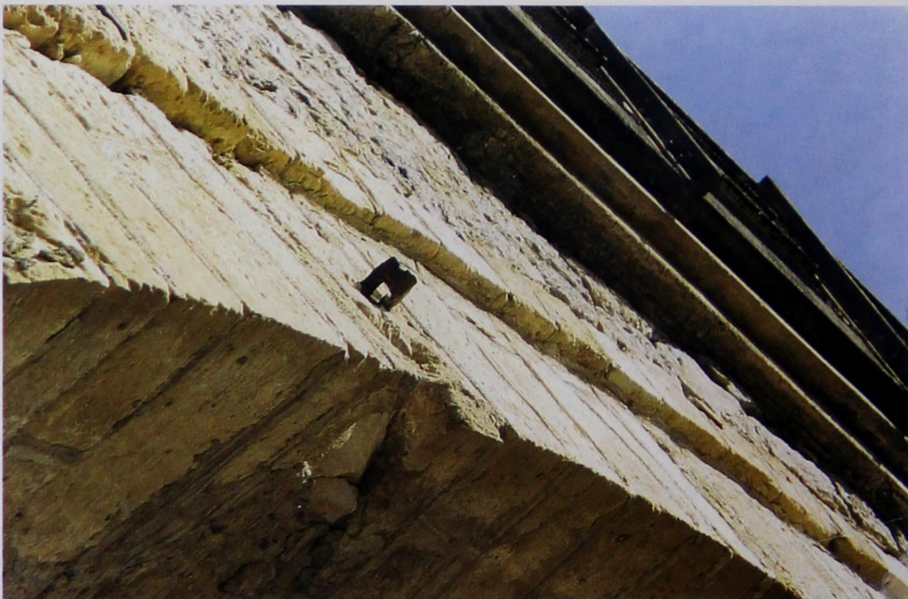
Εικ. 59. «Γεφύρι του Πασιά» στον Ενιπέα Φαρσάλων. 4ο τόξο από αριστερή όχθη. Όψη από ανάντη (= ανατολική). Διακρίνεται η άκρη διαμπερή ελκυστήρα στην τρύπα της οποίας πέρασε η κάθετη αγκύρωση, η κατ' εξοχήν «άρπεζα» (: Φωτ. 07 Αυγ. 2000, Α.Π.: Φ.00. VII/τ. αριθ. Ε).
