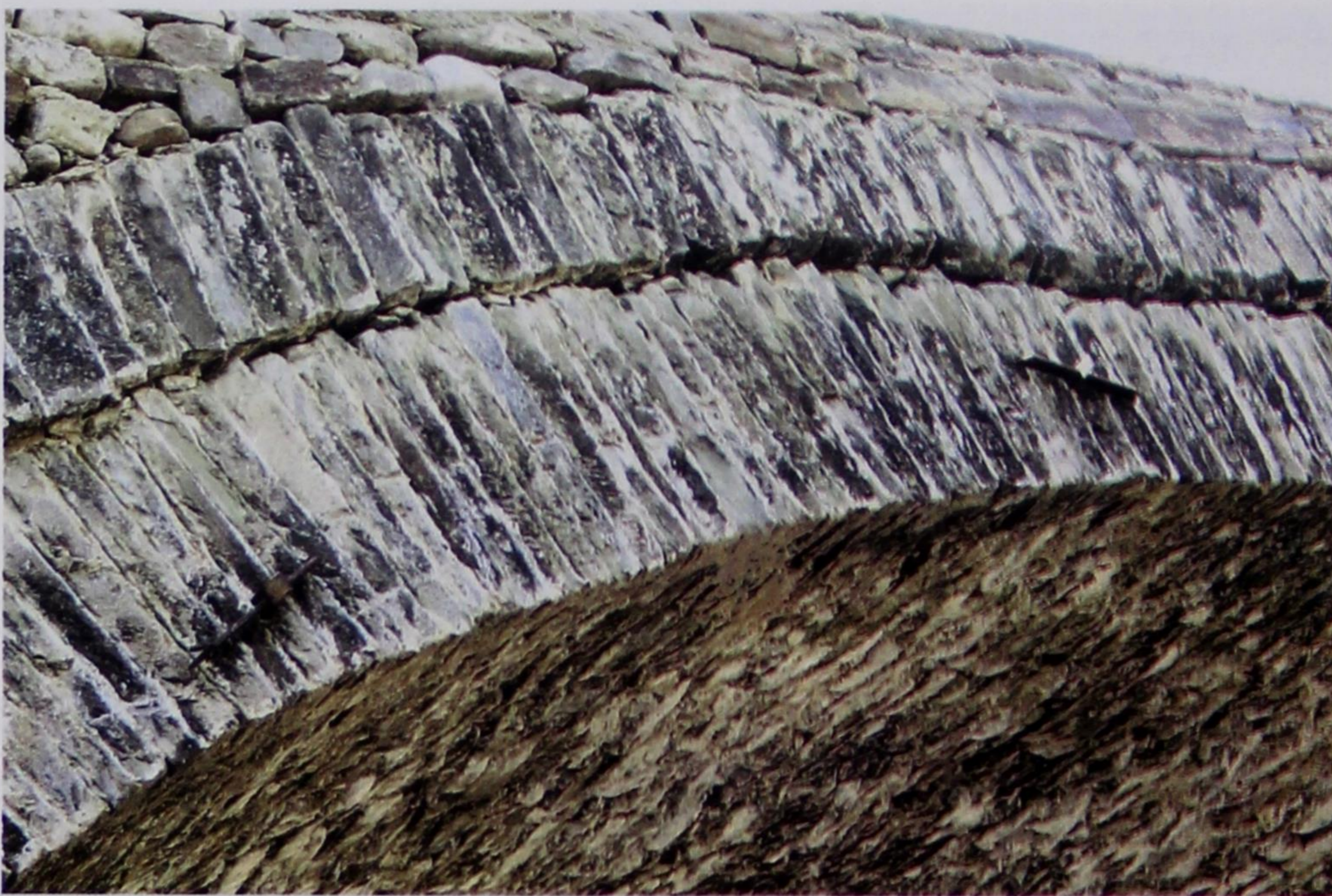
Εικ. 73Α. «Της Τοπόλ'τσας το Γεφύρι» (βλ. εικ. 72Α και Β). Λεπτομέρεια της καμάρας του με το πάνω τόξο («στεφάνι») και προεξοχές, και με το κάτω κύριο τόξο να δένεται από τις «άρπιζες» (Φωτ. 2000, Φανής Σαρορή / Phaos Photos).
