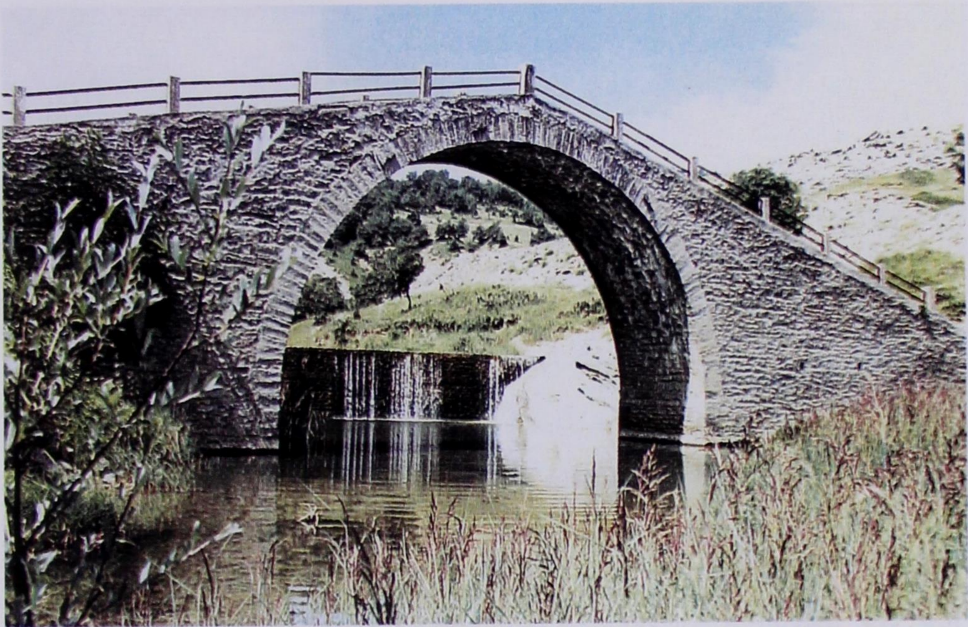
Εικ. 75. Γεφύρι Μάερης Βοΐου, 1910. Φαίνονται καθαρά οι 3 άρπιζες και μόλις διακρίνεται η 4η δεξιά του κλειδιού, το άγκιστρο της οποίας έλειψε στα 1987-1988. (Φωτ. 1988: Γ. Τσότσος, 1997, σ. 90 εικ. 55. – Σημ. στην εικ. 54 του ίδιου του 1987 υπάρχουν και οι 4 άρπιζες, και καθαρότερα φαίνονται στο Σπ. Ι. Μαντά, 1984, σελ. 151).
