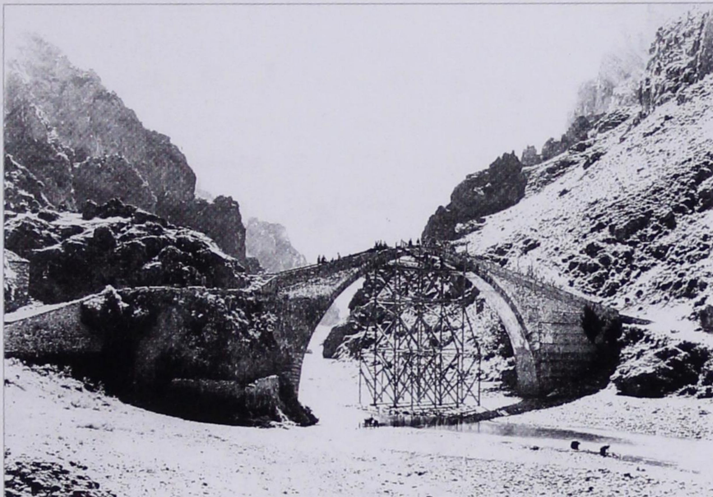
Εικ. 32. Γεφύρι Κόνιτσας στον Αώο. Έργο 1869-1870 Πυρσογιαννίτη πρωτομάστορα Ζιώγα Φρόντζου (π. 1815 - π. 1893). Εδώ επισκευάζεται μετά τον βομβαρδισμό του το 1913 από τον υποχωρούντα τούρκο Τζιαβίτ Πασά [προφανώς το ίδιο καλοκαίρι]. Τα στηρίγματα του καλουπιού πατήσανε στην κοίτη (Φωτ. Σπ. Μαντά, που αποδίδει στον Fr. Boissonpas).
