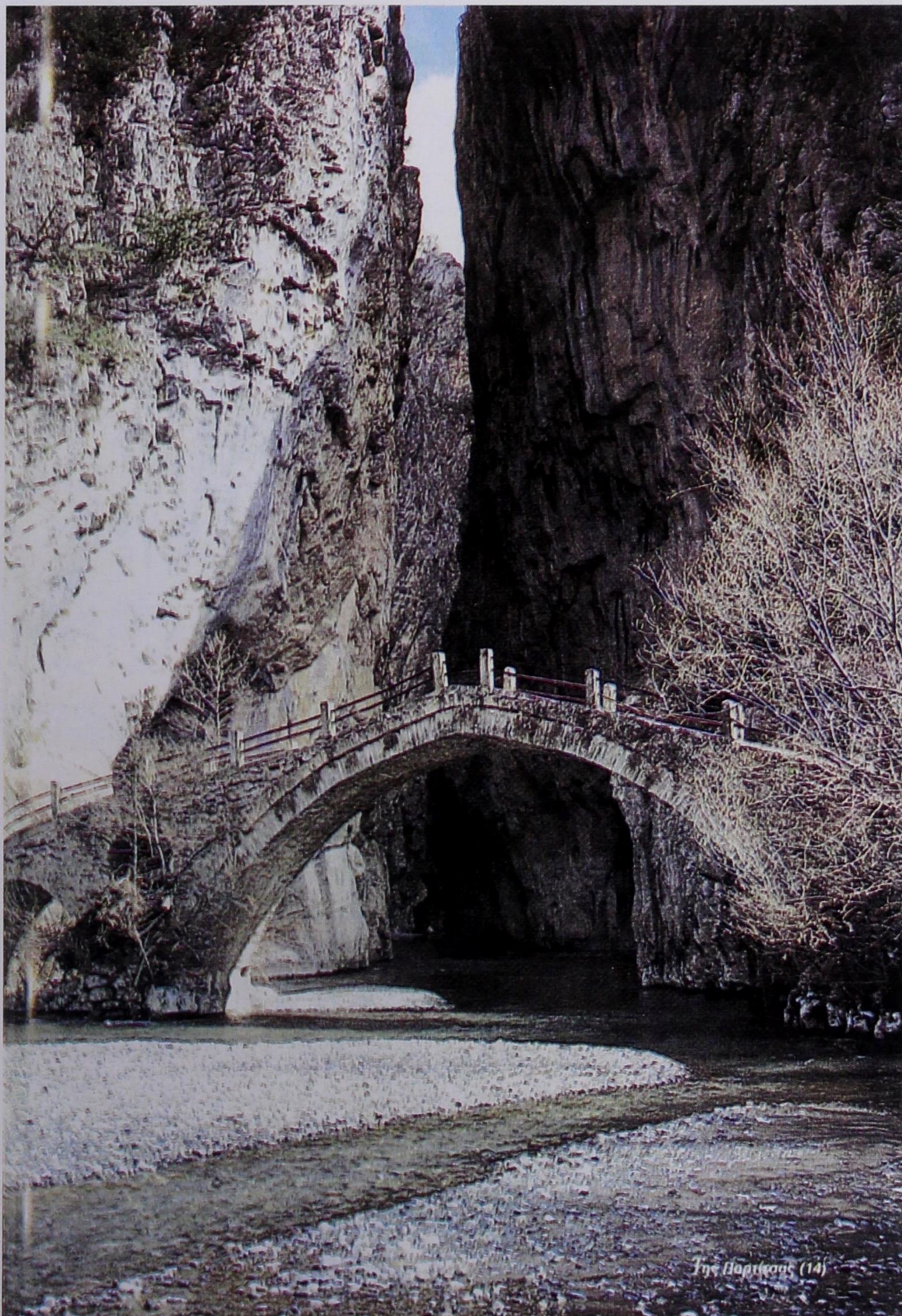
Εικ. 37. Δίτοξο (με ανακουφιστικό τόξο) γεφύρι «στις Πορτίτσες», θέση «Καρούτες», φαράγγι του Σπηλαιίου Γρεβενών (φωτ. Άγγελου Σινάνη στο ένθετο «Ταξίδια στην άλλη Ελλάδα» τόμ. Β' (σ. 63 εικ. 14) του περιοδ. «Ο-300» τεύχος 33 (Ιουλ. 2000).
