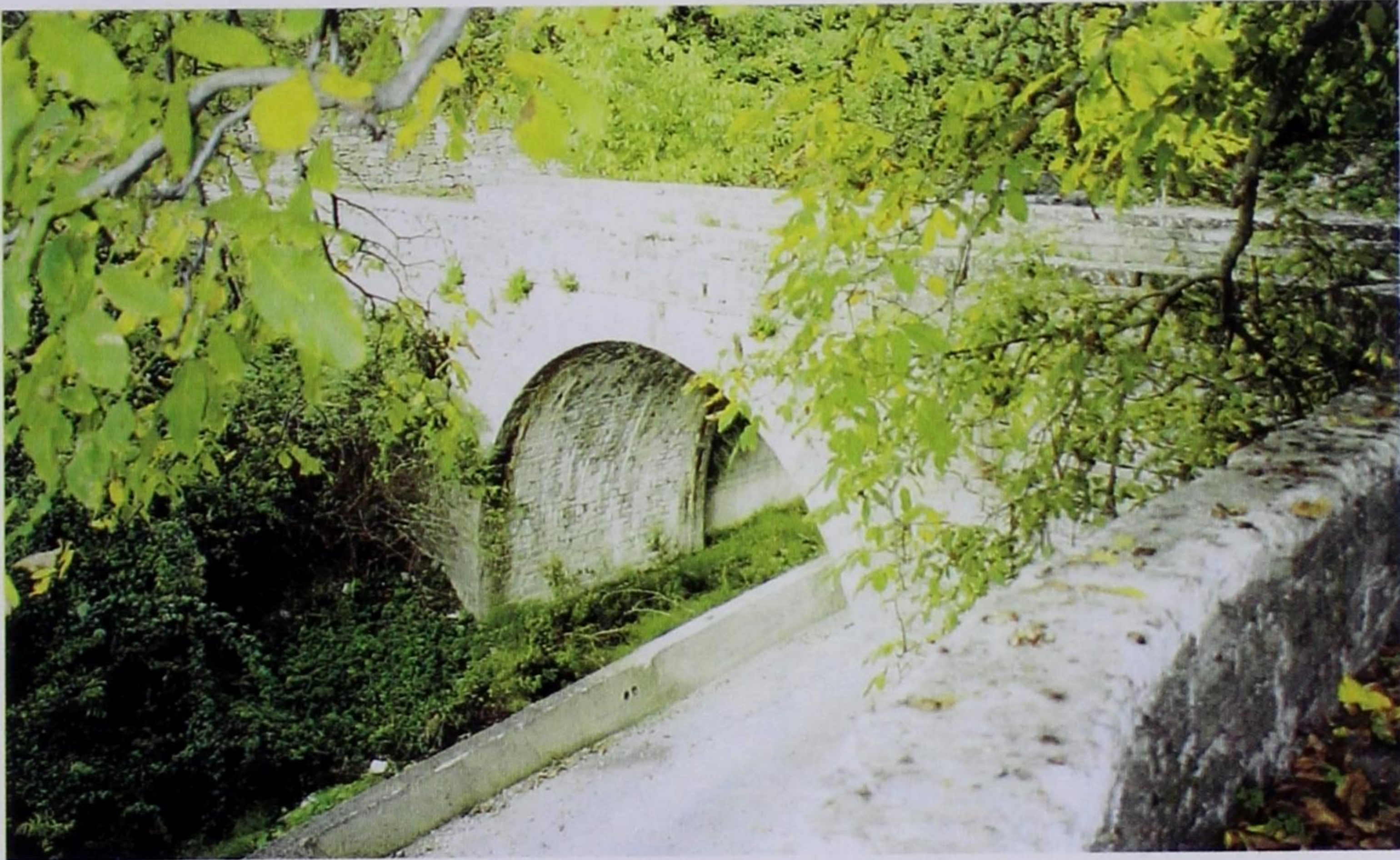
Εικ. 89ΣΤ «Της Γκάλινας το γεφύρι» στην Καστάνιανη (σημ. Καστανέα), 1934. Όψη απο κατάντη (φωτ. Α.Π., σούρουπο Κυριακής 29 Οκτ. 2000)
