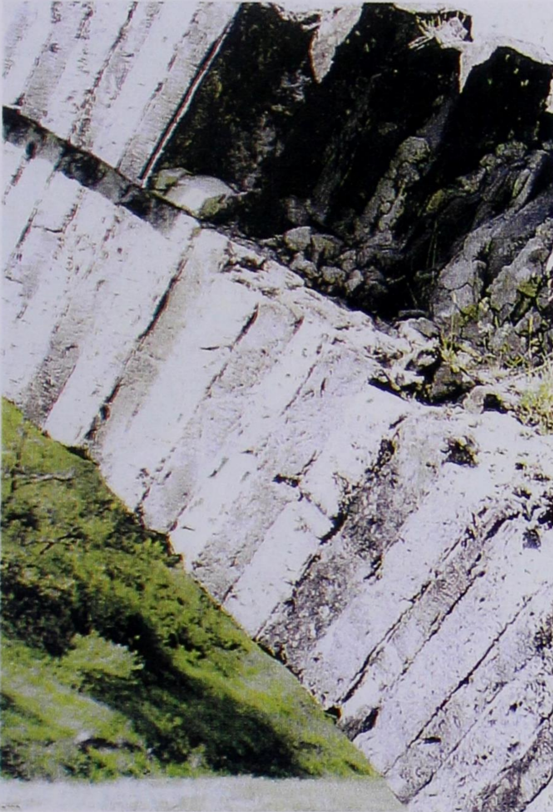
Εικ. 58. «Γεφύρι της Κυράς» ή της «Μπαλντούμας» στον Άραχθο, 1762. Λεπτομέρεια. Κάτω τόξο («στεφάνι») και δεύτερο υπερκείμενο διαμπερούς διάταξης (Φωτ. Α.Π. 10.5.1995: Β. Παπαγεωργίου / Α. Πετρονώτης, σ. 304 εικ. 17).
