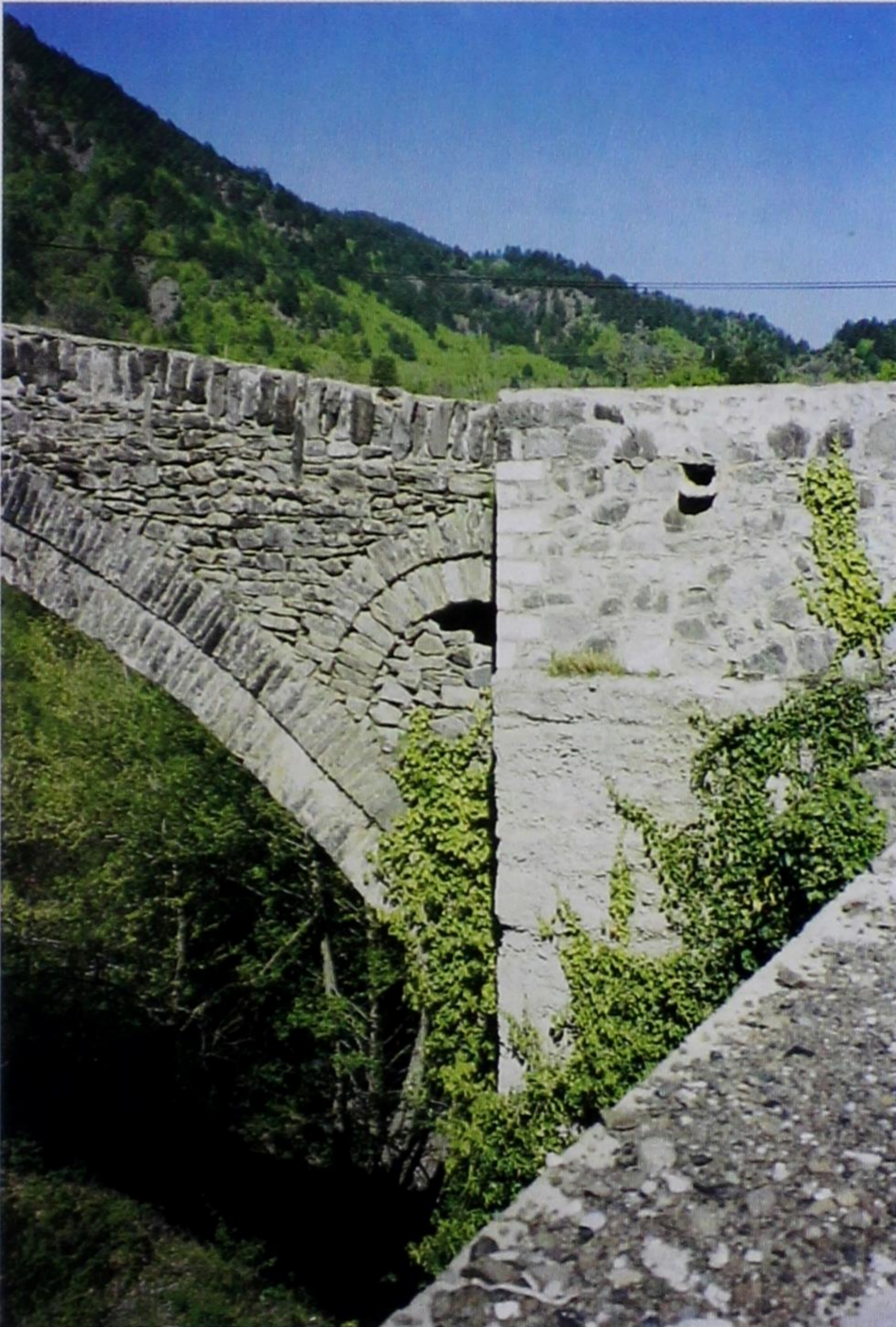
Εικ. 56. Γέφυρα «Μαυρόπετρας» χωριού Πουρνιά (πριν Σταρίτσανη) Κόνιτσας. Τα τεταρτοκυκλικά ανακουφιστικά τόξα είναι πολύ σπάνια (πρβλ. «γεφύρι Κυράς» Μπαλντούμας Ηπείρου, εικ. 22). Αλλά εδώ προέκυψε από την κάλυψη παλαιότερου ημικυκλικού μετά την διεύρυνση του γειτονικού του ακρόβαθρου (: φωτ. 10.5.1995, Α.Π.).
