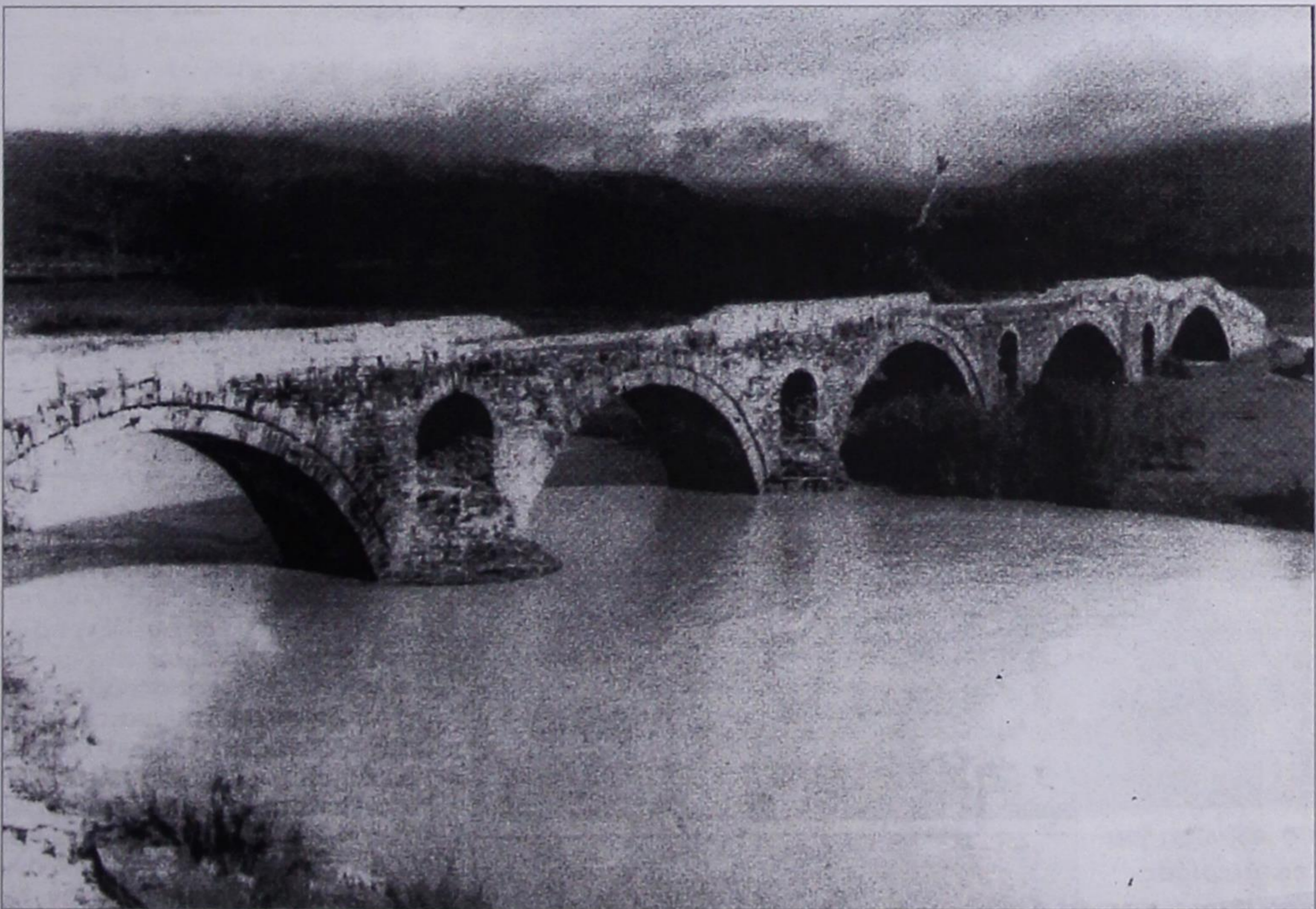
Εικ. 62Γ. Γέφυρα Κολορτζής επί του Δρύνου στη Δρόμπολη, 1827. (Φωτογρ. Οκτωβρίου 1997, Σπ. Ι. Μαντά / Θ. Ν. Χαμάκου, βλ. σημ. 126η).
