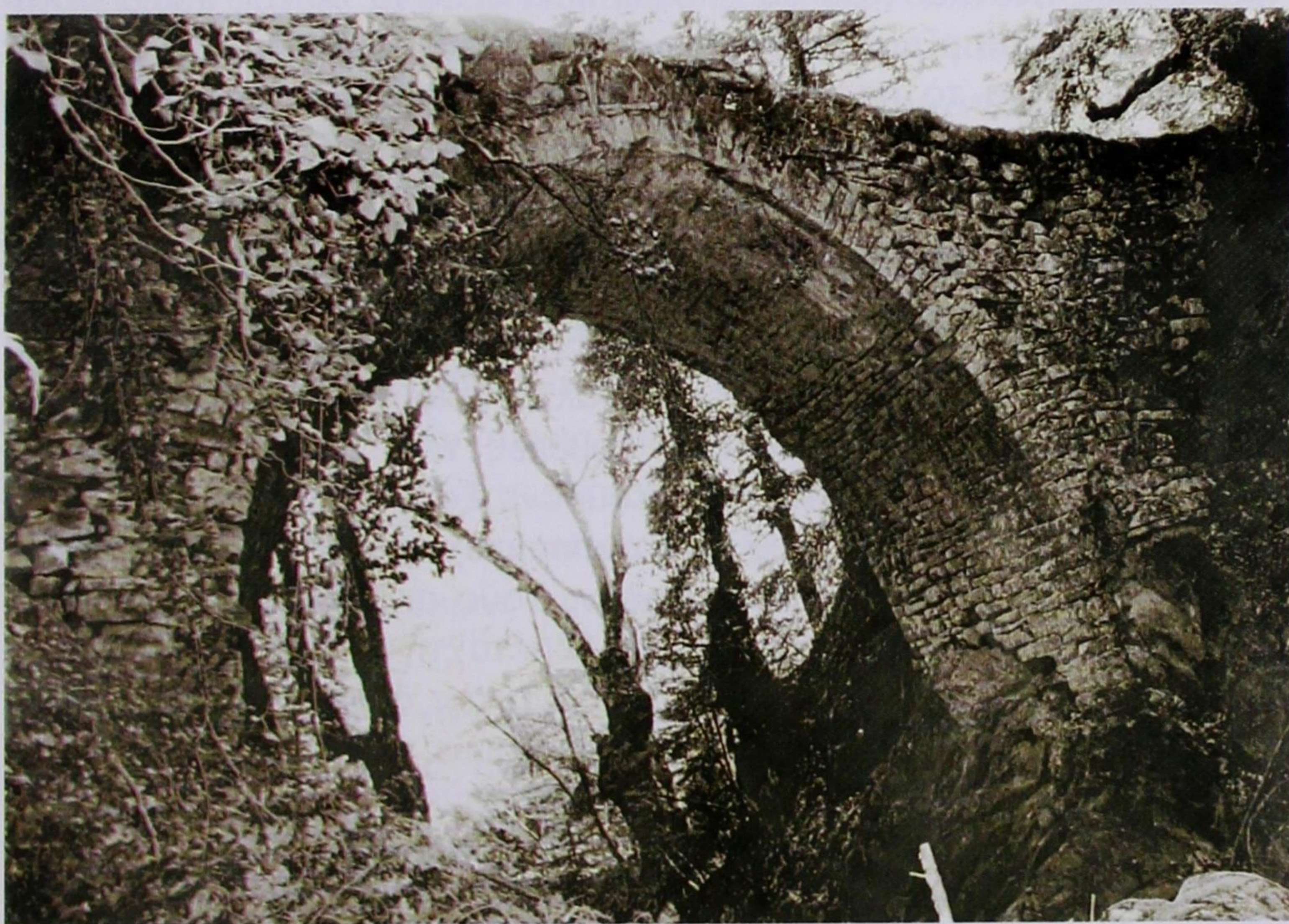
Εικ. 94. Γέφυρα «Καμάρα» στο ρέμα Μουτζουράκι, όπου το παλαιό επώνυμο χωριό, κοντά στον οικισμό Τυμφρηστού (στην Πέρα Κάψη) Φθιώτιδας. (Φωτ. Περικλή Φύκα, Λαμία/Λειανοκλάδι).
