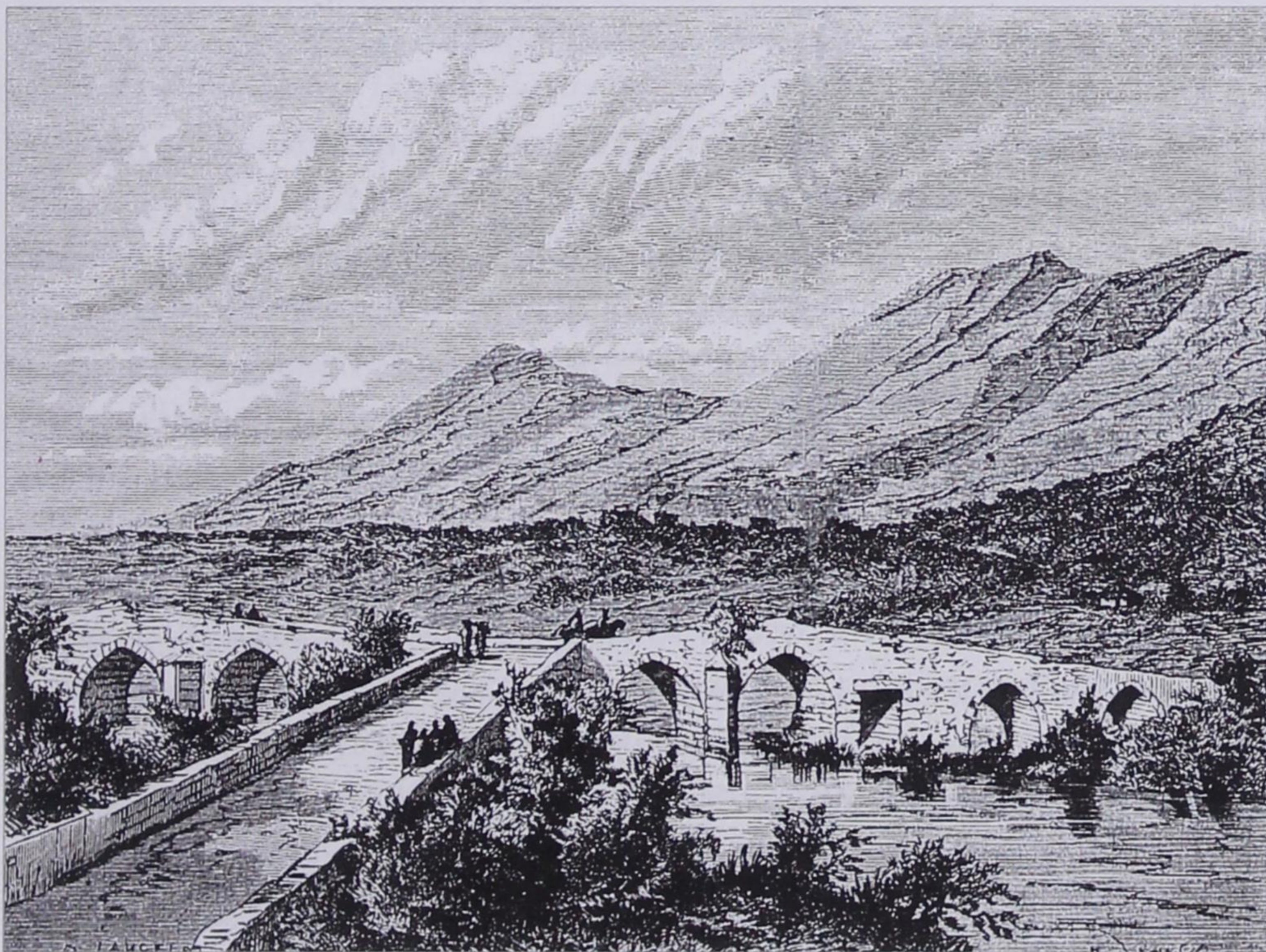
Εικ. 15Α. Η τριπλή σε κάτοψη γέφυρα της Μαυροζούμενας στη Μεσσηνία: Αρχική αρχαία κατασκευή (μεταξύ 4ου και 2ου αι. π.Χ.), με βυζαντινές και οθωμανικές προσθήκες, σε χρήση έως σήμερα (πηγή: εφ. «Έσπερος» Λειψίας, έτ. Β', αρ. 42, της 15/27 Ιαν. 1883, σελ.1. Από το αρχείο Αντώνη Γαλερίδη, Λάρισα)
