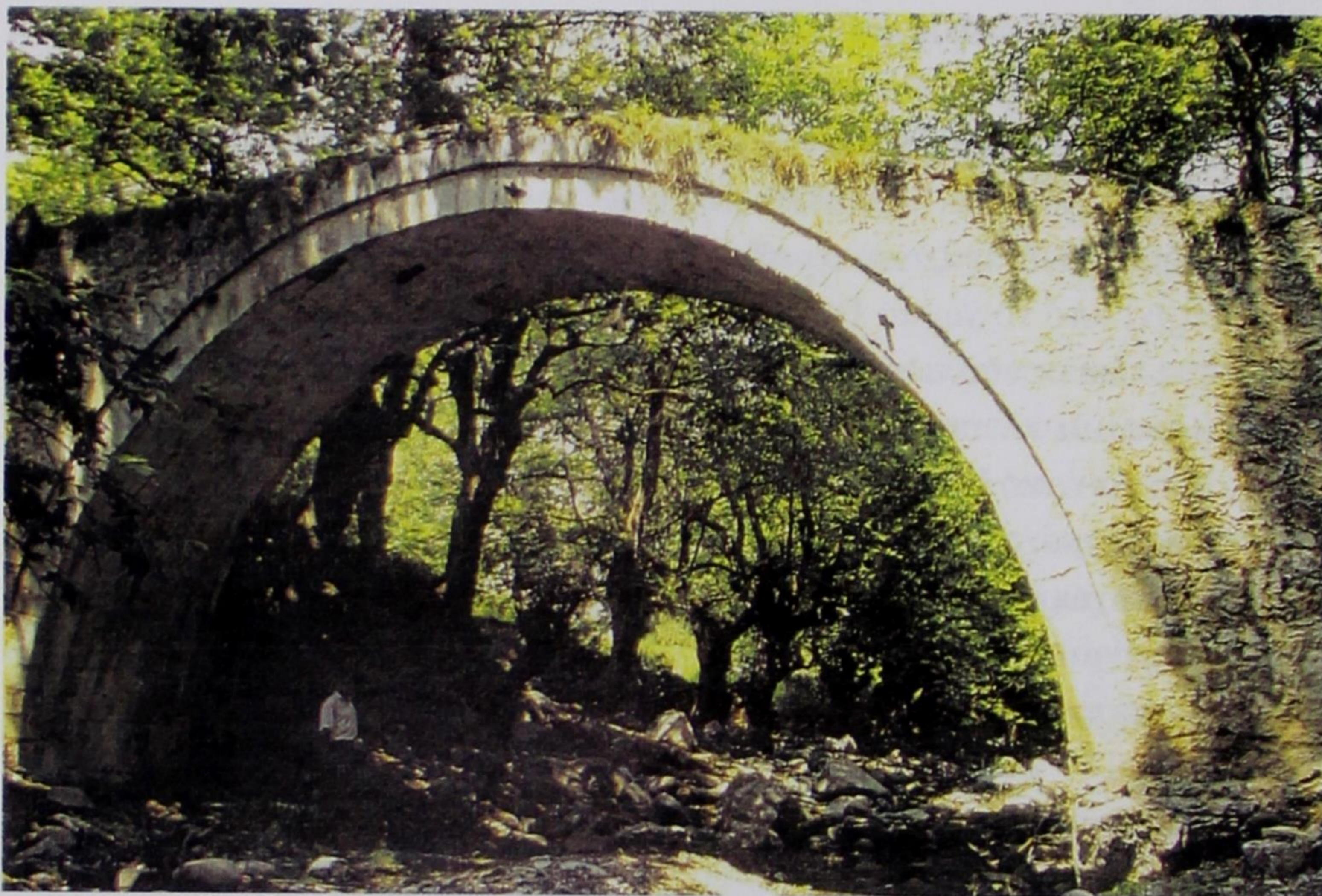
Εικ. 71. Γεφύρι στο χωριό Λάκκος Σερρών [Κτίσμα του β' μισού του 19ου αι.] από τα πιο καλοκτισμένα Ανατολικής Μακεδονίας με 3 «άρπιζες».
