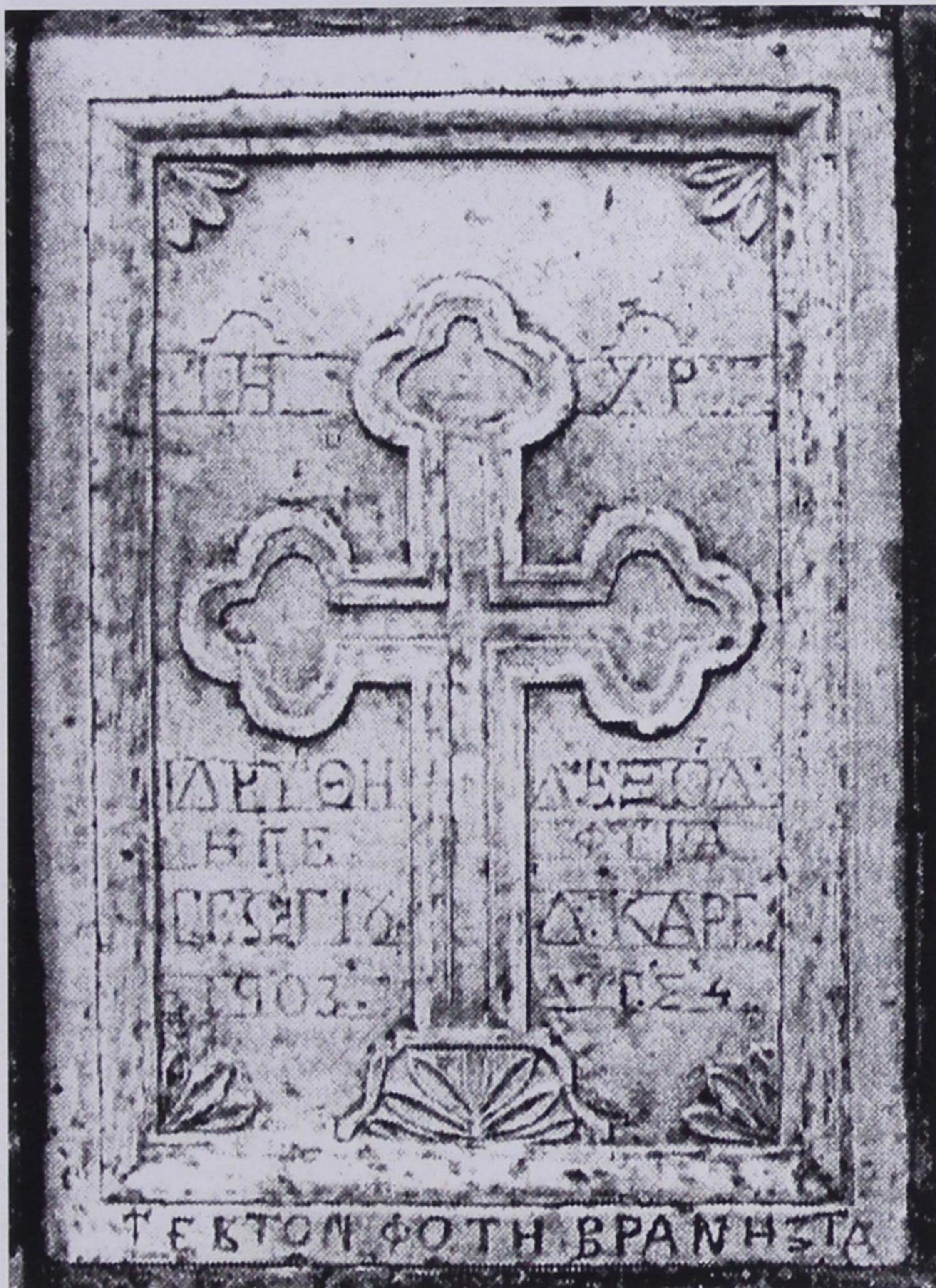
Εικ. 73Γ. Πηγή (πρ. Πεκλάρι) Κόνιτσας. Γεφύρι Άϊ-Νικόλα. Έργο πρωτομάστορα Μήτρου Γκόρτσου από Πυρσόγιαννη. Οικοδομική επιγραφή 1903, «ΤΕΚΤΟΝ ΦΟΤΗ[Σ] [ΑΠΟ] ΒΡΑΝΗΣΤΑ» (: Σπ. Ι. Μαντάς, εφ. «Ηπειρωτικά Νέα», χ. 27, φ. 117, (Νοέμ.-Δεκ. 2000), σ. 5).
