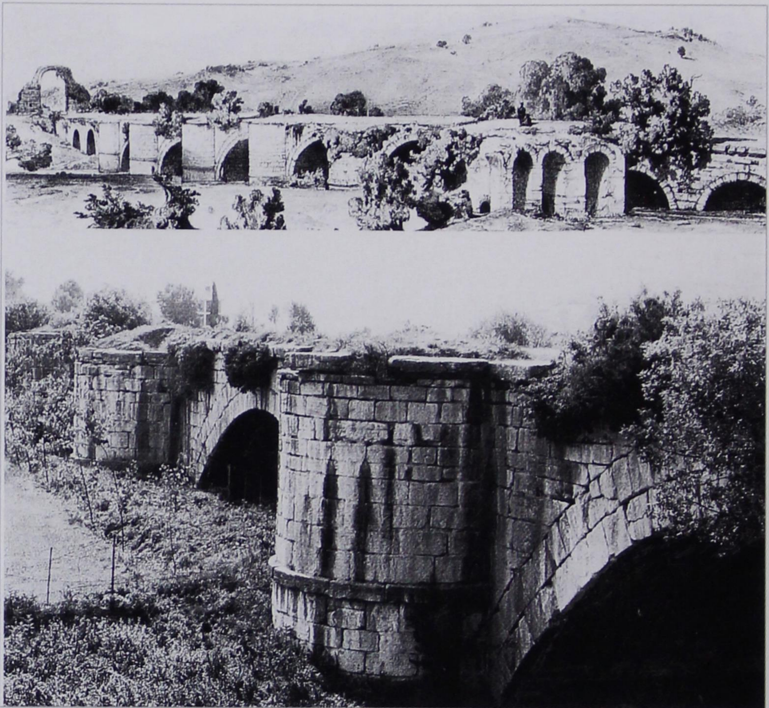
Εικ. 23. Γέφυρα Ιουστινιανού, περ. 560 μ.Χ. στο Σαγγάριο (Sakarya). Πάνω: χαρακτηριστική Charles Texier, έκδ. 1839. Κάτω σύγχρονη φωτογραφία: το ποτάμι έχει αλλάξει κοίτη. (: Cyril Mango, Byzantine Architecture , faber and faber / Electa, 1976, σ. 72). Σημειώνεται η διατήρηση των ολόλιθων ημικυκλικών ρωμαϊκών τόξων και η προσθήκη καμπύλων υψηλών εμβόλων προ των μεσοβάθρων.
