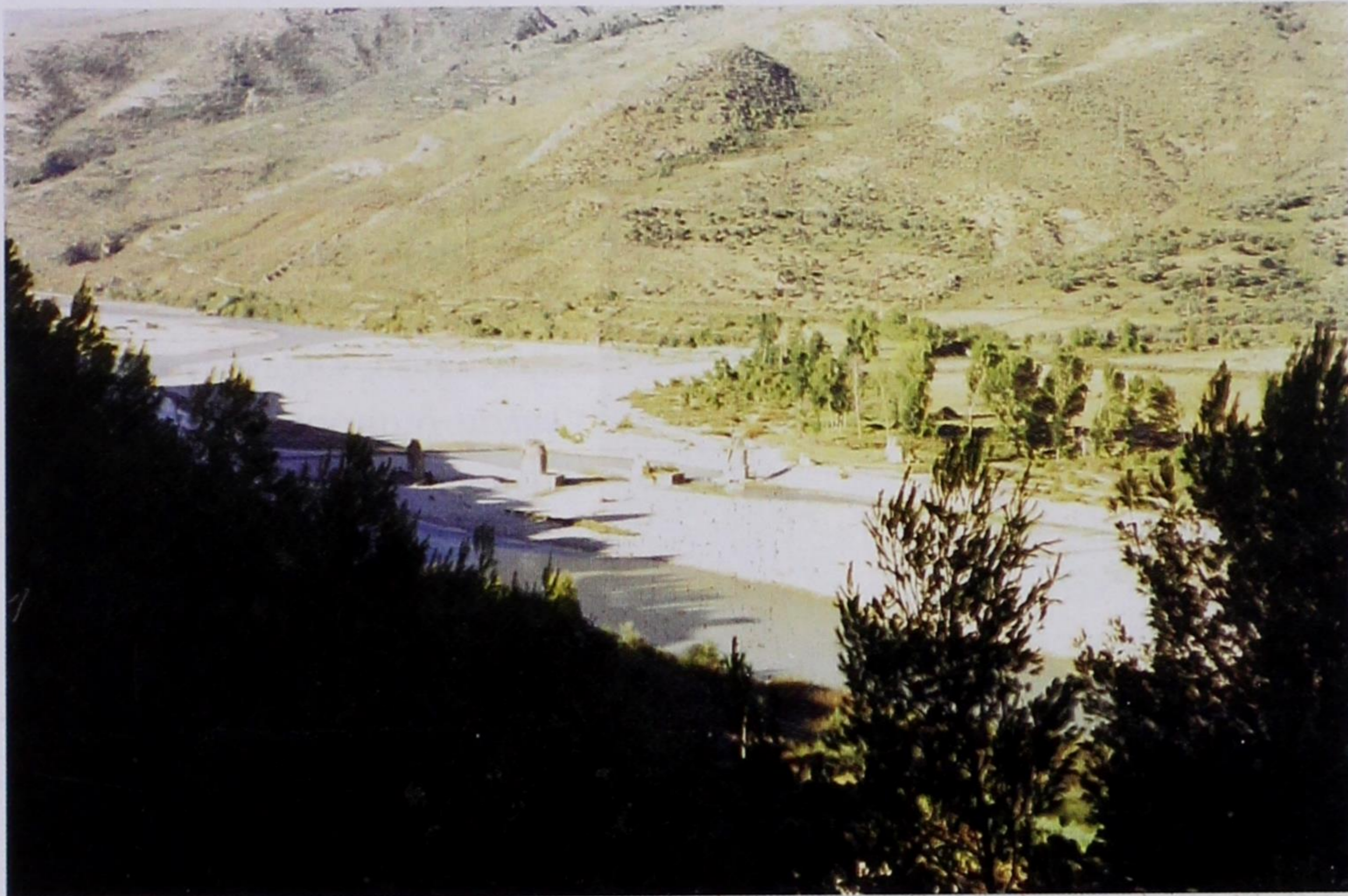
Εικ. 88. Ο Αώος κάτω από το Τεπελένι: στην κοίτη διακρίνονται βάρθρα πολύτοξης γκρεμισμένης γέφυρας. (Η αριστερά δασωμένη πλευρά είναι κλιτύς του εκεί φρουρίου του Αλή Πασά Τεπελενλή. Απέναντι οι υπώρειες του θρυλικού όρους Σεντέλι –υψομ. 1802 μ.– επέκταση της αιματοβαμμένης το 1940-1941 Τρεμπεσίνας –1929 μ. (Φωτ. 11 Σεπτ. 1995 Α.Π.: Φ. 95.IX/5, αριθ. 29).
