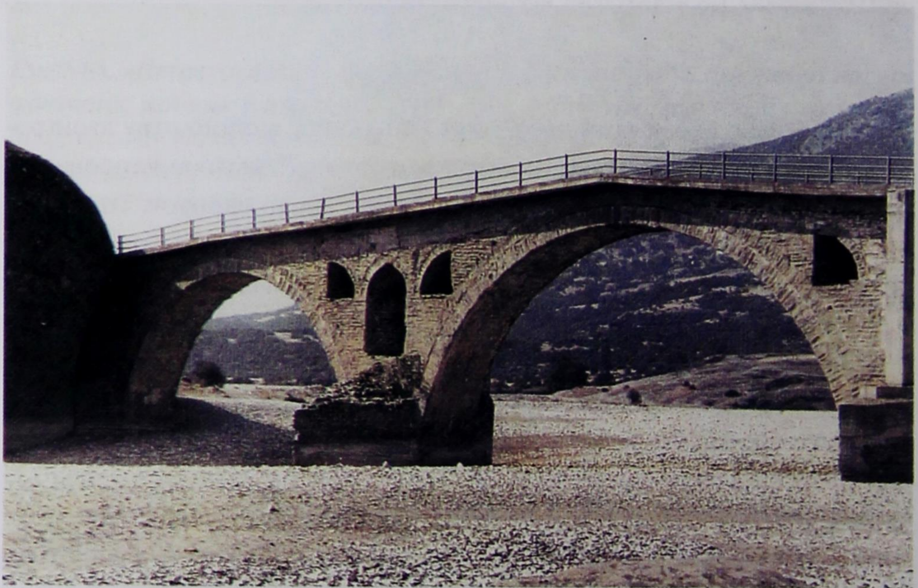
Εικ. 55. Γέφυρα Σαρακήνας, περιοχής Τρικάλων στον Πηνειό. Όψη από ανά- ντη. – Α' (επάνω): Φωτογραφία Δημ. Μιχαηλίδη θεωρούμενη του 1887. – Β' (κάτω): Λεπτομέρεια χαρακτηριστική μεσοβάθρου με 3 ανακουφιστικά τόξα, εξ ων τα δύο ιδιόμορφα τεταρτοκυκλικά. (Πηγή: Αντ. Γαλερίδης κ.Α. 1995, αντί- στοιχα σ. 199 / εικ. 159 και σ. 200 / εικ. 160).
