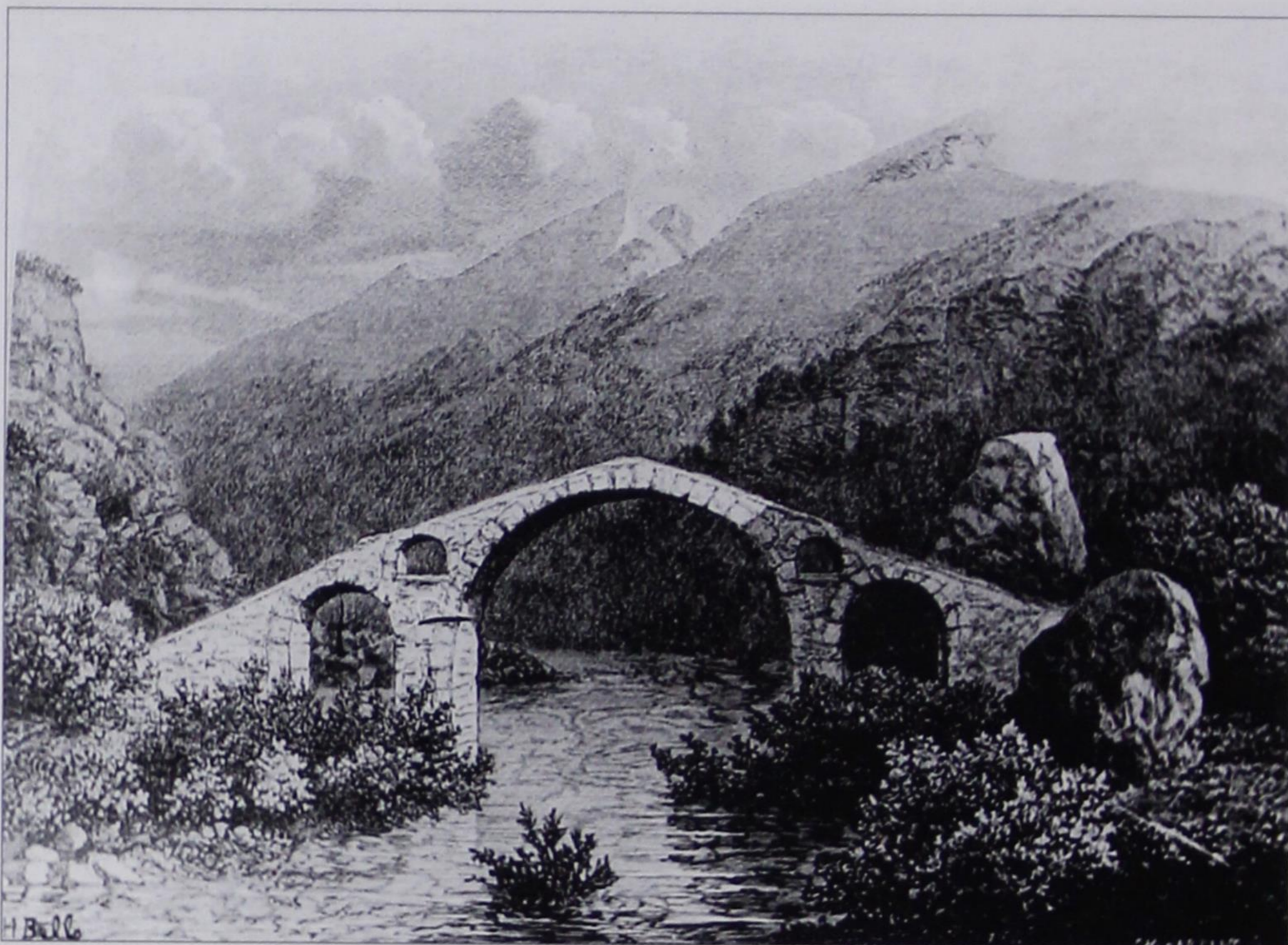
Εικ. 52. Η «Γέφυρα του Κόπανου» στον Ευρώτα (κοινώς ο «Ίρης») κοντά στη Σπάρτη. Στο σχέδιο εμφανίζεται παραπλανητικά τρίτοξη, γιατί το πράσινο καλύπτει το κάτω μέρος των 2 πλάγιων τόξων, που δεν ανοίγονται έως το φυσικό έδαφος. (Το σχέδιο του H. Belle, δημοσιευμένο 1881).
