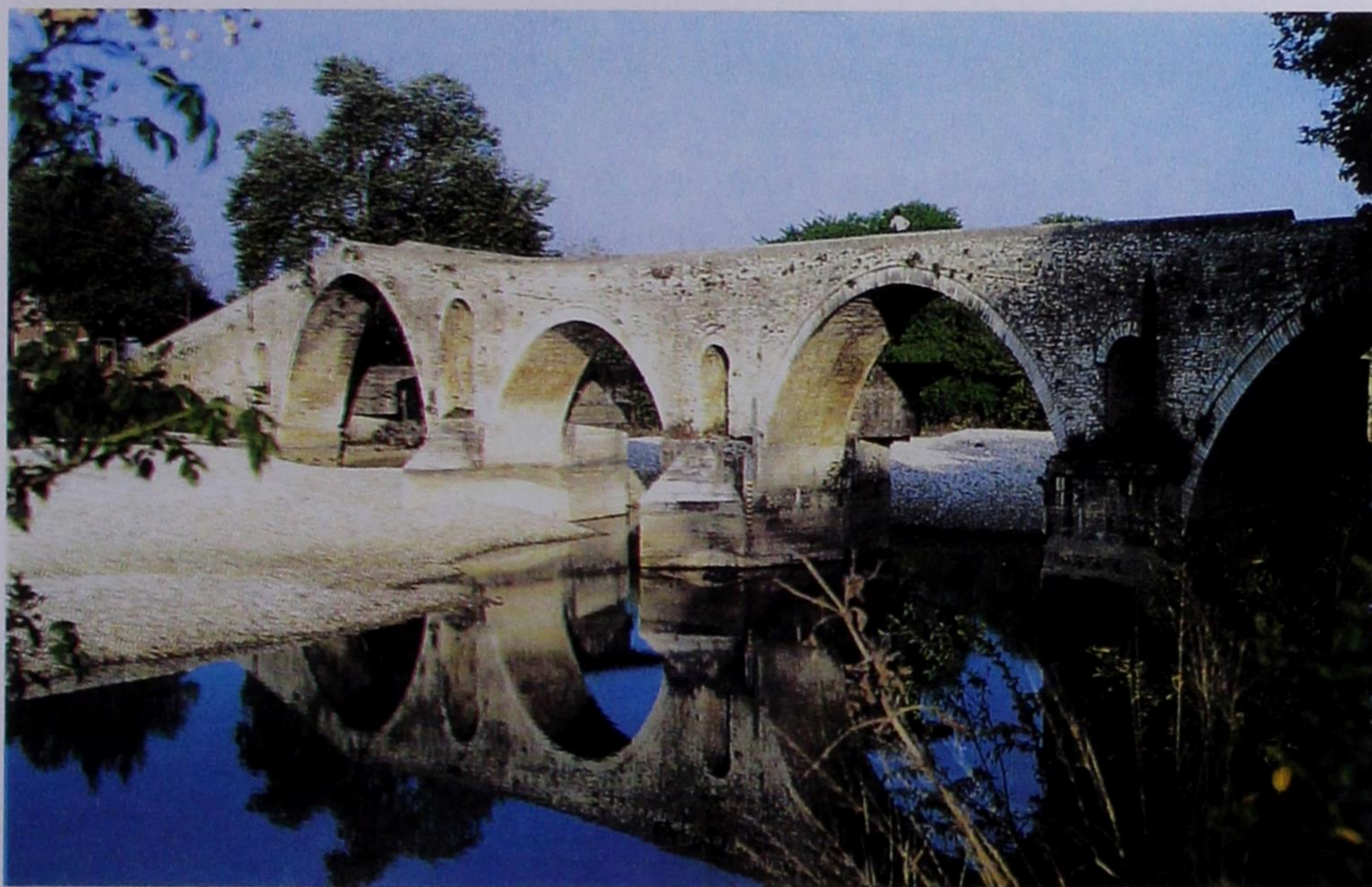
Εικ. 48. Το πολύτοξο γεφύρι της Άρτας στον Άραχθο ποταμό, με πρόβλους και ανακουφιστικά ανοίγματα στα βάθρα, 1602 ή 1608. (Παραλλαγή φωτ. Σπ. Ι. Μαντά, βλ. αντίστοιχη στο βιβλίο του: Ηπειρωτικά Γεφύρια , 1984, σ. 74, εικ. 26).
