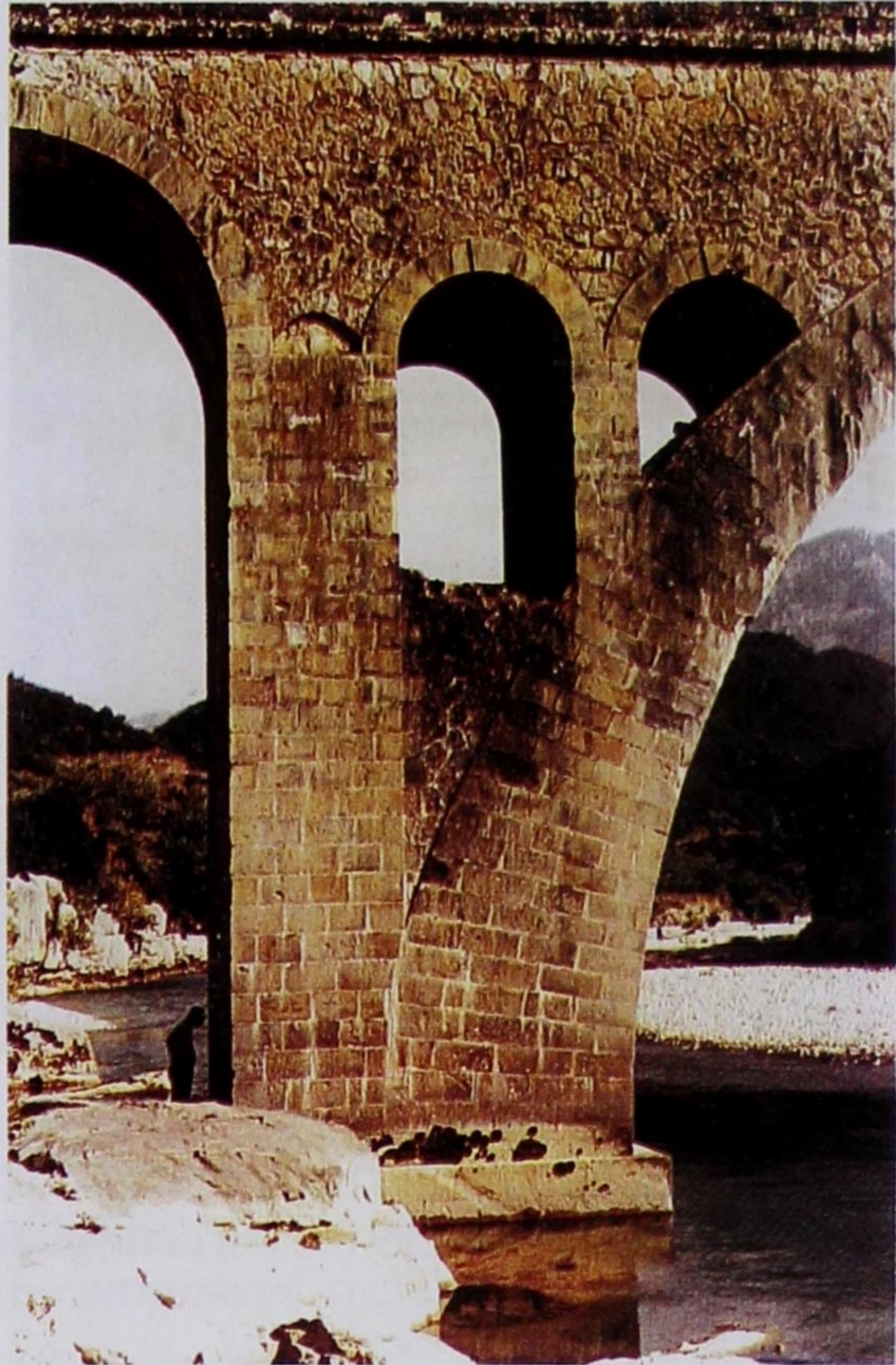
Εικ. 42. Γέφυρα Αυλακιού στον Αχελώο. Λεπτομέρεια μεσόβαθρου κύριου ανοίγματος. Εντυπωσιάζει η γρήγορα αυξανόμενη διατομή του τόξου προς τις γενέσεις. Ο μεσόστυλος των ανακουφιστικών τόξων συνδομείται με τους θολίτες. (Φωτ. Αντ. Γαλερίδης κ.Α., 1997, σ. 341 εικ. 287).
