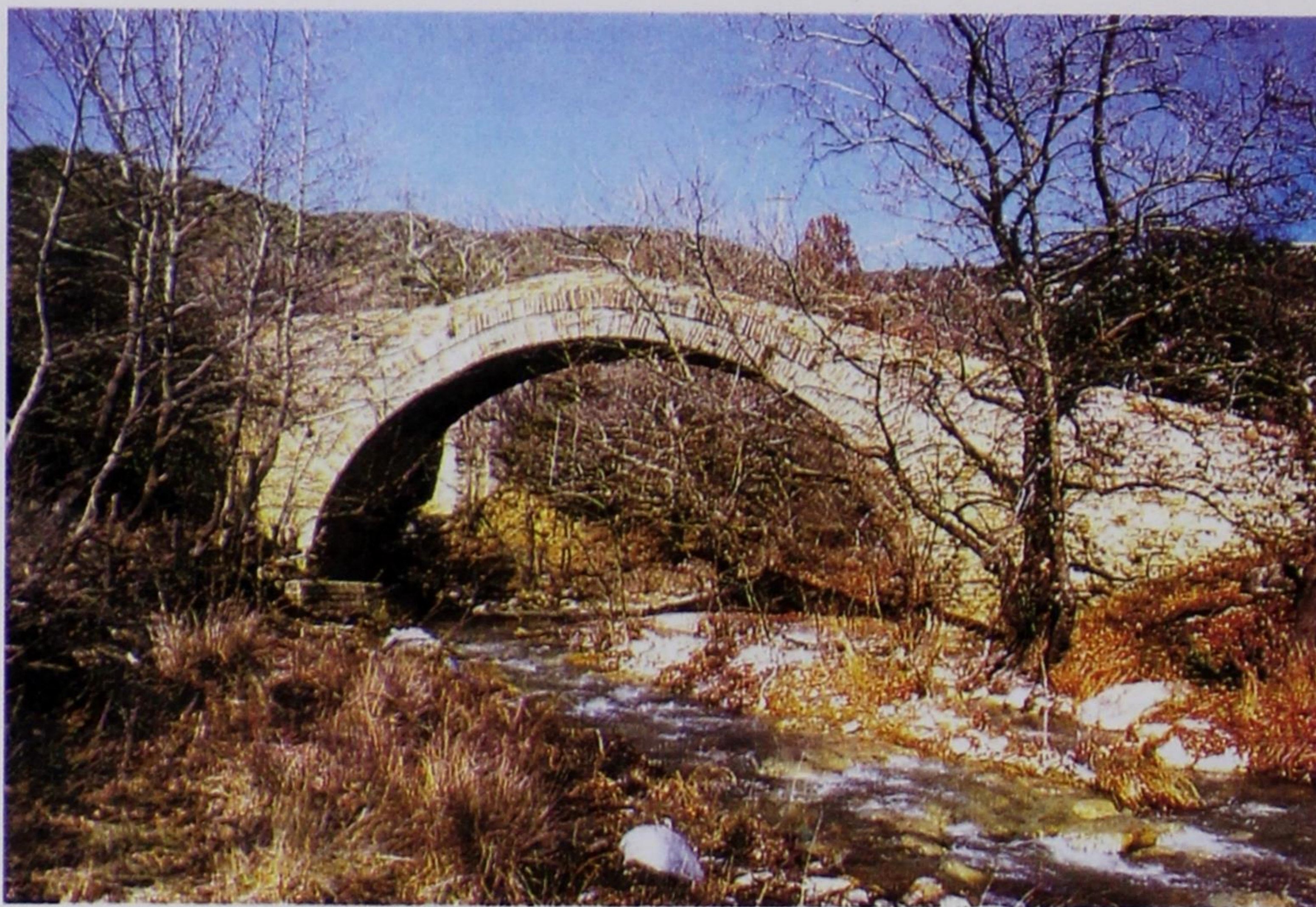
Εικ. 72Α. «Της Τοπόλ'τσας το Γεφύρι» κοντά στην Κόνιτσα, θέση «Μπούση» στο ομώνυμο ρέμα της Τοπόλιτσας, έργο 1903. Όψη από κατάντη. (Φωτ. περιοδικού «Κόνιτσα» τχ. 77 (1997) Σωτήρη Τουφίδη).
