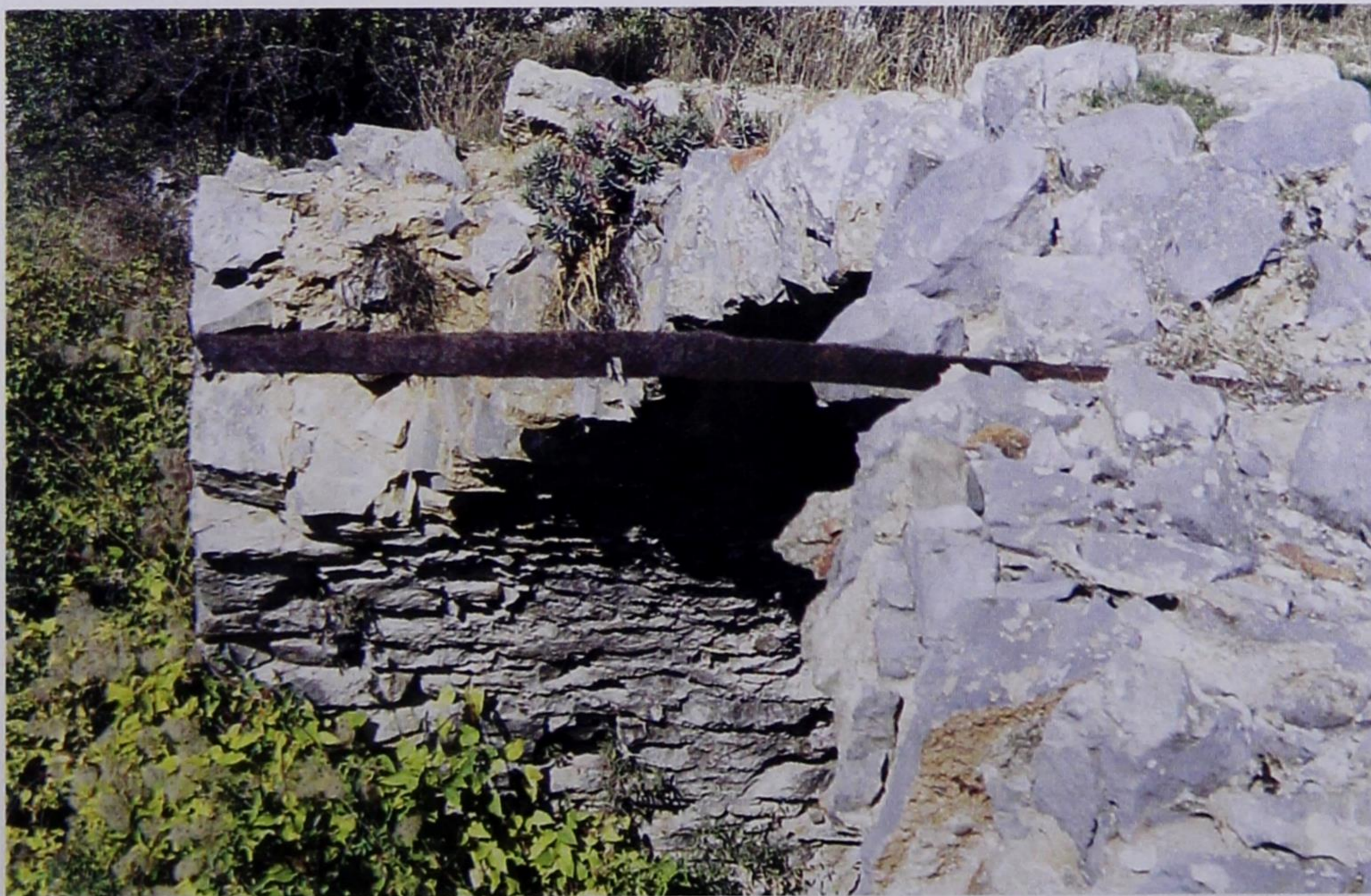
Εικ. 62Β. Ένας από τους δύο σιδερένιους ελκυστήρες του ισλαμίζοντος γεφυριού στον ποταμό Ελισσόντα του κάμπου της Νταβιάς (βλ. εικ. 62Α). (Φωτ. 5 Νοεμ. 1998, Α.Π.: Φ. 98. ΧΙ/1, αριθ. 12).
