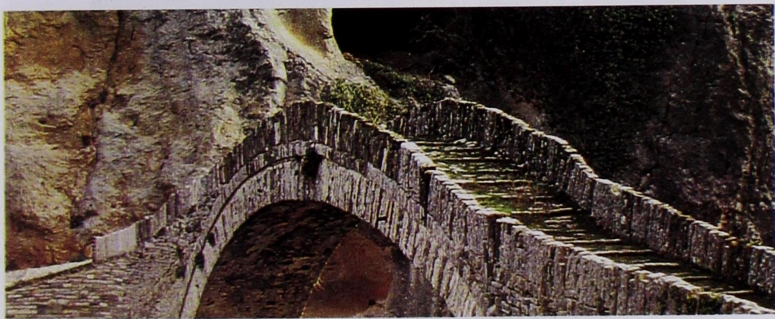
Εικ. 82Α και Β. Γεφύρι Νούτσου (ή Κόκορη μετά το 1910) στο Βίκο Ζαγορίου. Αρχική κατασκευή 1750. Ανακατασκευή 1768. Μεταγενέστερες επισκευές. Α' (επάνω) = Συνολική άποψη. Β' (κάτω) = Λεπτομέρεια κεντρικού στηθαίου. (Φωτ. Σπ. Ι. Μαντάς, Ηπειρωτικά Γεφύρια , 1984, σ. 93 εικ. 47).
