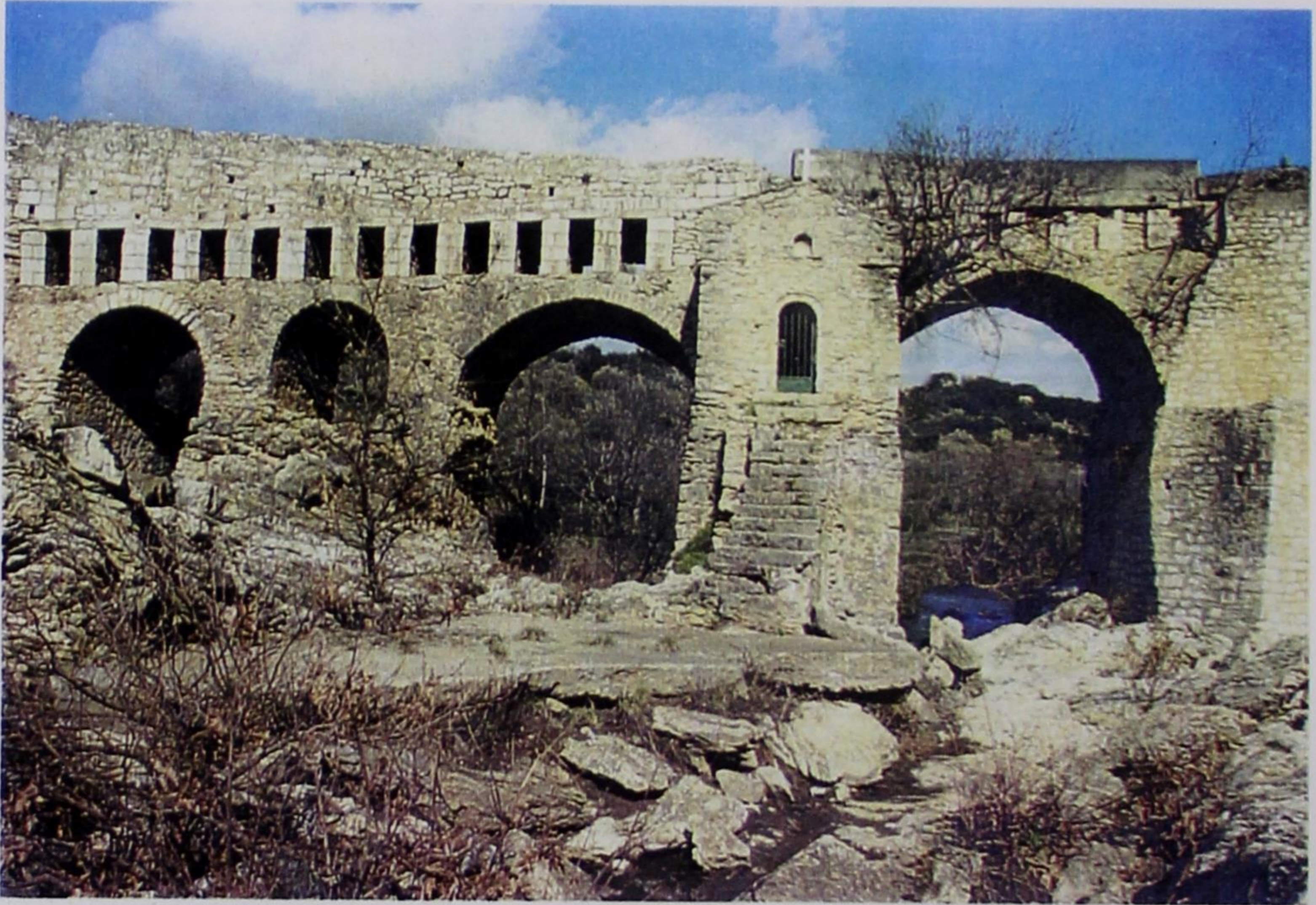
Εικ. 46. Η μεσαιωνική γέφυρα της Καρύταινας στον Αλφειό. Ανοικοδομήθηκε στα 1439/1440 επί βάθρων παλαιότερης φράγκικης του 13ου αι. Το ανώτερο, από τις θυρίδες και πάνω μέρος, είναι προσθήκη του 19ου αι. Όψη από τα κατάντη: διακρίνονται 4 τόξα: τα 3 κύρια από τα 5 της γέφυρας, και ένα μεγάλο ανακουφιστικό (= το δεύτερο από αριστερά) σε μεσόβαθρο πάνω σε βράχο, κυριαρχεί δε και το εκκλησάκι ερειδόμενο σε γειτονικό βάθρο (: Φωτογραφία 1970, †Γεωργίου Κομποχόλη (1905-1998), Τρίπολη).
