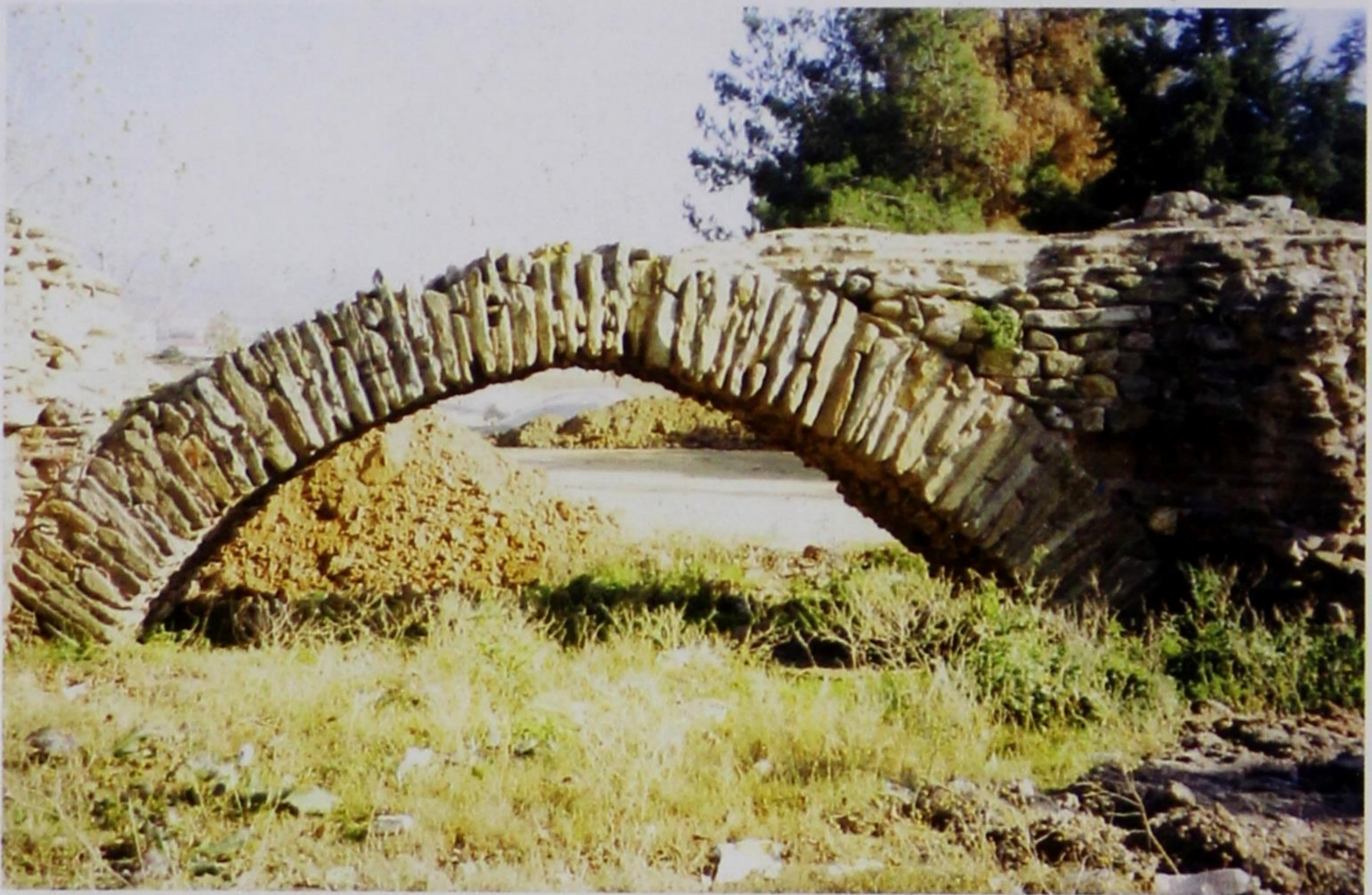
Εικ. 27. Πυλαία Θεσσαλονίκης, γειτονιά «Καπουτζήδες», θέση και γεφύρι «Καμάρα» (τώρα κι αυτό εκτός κοίτης). Λείψανο παλαιοχριστιανικής γέφυρας μάλλον του 5ου αι. μ.Χ. Παρατηρείται ότι το τόξο δεν είναι μόνο (ελαφρά) οξυκόρυφο, αλλά διακρίνεται τελικά σε τέσσερις καμπύλους κλάδους (φωτ.: 3 Δεκ. 1999, Φωτοθήκη Α.Π.: Φ.99.XI / τελ., αριθ. 20).
