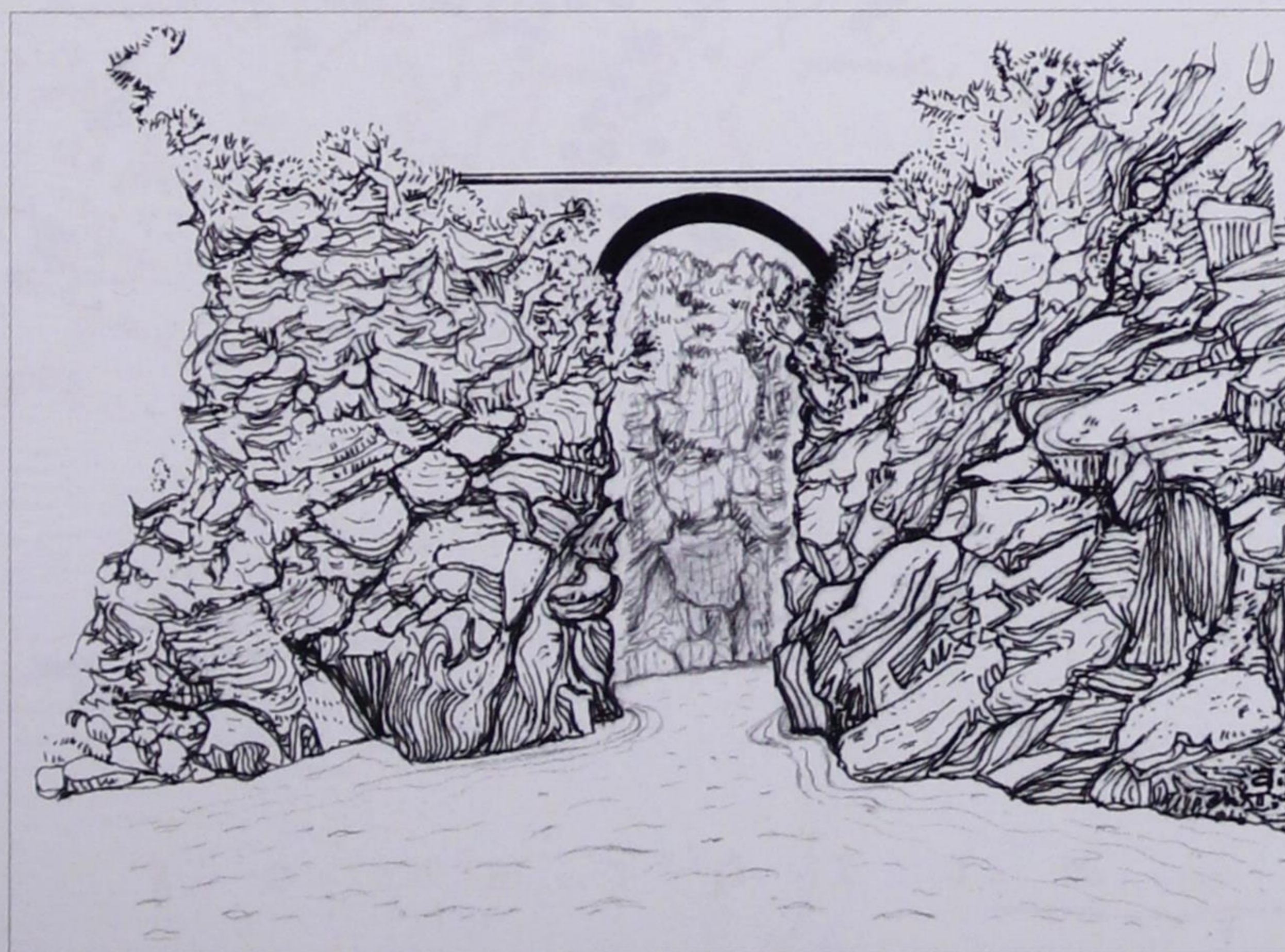
Εικ. 33. «Του Κούκου το Γεφύρι» ή του Βαλαβάνη, στον Αλφειό, πιο κάτω από την Καρύταινα, μεταξύ Βλαχόρραφτη - Θεισόας (πριν Λάβδα). Κατασκευάστηκε με τη μέριμνα βουλευτή Αθαν. Βαλαβάνη από το κράτος αντί δαπάνης 17.254 δραχ. επί έτους 1880, έργο θαυμαστό του Λαγκαδι(α)νού πρωτομάστορα Αντώνη Κάτσαινου, που —όπως λένε— στήριξε τη σκαλωσιά πάνω σε πάτωμα από σκοιινιά. (Ανασχεδίαση Α.Π. 31.ΧΙΙ.1999, από φωτογραφία στο «Λεύκωμα του Δήμου Γόρτυνος» 1910).
