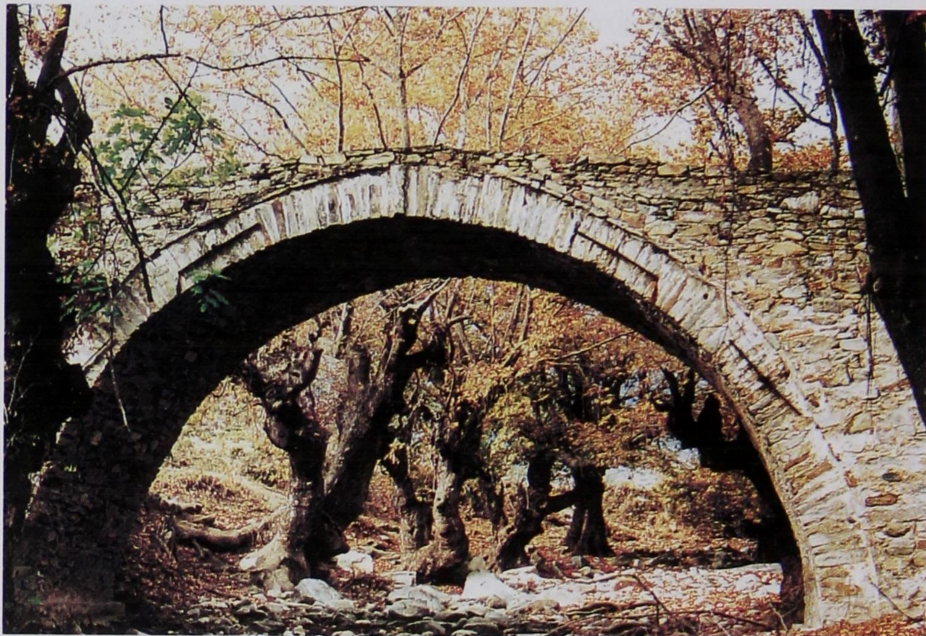
Εικ. 77. Γεφύρι Λεύκης Καβάλας· (βλ. εικ. 76). Το μεγάλο τόξο με τις εξαιρετικά μεγάλες 4 «άρπιζες». (Φωτ. 1996: Τσότσος Γ., 1997, σ. 181 εικ. 142).
