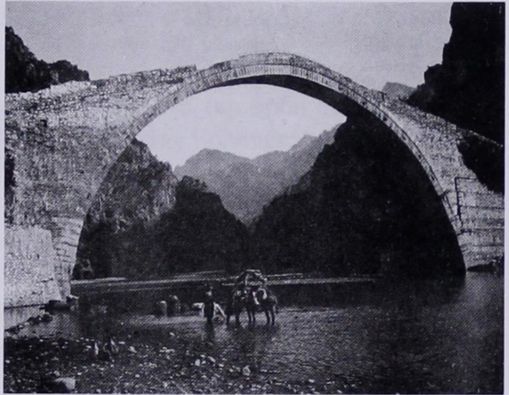
(Φωτ. 19-3) Η «γέφυρα Κόνιτσας» την εποχή του μεσοπολέμου. Όψη κατάντης. Διακρίνεται καλά σπηθαίο στην κορυφή και αριστερά. [Πηγή: Φωτογραφικό Αρχείο Εθνικής Πινακοθήκης, φωτογράφιση από τη Μαρία Χρυσάκη].
