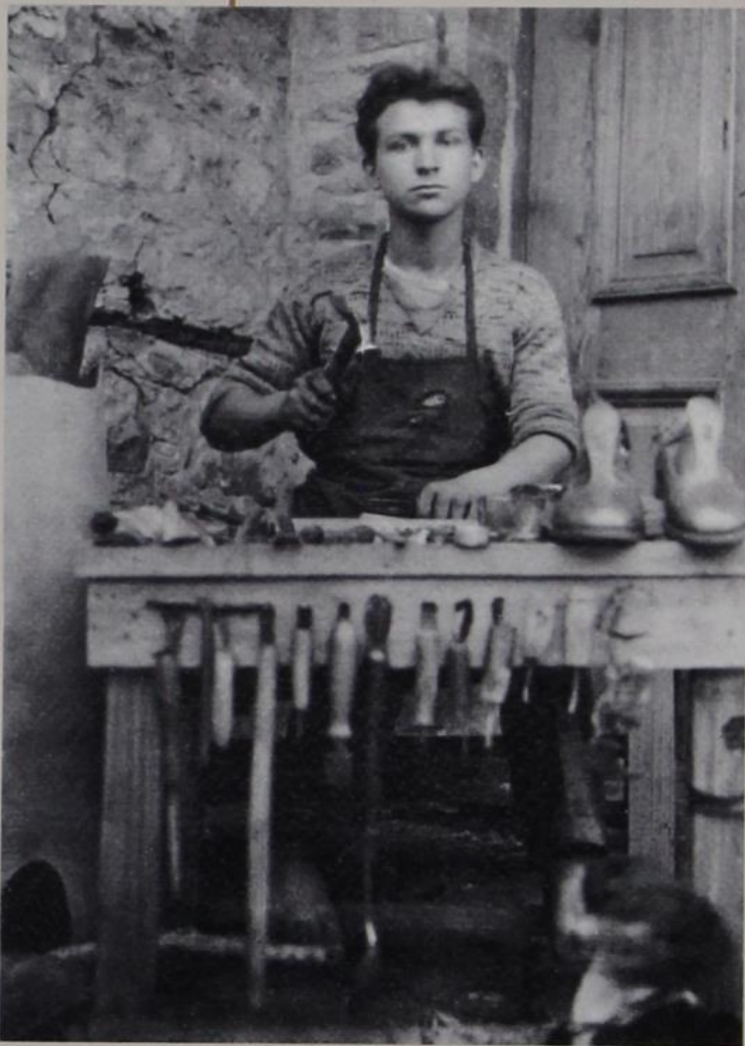
Τσαγκάρης εν ώρα εργασίας. Φωτ. αρχείο Ριζαρείου Ίδρυματος
