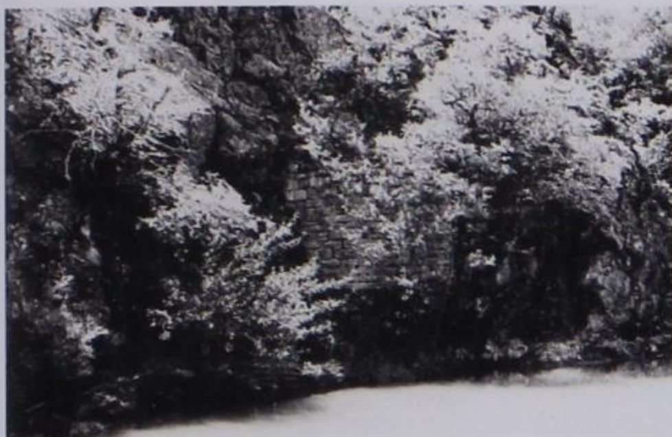
Φωτ. 1. Το ακρόβαθρο της «Γέφυρας Ζέρμας» στη θέση «Στόμιο», πάνω στη βραχώδη αριστερή όχθη (σκάλα) προς το βουνό «Κούτσουρο». Λήψη από Θωμά Β. Ζιώγα, τον Αύγουστο του 1994.
