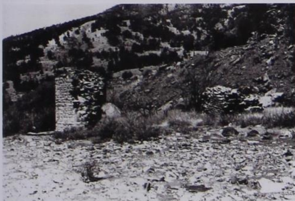
Φωτ. 2. Τα παλιά μεσόβαθρα της «Γέφυρας Ζέρμας» στη θέση «Στόμιο», προς την όχθη του βουνού «Μπουχιέτσι». Λήψη από τον Θωμά Β. Ζιώγα, τον Αύγουστο του 1994.
