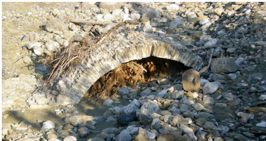
Φωτ. 1: Το μεσόβαθρο και το τόξο της «γέφυρας Βουργοπόταμου», θέρους του 2011. (Λήψη από τον Παναγιώτη Δήσιο, την 13-08-2011).
