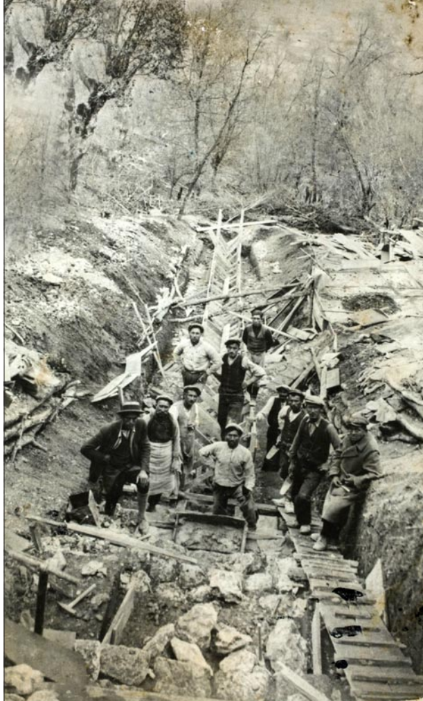
1929. Θεμελίωση γέφυρας στη θέση Συμέλη στο 44 ο χιλιόμετρο της σιδηροδρομικής γραμμής Καλαμπάκας - Βέροιας.
