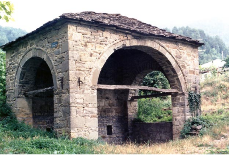
Το τρικάμαρο «Περατινό πηγάδι» στις παρυφές του Γαναδιού. [Πηγή: Αρχείο Θωμά Β. Ζιώγα, λήψη 1995]. Λήψη 1995].
