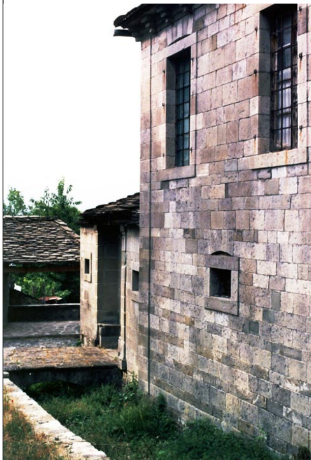
Ισόδομη λαξευτή πρόσοψη οικίας Γ. Γιούτσου στο Γαναδίό. [Πηγή: Αρχείο Θωμά Β. Ζιώγα, λήψη 1995].
