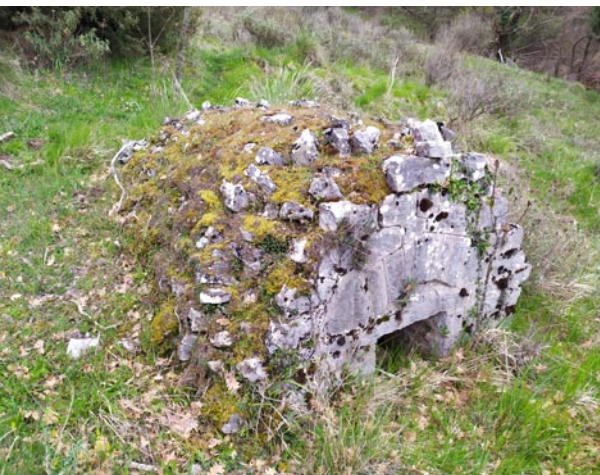
Φωτ 8. Καζάνι (φρεάτιο) παλιότερου συστήματος ύδρευσης.
