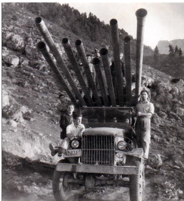
Φωτ 7. Μεταφορά των σωλήνων του έργου αποκατάστασης ύδρευσης της Κόνιτσας, 1949.
