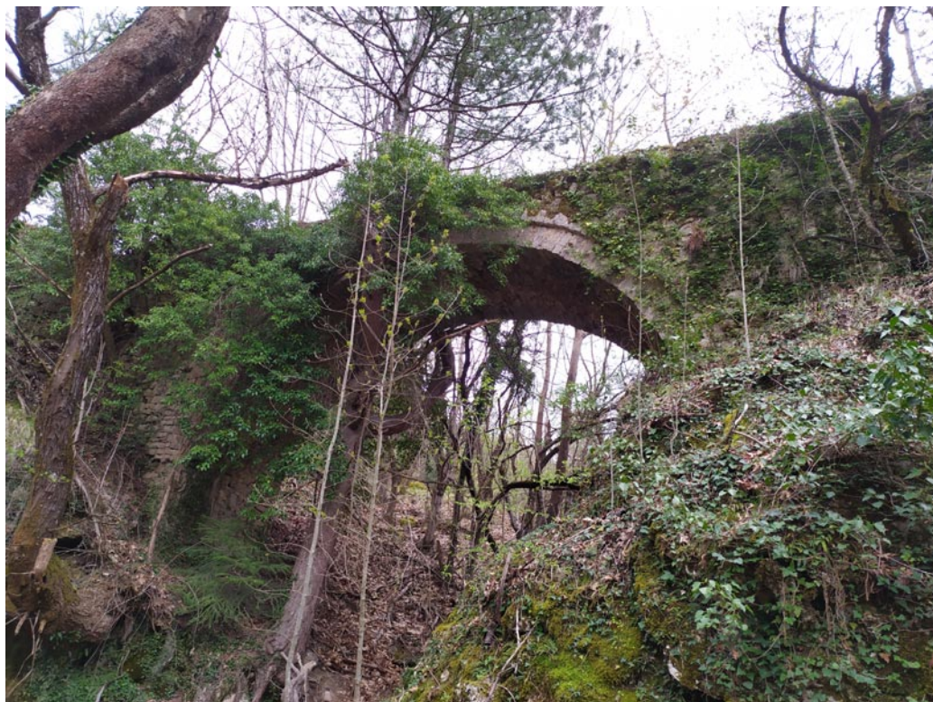
Φωτ 1. Το γεφύρι του Αη Νικόλα σήμερα εκ των κατάντη.
