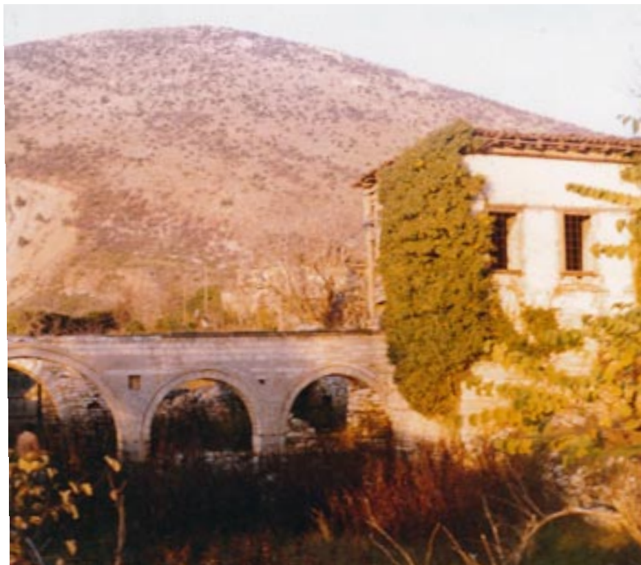
Το κυρίως οίκημα (δεξιά) και τα ερείπια του μπροστινού κτηρίου (αριστερά) στο οποίο ήταν ενσωματωμένη η είσοδος (αυλόθυρα) του αρχοντικού Ελμάζ Μπέη). Διακρίνεται, ανάμεσα από τις καμάρες, θέση που προφανώς υπήρχε κτπορική (ή άλλη) επιγραφή, η τύχη της οποίας αγνοείται (1976).
