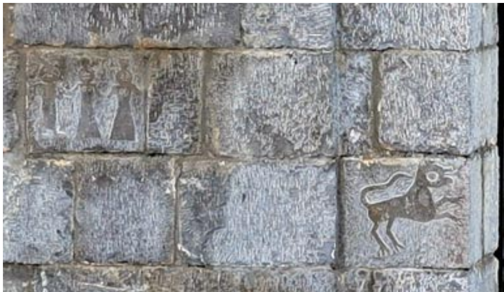
Λεπτομέρεια των τοίχων στήριξης της αψίδας του ναού του Αγίου Νικολάου (αριστερό σκέλος). Διακρίνονται τα δύο λιθανάγλυφα (δρακόμορφο ζώο και χορός γυναικών) (2021).
